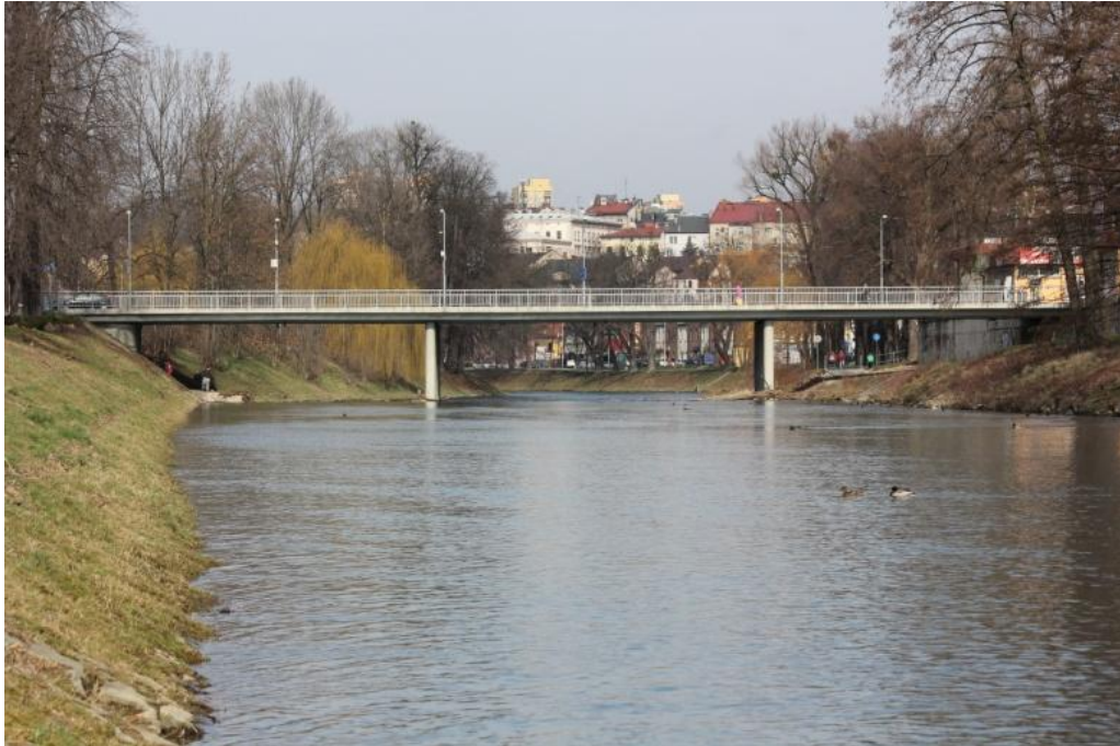
Obr. 14 Silniční most ř. km 37.932
