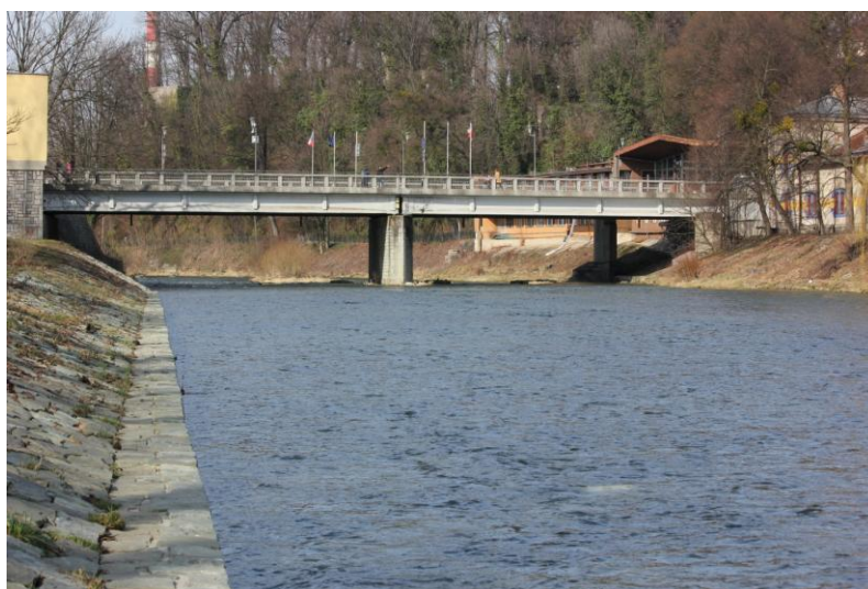
Foto 8 Silniční most s jedním středovým pilířem ř. km 37.174
