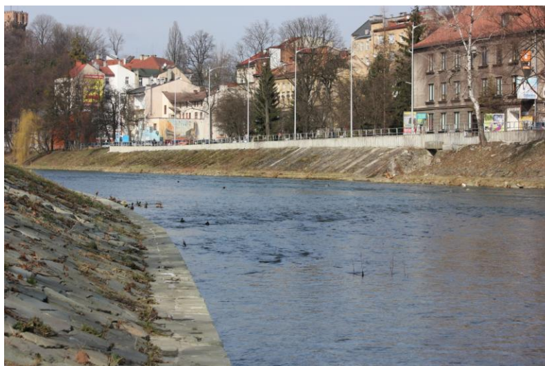
Foto 10 Opěrná zídka nad silničním mostem, pravý břeh, ulice Aleja Jana Lyska
