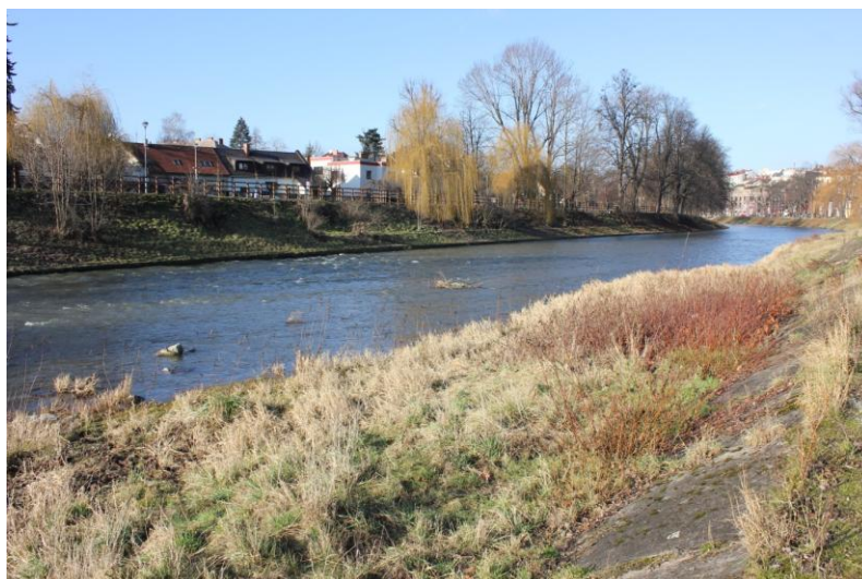
Foto 16 Zarostlá část koryta Olše pod silničním mostem ř. km 37.932
