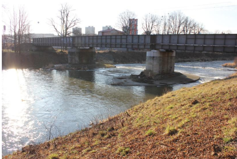
Foto 1 Železniční most ř. km 36.502, začátek řešeného úseku
