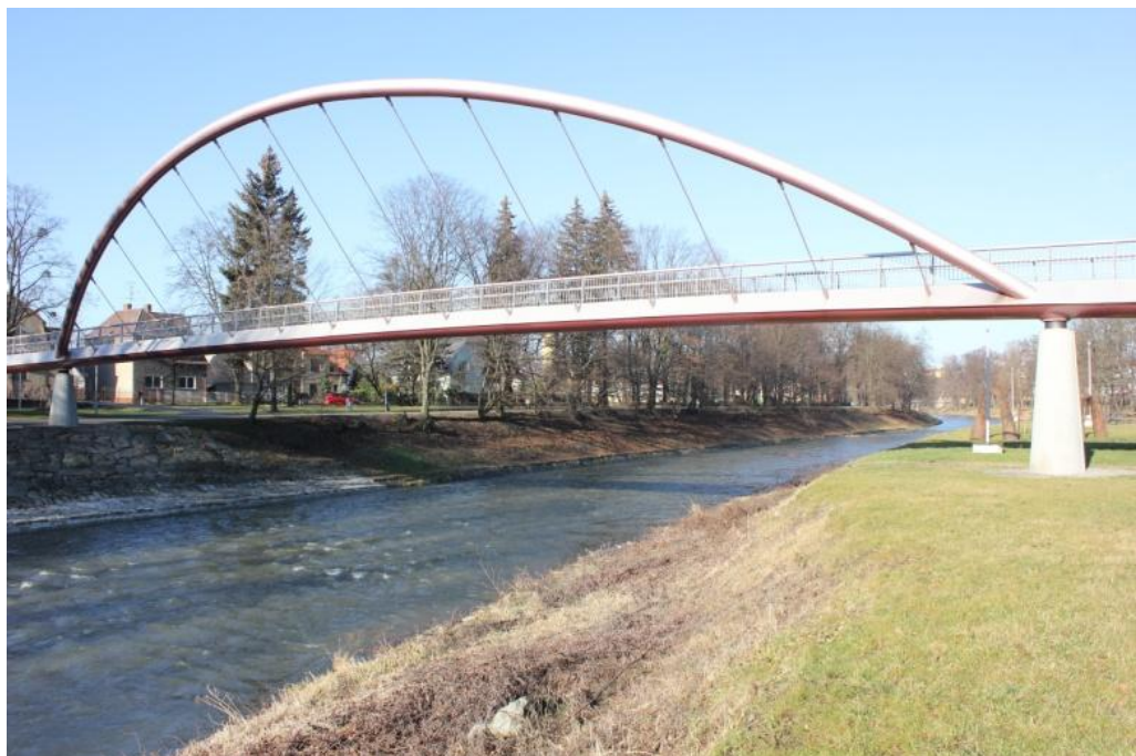
Obr. 15 Lávka pro pěší ř. km 38.529
