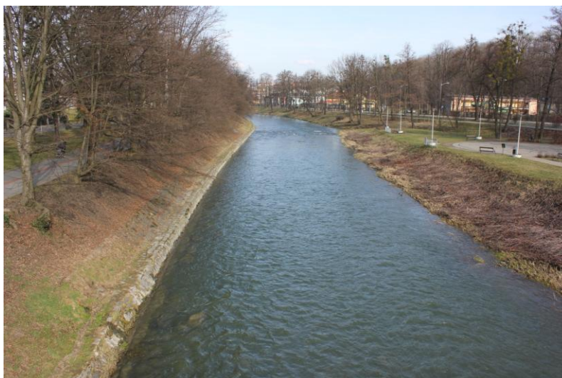
Foto 22 Ř. km 38.529 pohled z lávky po vodě
