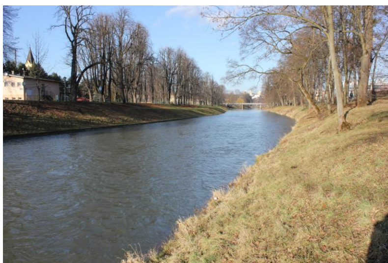
Foto 18 Ř. km 38.450 úsek pod zaústěním Puncówky
