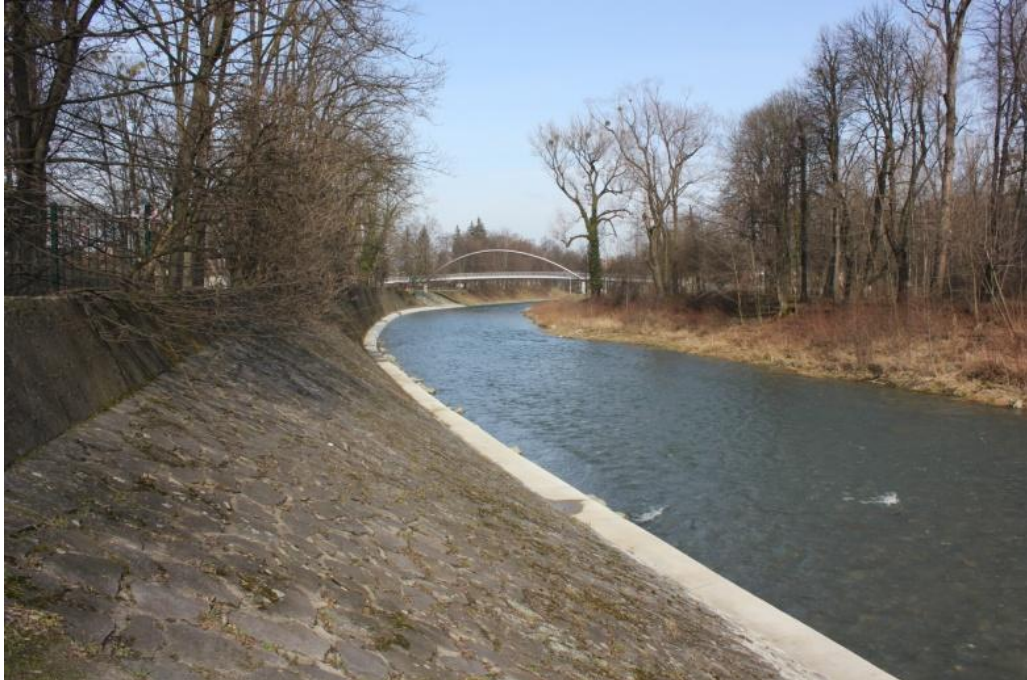
Obr. 7 Pohled na koryto v horní části úseku
