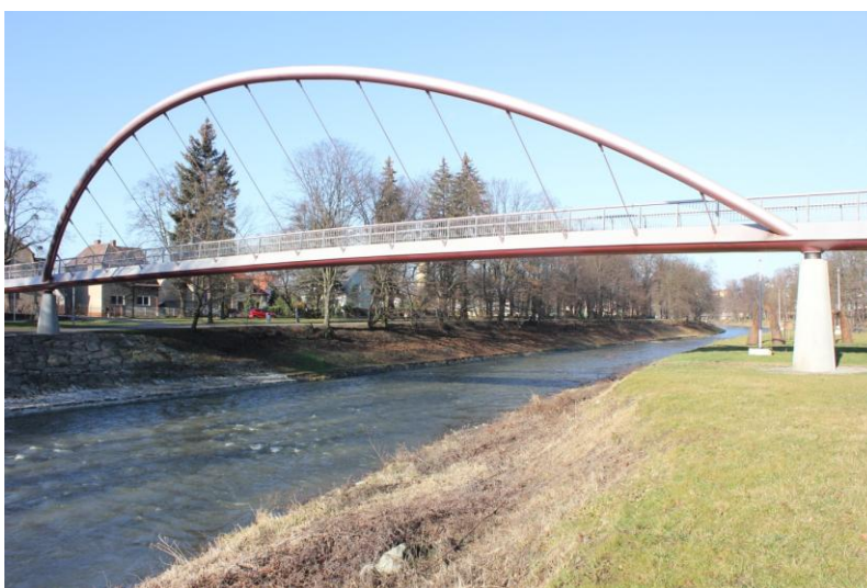
Foto 23 Ř. km 38.500 29 lávka pro pěší
