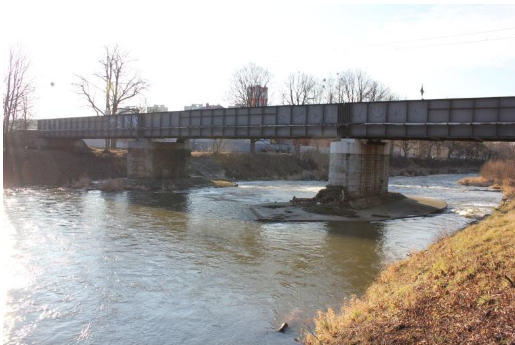
Obr. 11 Železniční most ř. km 35.502
