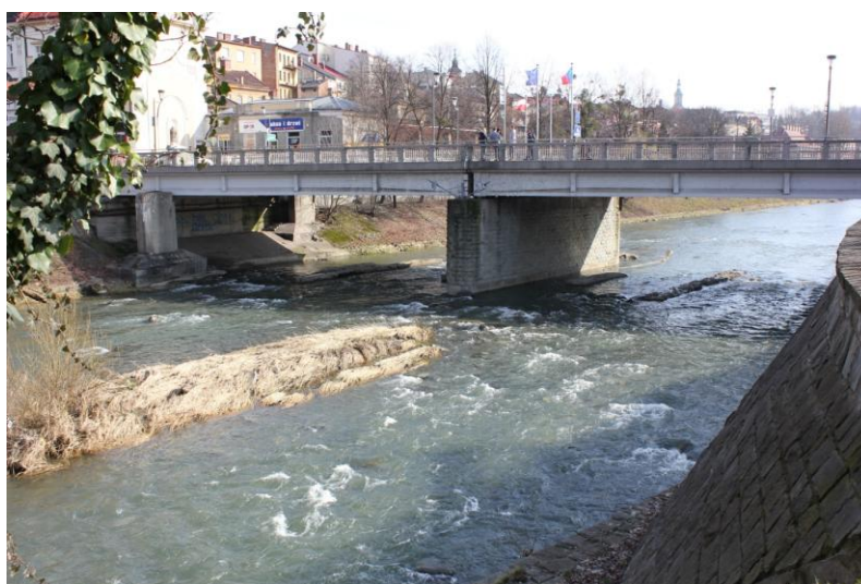
Foto 6 Pozůstatky pilířů pod silničním mostem (ř. km 37.174), pohled proti vodě
