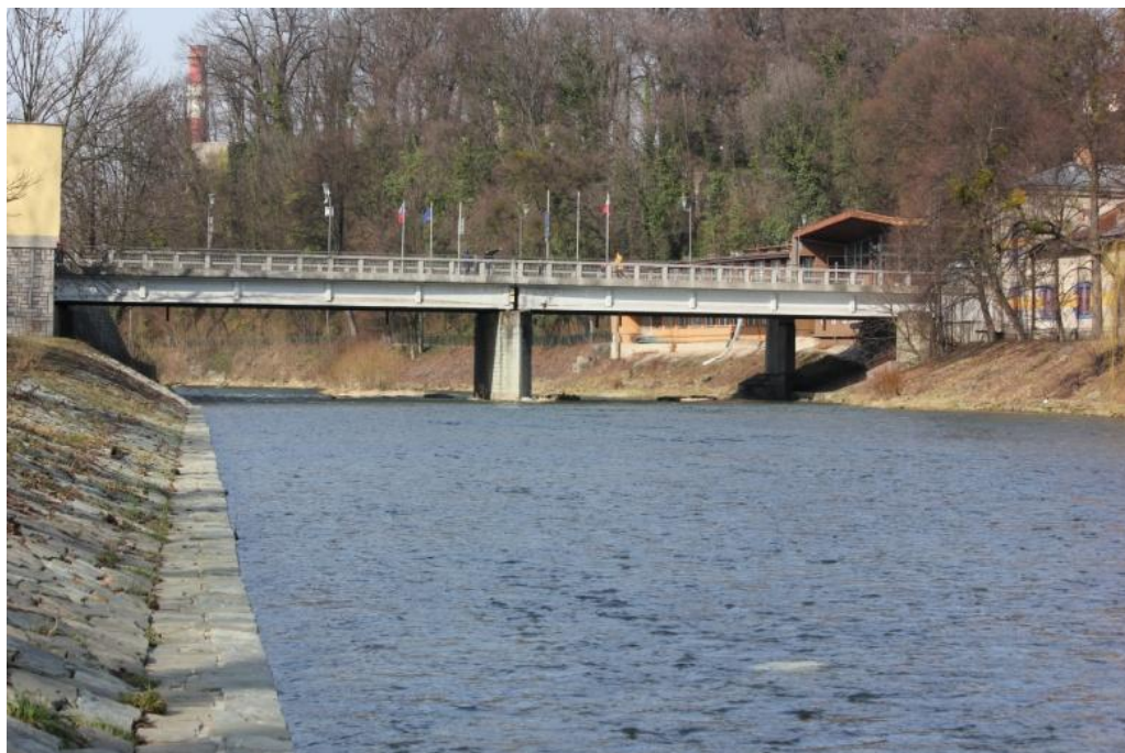
Obr. 12 Silniční most ř. km 37.174
