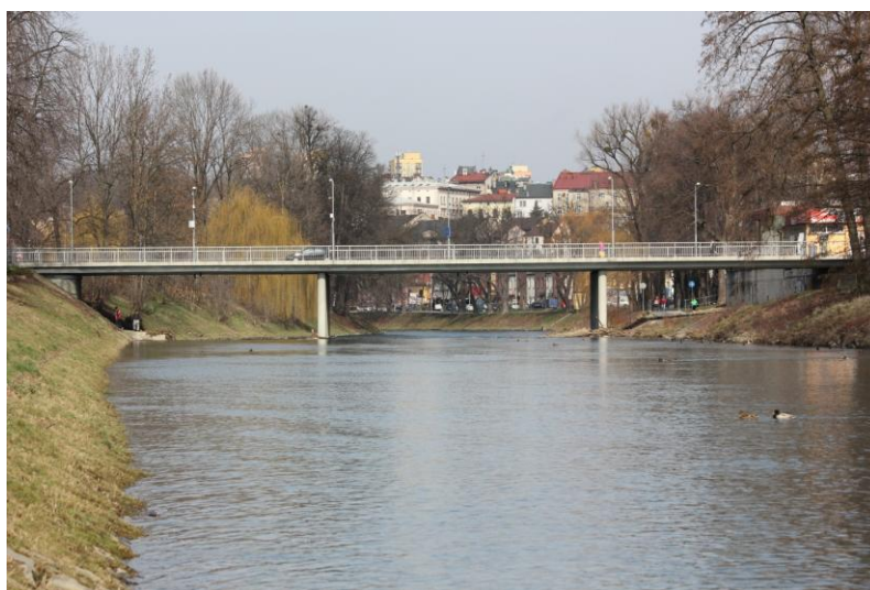
Foto 17 Ř. km 37.932 silniční most se dvěma pilíři
