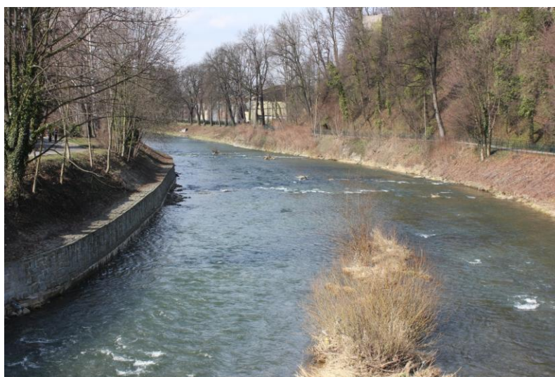
Foto 5 Úsek pod silničním mostem (ř. km 37.174)
