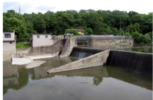
Obr. 3 Jez sloužící k zásobení Třineckých železáren užitkovou vodou [9]
