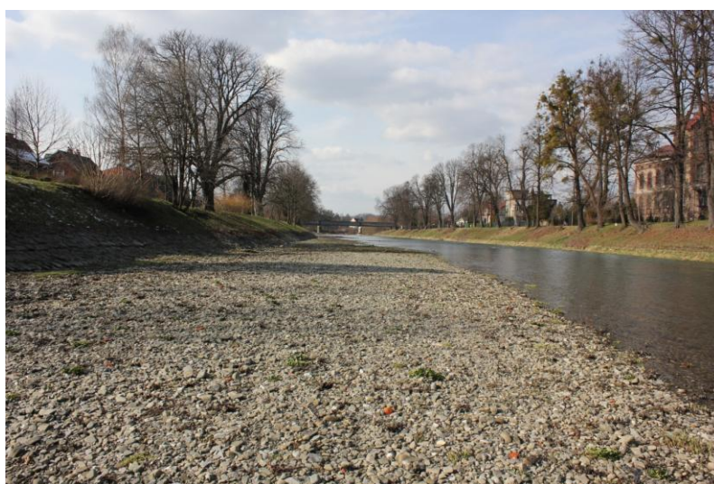
Foto 3 Ř. km 36.800 zanesená část koryta Olše
