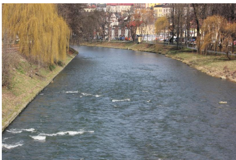
Foto 15 Ř. km 37.932 pohled ze silničního mostu
