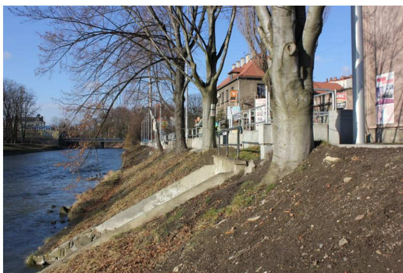
Foto 9 Opěrná zídka na ulici Aleja Jana Lyska, pohled z pravého břehu
