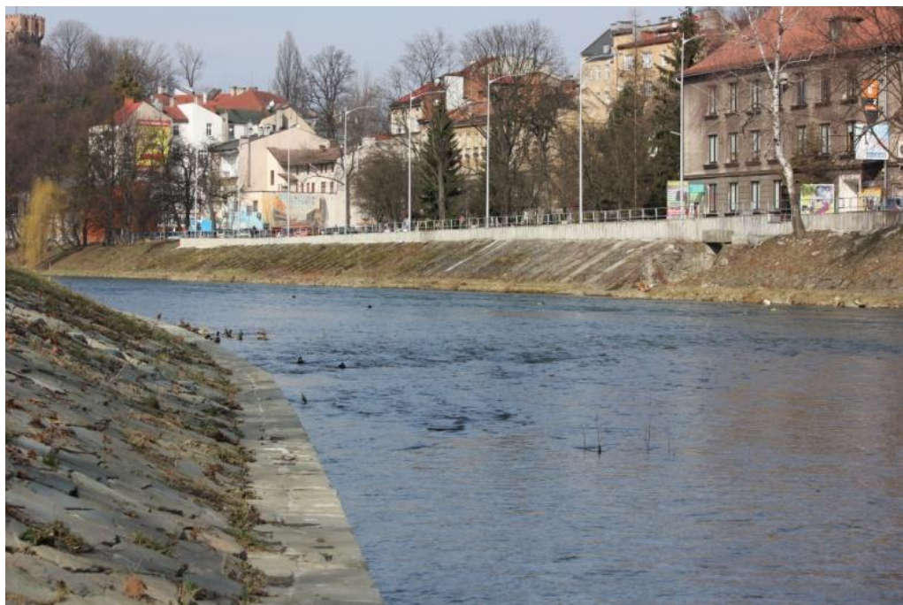
Obr. 31 Opěrná zeď podél ulice Aleja Jana Lyska
