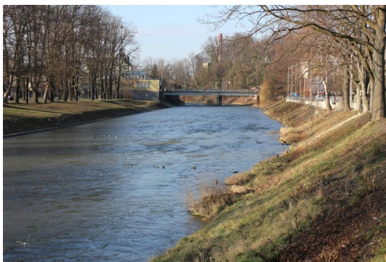
Foto 11 Pohled na silniční most ř. km 37.174
