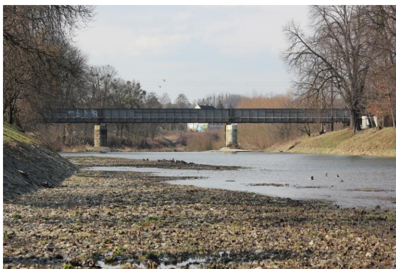
Foto 2 Pohled na železniční most ř. km 36.502
