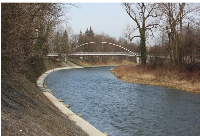
Foto 24 Ř. km 38.800 úsek pod zaústěním Sadového potoka
