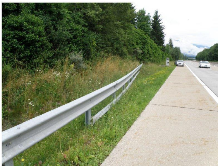
Obrázek 11: Zapuštění svodidla do svahu (TP 203a, str. 46)
