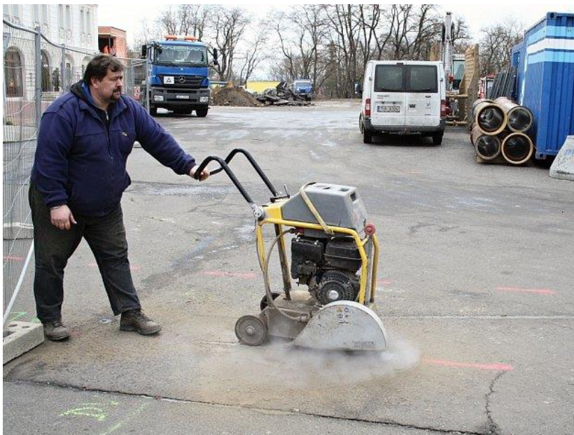
Obrázek č. 10: Úprava povrchů v rámci rekonstrukce původního AN [7]
