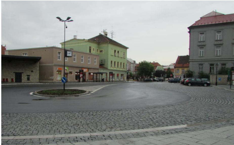
Obrázek č. 24: Sloup osvětlení osazený kamerovým systémem a hodinami(foto autor)
