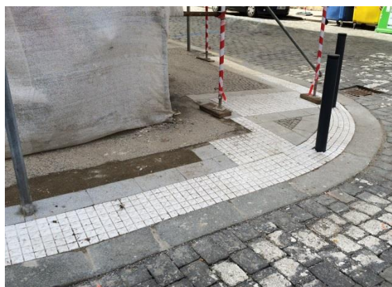
Obr. P89 – Detail hmatových úprav
