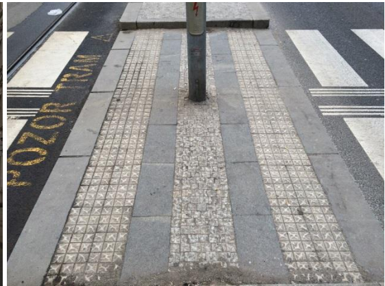
Obr. P66 – Detail hmatových úprav
