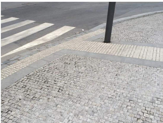
Obr. P54 – Detail hmatových úprav
