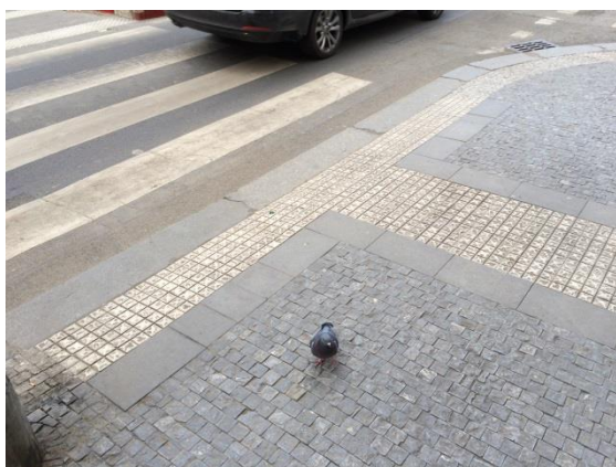
Obr. 10 – Varovný pás v kombinaci se SP u PpCH
