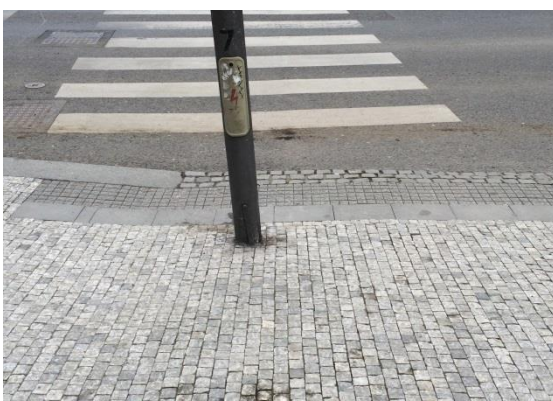
Obr. P57 – Detail hmatových úprav
