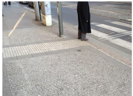
Obr. P28 – Detail hmatových úprav
