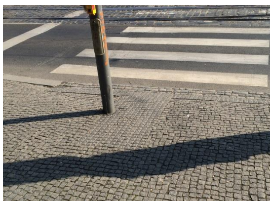
Obr. P33 – Detail hmatových úprav
