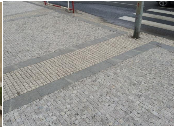
Obr. P62 – Detail hmatových úprav
