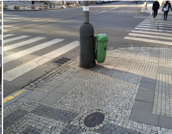
Obr. P48 – Detail hmatových úprav
