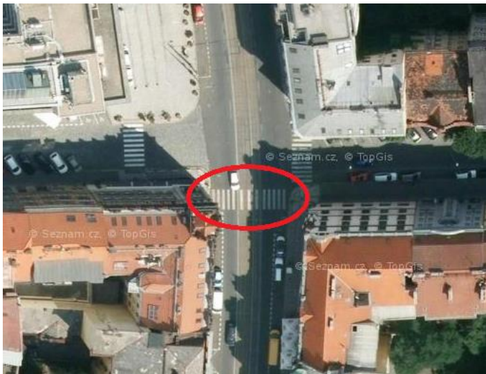
Obr. 65 – Přečhod č. 17: Letecký snímek, zdroj [14]
