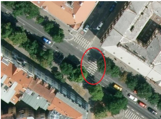
Obr. 35 – Přečhod č. 1: Letecký snímek, zdroj [14]
