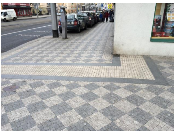
Obr. 8 – SP, dovedení k vodící linii
