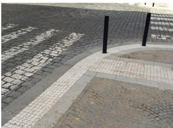
Obr. P88 – Detail hmatových úprav
