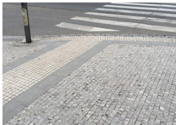
Obr. P56 – Detail hmatových úprav
