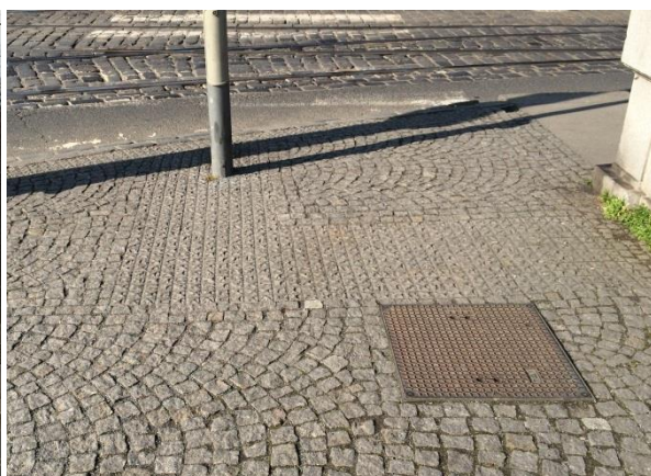
Obr. P32 – Detail hmatových úprav
