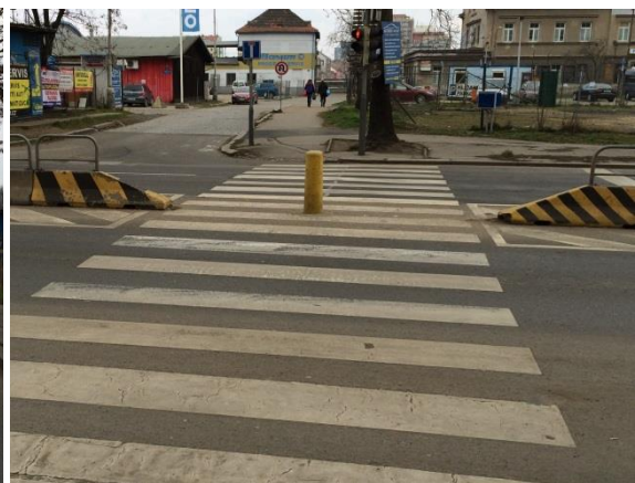
Obr. P39 – Detail ochrany chodců bet. svodidly
