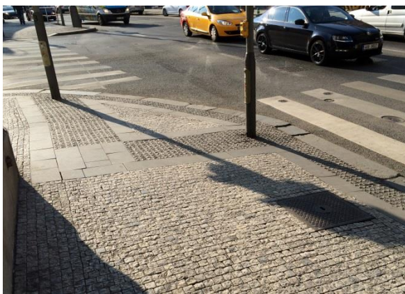
Obr. P86 – Detail hmatových úprav
