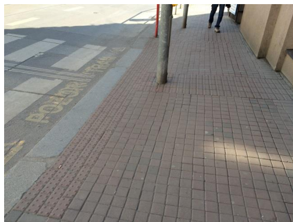
Obr. P13 – Detail hmatových úprav
