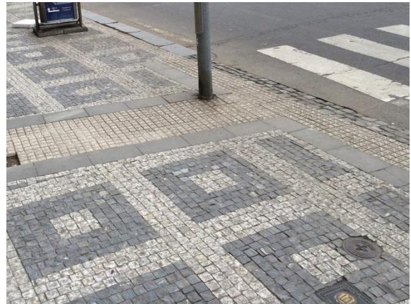
Obr. P53 – Detail hmatových úprav
