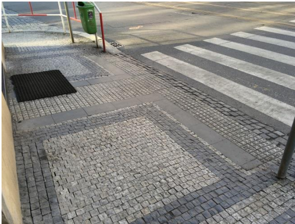
Obr. P47 – Detail hmatových úprav
