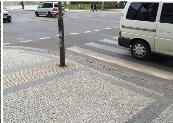
Obr. P50 – Detail hmatových úprav
