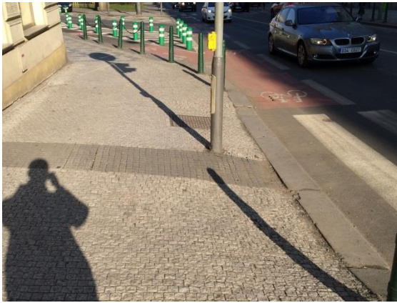
Obr. P60 – Detail hmatových úprav
