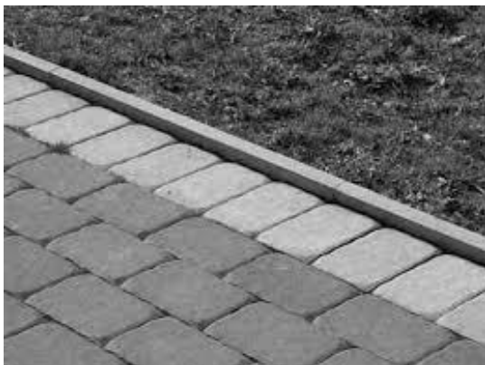
Obr. 6 – PVL obrubník min 60 mm, zdroj [6]
