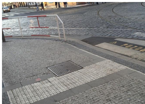
Obr. P30 – Detail hmatových úprav - poklop
