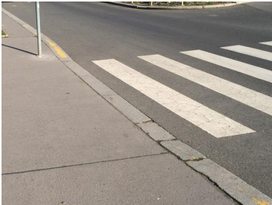
Obr. P36 – Detail obrubníku
