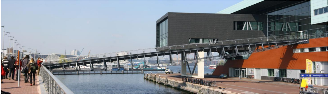
obr. 5 Lávka u muzea Muziekgebouw aan v Amsterdamu [14]
