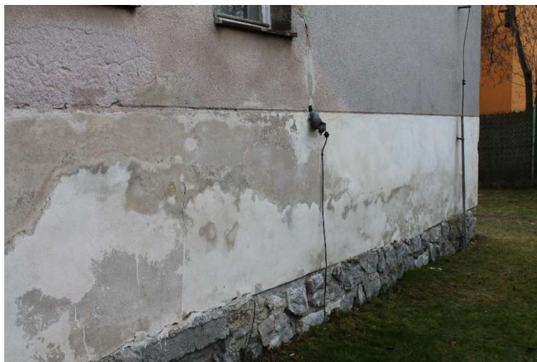
Obrázok 10 Vlhkostné mapy na obvodovom murive [3]
