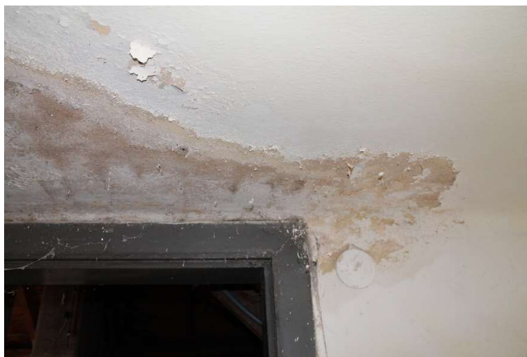
Obrázok 9 Vlhkosťná mapa na strope pod plochou strechou [7]
