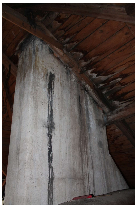
Obrázok 13 Napadnutie debnenia hnilobou [3]
