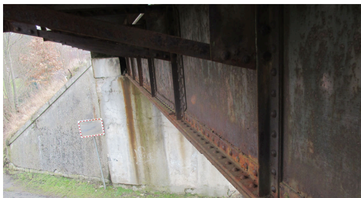
Obr. 2.9: Pohľad na ľavý nosník
