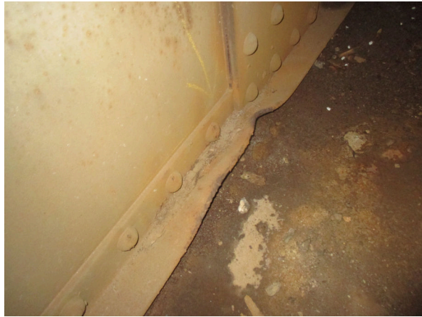
Obr. 5.2: Vybočená dolná pásnica priečniku (1)
