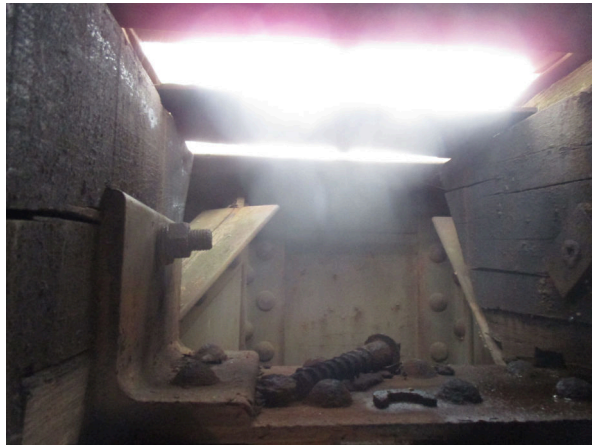
Obr. 2.15: Drevené podložky a odpadnutá skrutka
