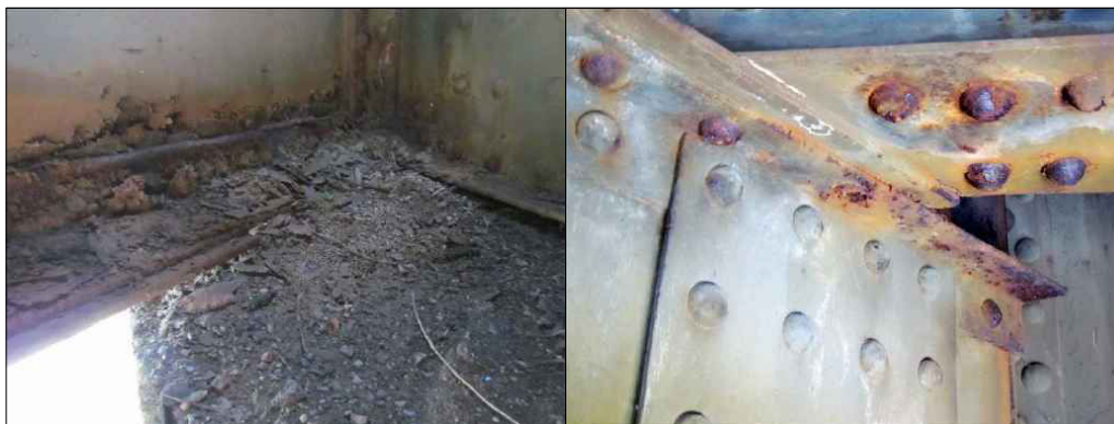
Obr. 2.7: Zanesené ložiská a odstrelená hlava nítu-ľavý pozdĺžnik
