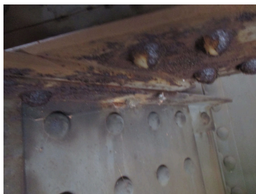
Obr. 2.8: Prehrdzavené nity a chýbajúca hlava-pravý pozdĺžnik
