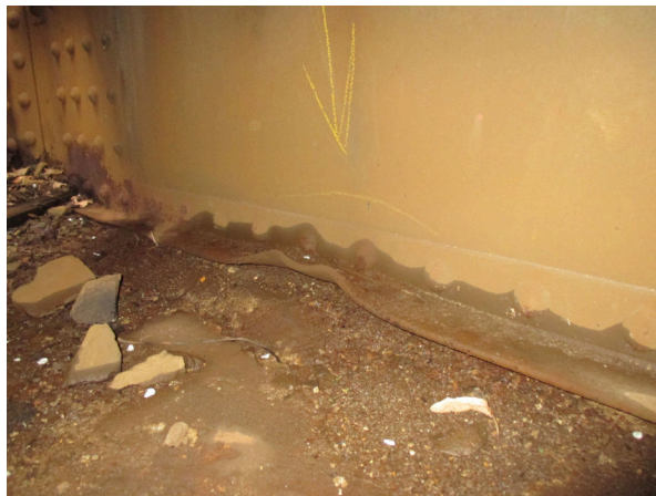
Obr. 5.3: Vybočená dolná pásnica priečniku (2)
