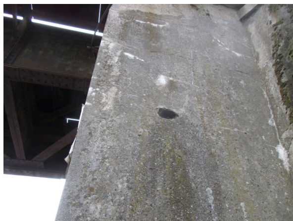
Obr. 2.13: Vývod oceľovej trubky
