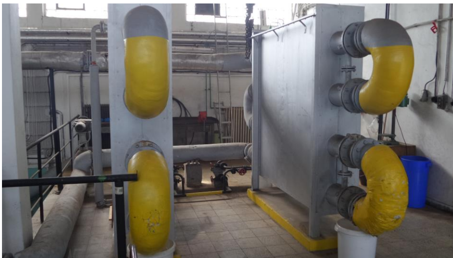
Obr.6.2 – Dezinfekce kalu vodní parou
