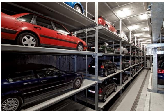
Obrázek 6 - Parkovací systém Multiparker
