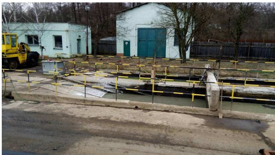
Obrázek 12 - Pohled na vsakovací nádrže ( autor )
