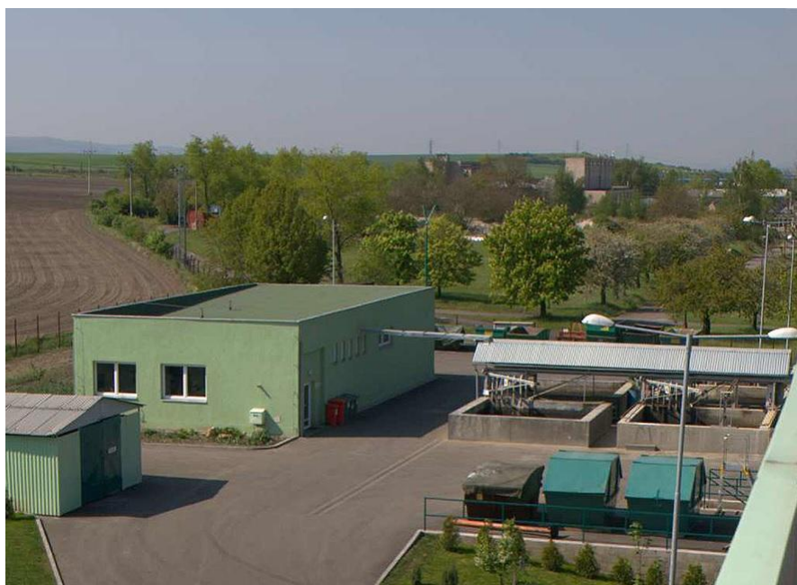
Obrázek 3 - Prostor sběrného dvora, budova se zařízením CINIS [1]
