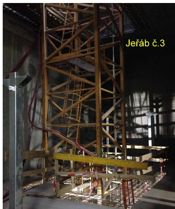
Obrázek 22 – jeřáb č.3 (archiv autora)
