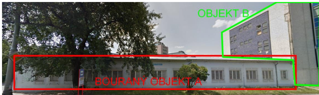
Obrázek 2 – bouraný objekt (upraveno autorem) [zdroj: mapy.cz 2016-04-03]
