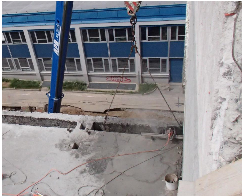
Obrázek 6 – řezání atik [zdroj: 15]
