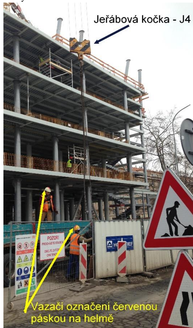
Obrázek 23 – připevňování nákladu jeřábem č.4 (archiv autora)
