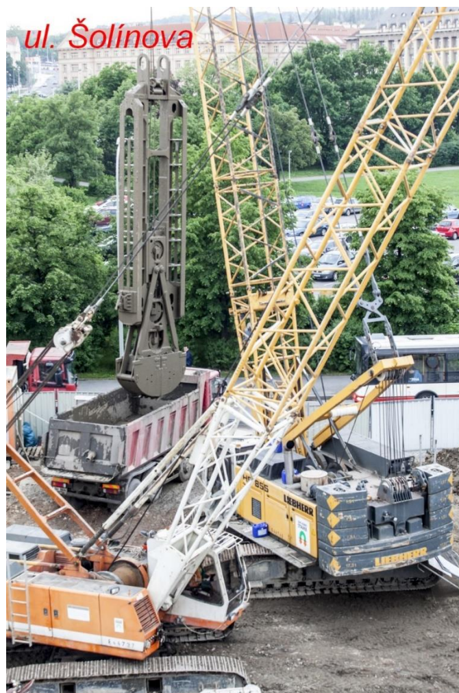
Obrázek 12 – drapák na staveništi A (upraveno autorem) [zdroj: 12]
