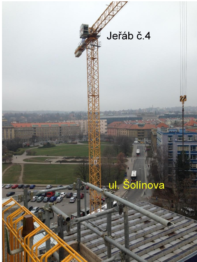
Obrázek 21 – jeřáb č.4 (archiv autora)
