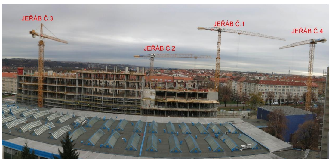
Obrázek 19 – nasazení všech jeřábů [zdroj: 12]
