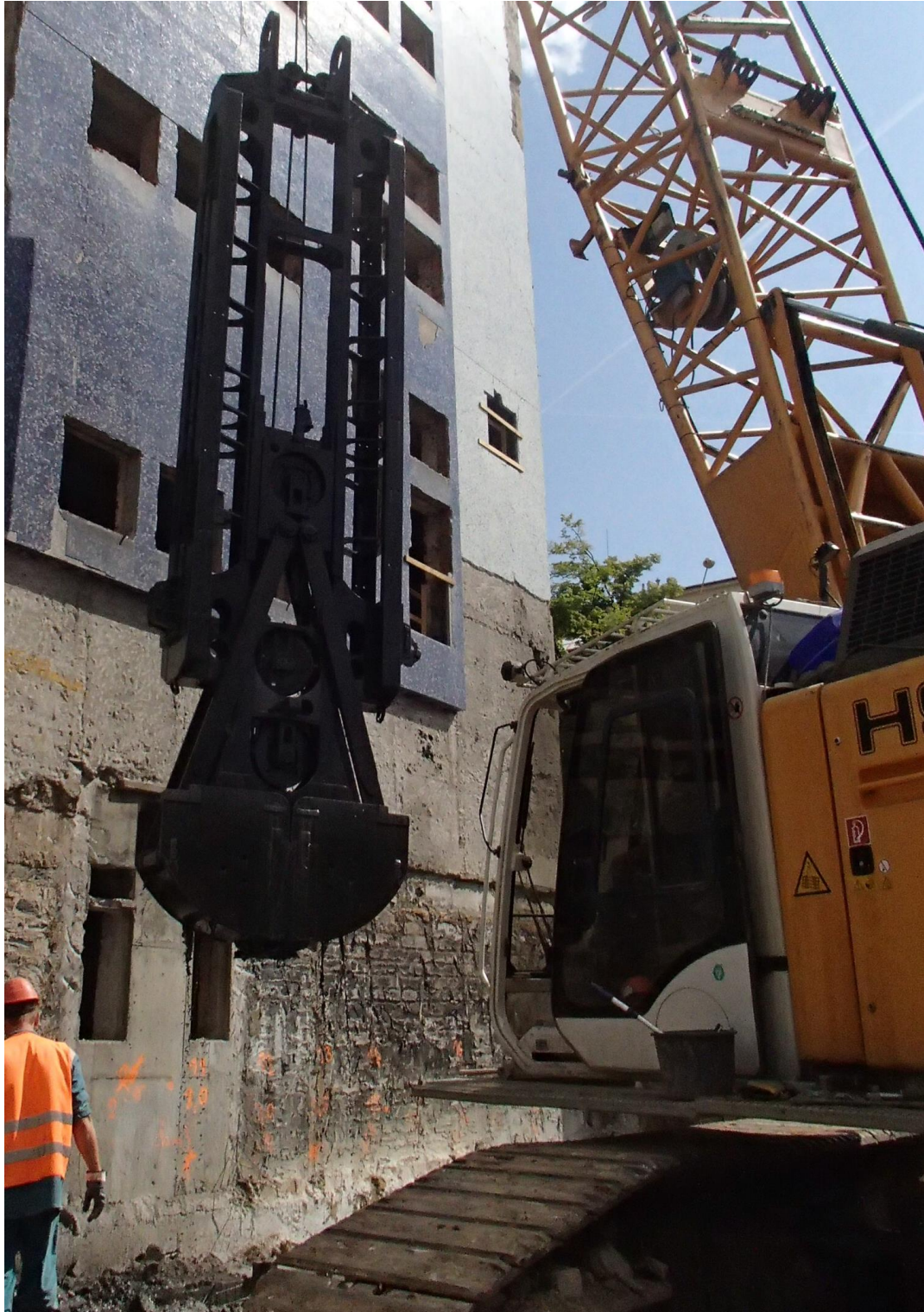
Obrázek 10 – drapák při hloubení objektu A [zdroj: 14]
