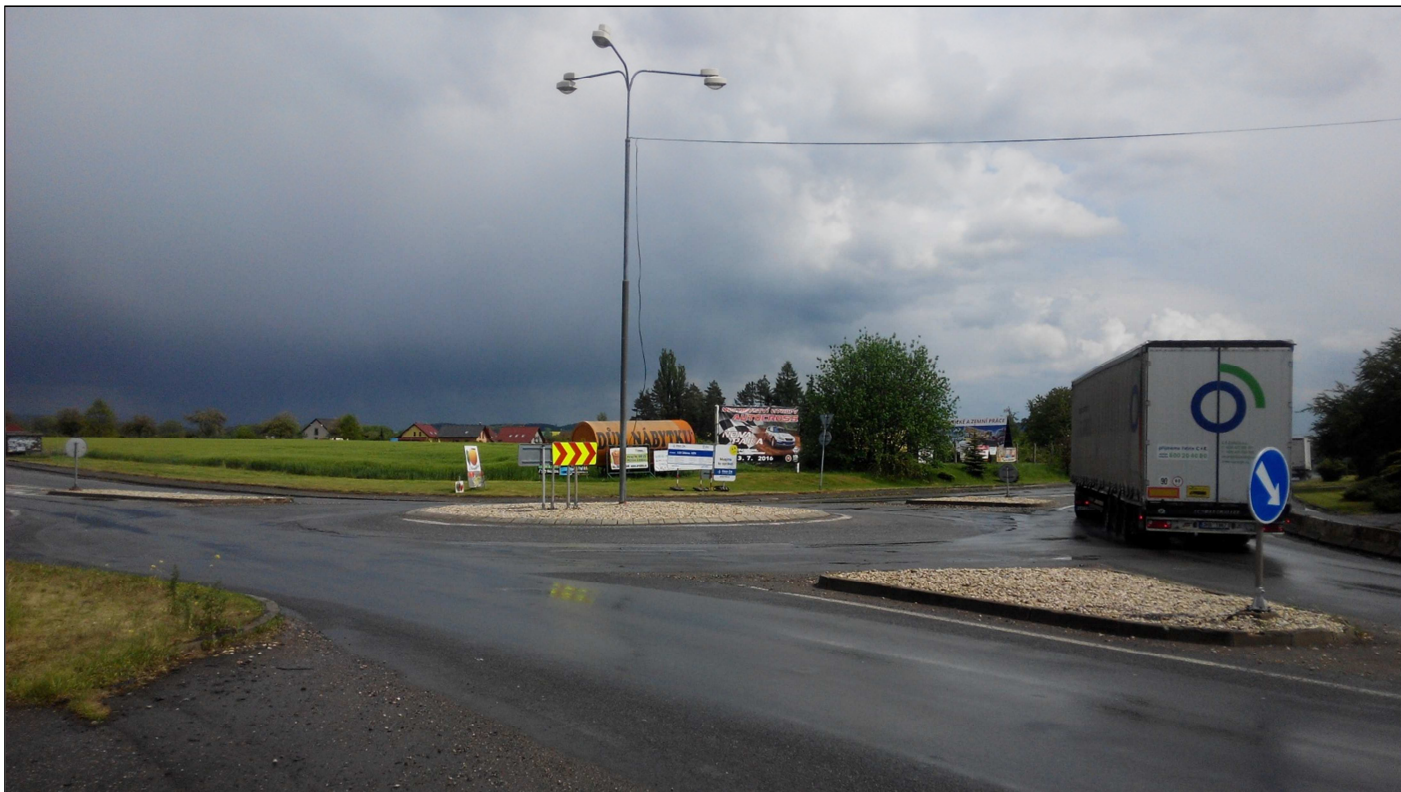
Obr. 3: Okružní křižovatka silnic I/16 a I/35 na okraji obce Úlibice
