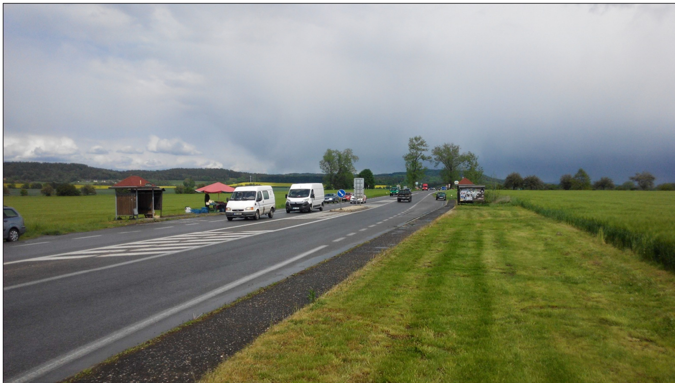
Obr. 1: Silnice I/16 ve směru na Novou Paku
