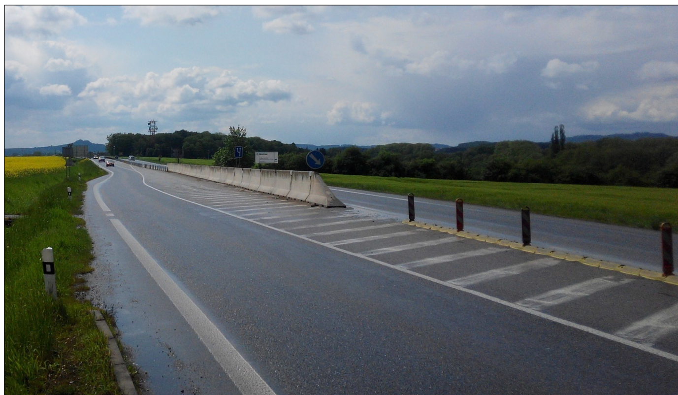
. Obr. 2: Pohled na silnici I/16 od obce Úlibice (v pozadí zúžení čtyřpruhového úseku z Jičína)
