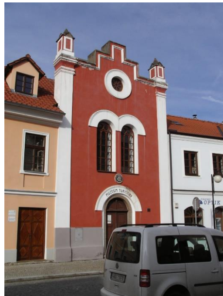
Obrázek 42. Průčelí synagogy s hlavním vchodem do muzea
