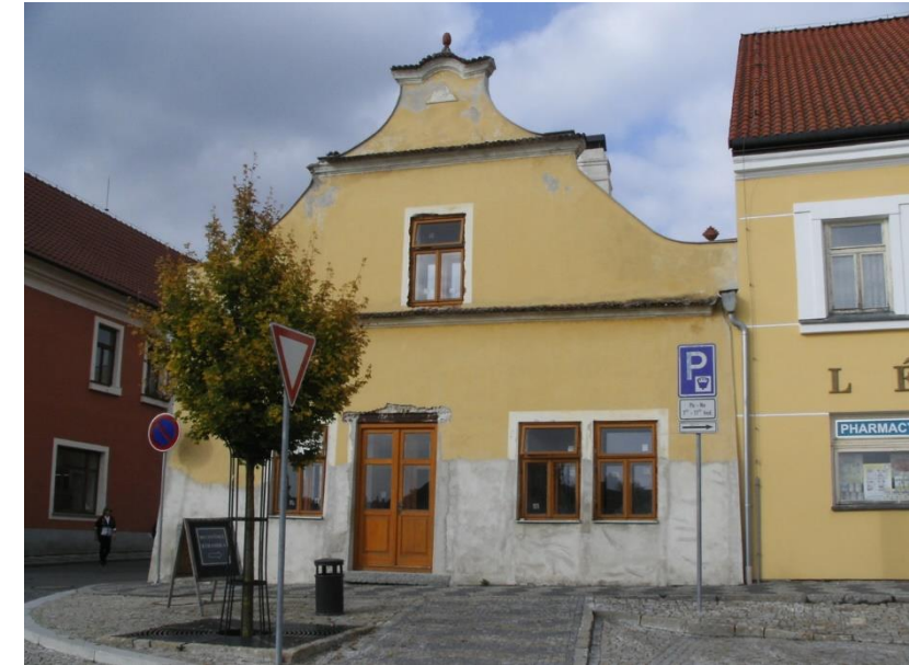
Obrázek 21. Dům čp. 23 situovaný u silnice.
