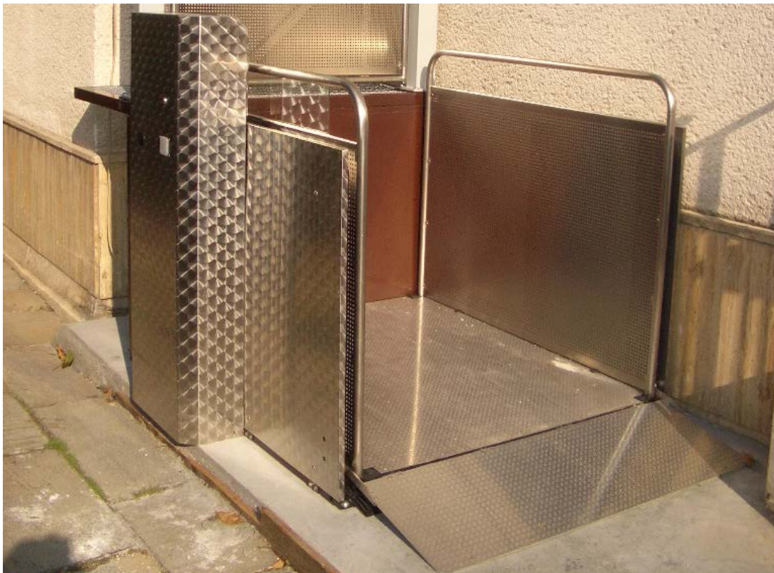
Obr. 6 - Vertikální zdvižná plošina - princip nekonečné matice [12]
