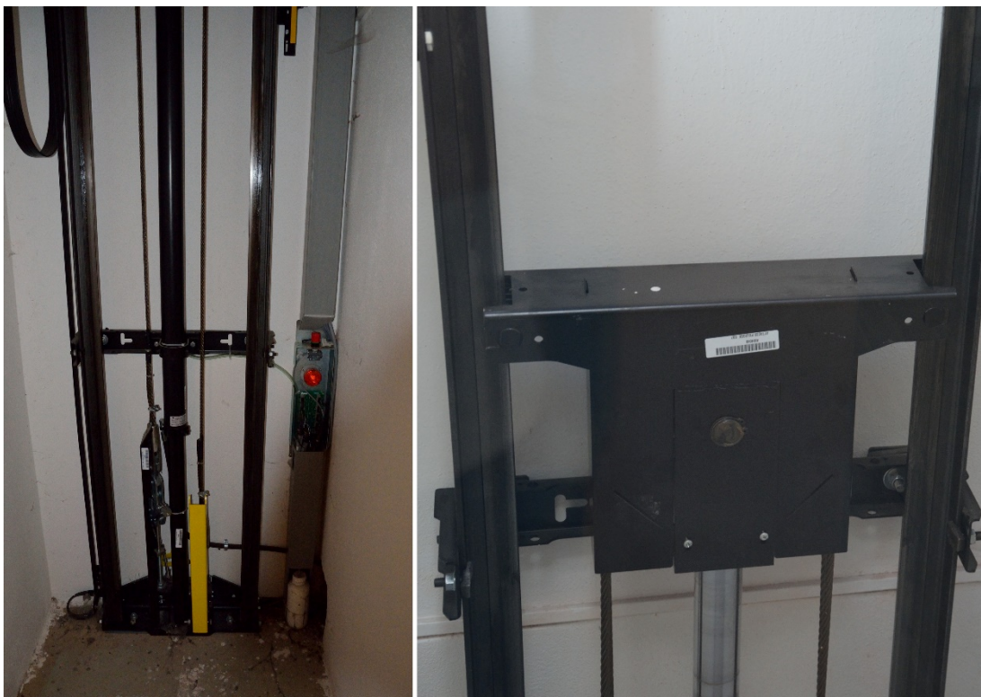
Obr. 8 - Hydraulická vertikální plošina (vlevo pohled na spodní část pístu, vpravo na horní část) [Vytvořeno autorem]
