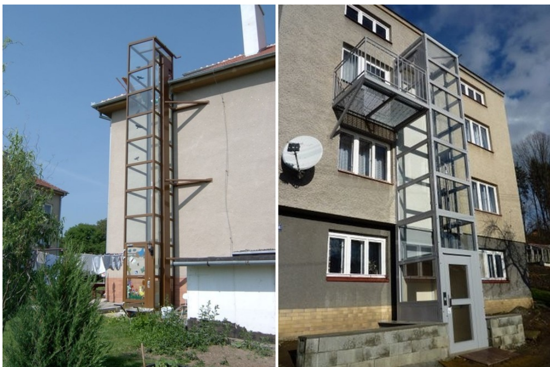
Obr. 22 - Vnější vertikální zdvižná plošina (vlevo 4 stanice, vpravo 3 stanice) [12]
