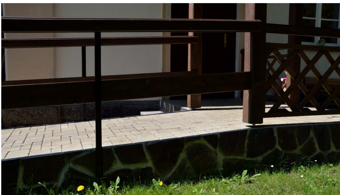
Obr. 4 - Nájezdová rampa - vydlážděná betonová konstrukce [Vytvořeno autorem]
