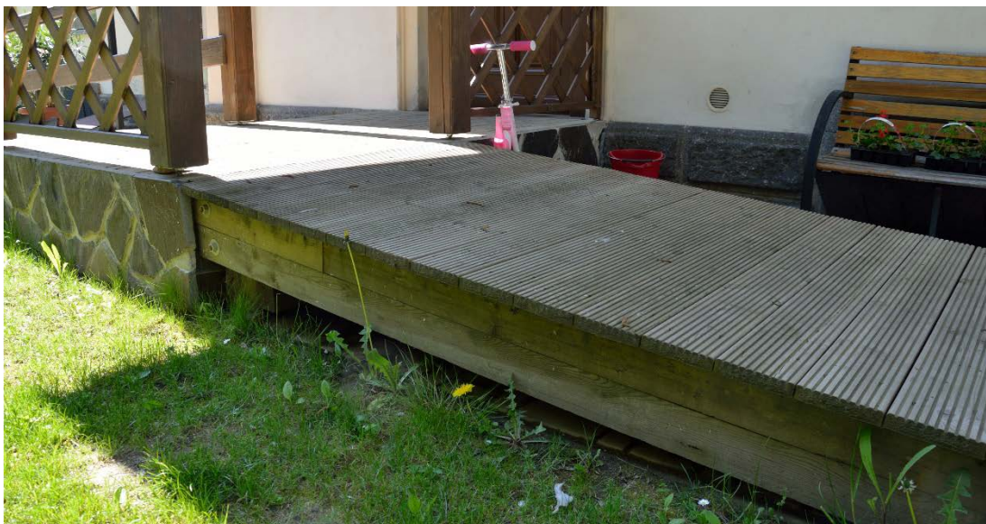
Obr. 2 - Nájezdová rampa - dřevěná konstrukce [Vytvořeno autorem]
