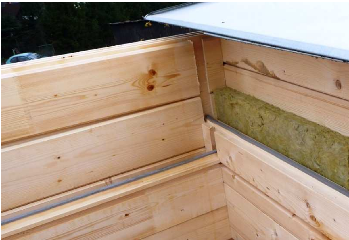
Obr. 4. – Zdvojená roubenka s vloženým tepelným izolantem
