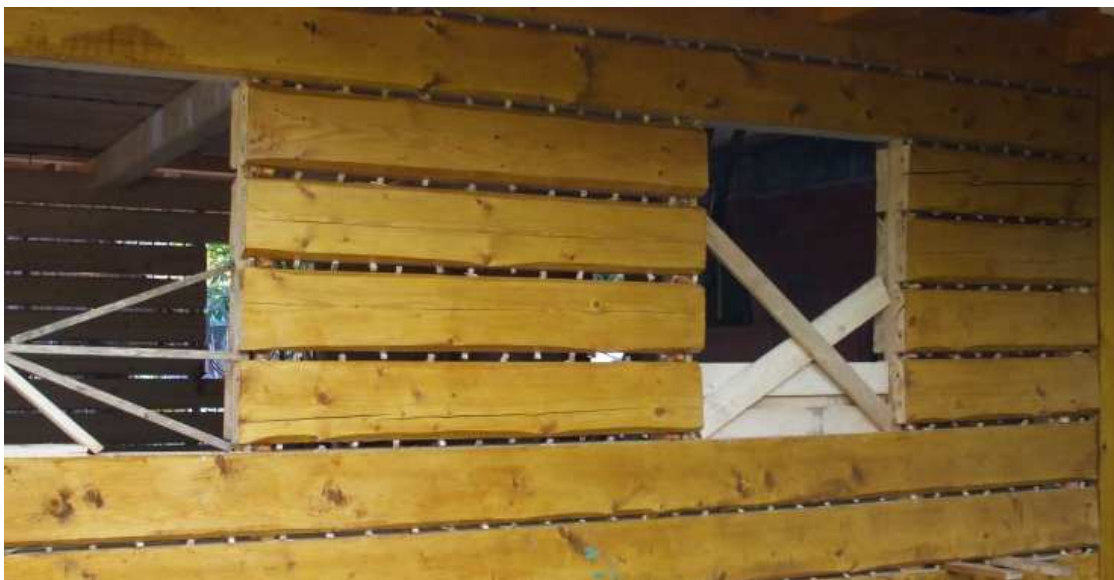
Obr. 3. – Mezera mezi stěnovnicemi
