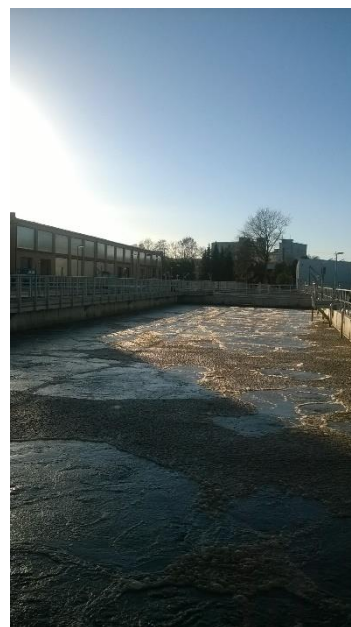
Obrázek 2: dosazovací nádrž ČOV, která se nachází v areálu sídla firmy
