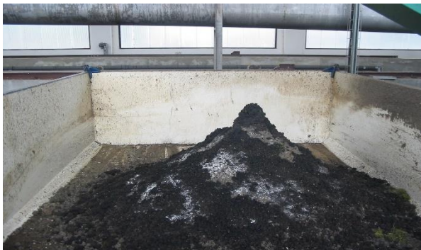
Obrázek 16: odpad zachycený lapákem písku a tuků
