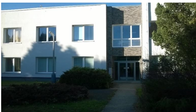
Obrázek 1: správní budova firmy CHVaK a. s.
