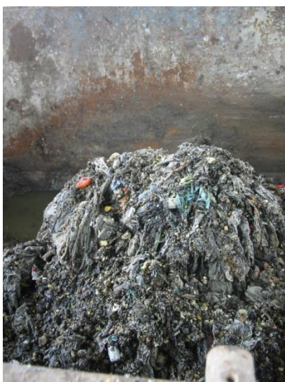
Obrázek 15: odpad zachycený lapákem štěrku
