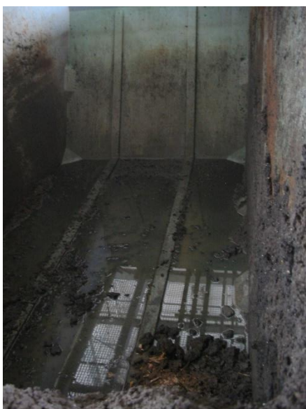
Obrázek 18: kontejner na skladování přebytečného kalu
