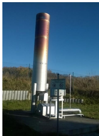
Obrázek 19: hořák na přebytečný kalový plyn a bioplyn
