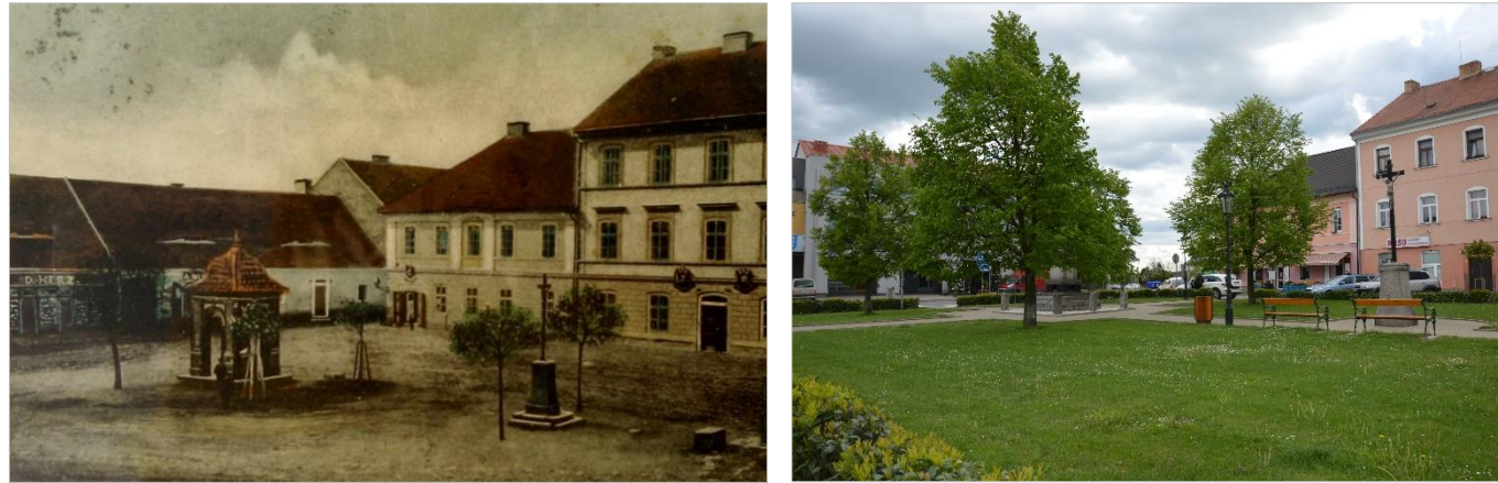
Obr. 4. 12 Budova bývalé pošty a okresního soudu 1905 a 2016 [Zdroj: Sbíрка pana Fráze; vlastní fotografie, duben 2016]
