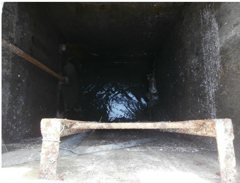
Obr. 17 Dešťový oddělovač před ČSK
