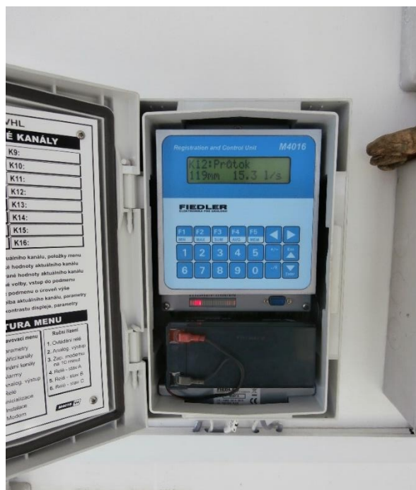
Obr. 19 Řídící jednotka Fiedler M4016
