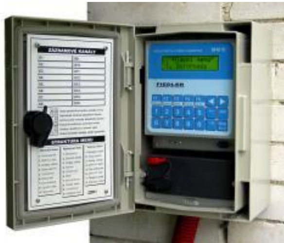
Obr. 1 Řídící jednotka Fiedler M4016 – G [5]
