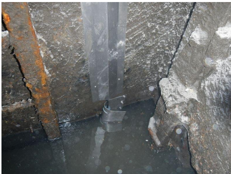
Obr. 21 Tlakový hladinoměr
