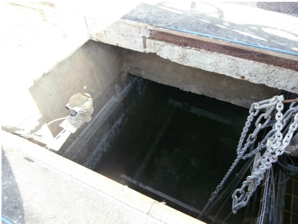
Obr. 16 Čidlo pro měření hladiny na spínání čerpadel
