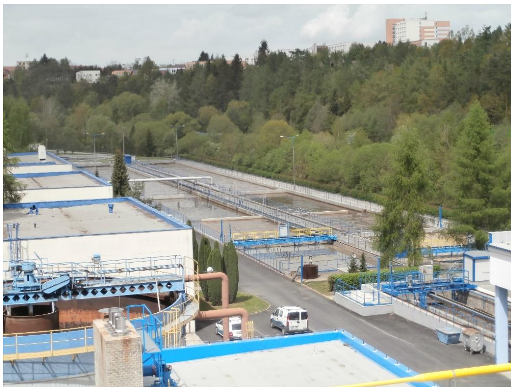
Obr. 11 Areálová čistírna odpadních vod v Táboře
