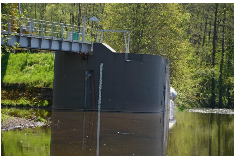
Obrázek 1.10 Pohled na levý jezový pilíř
