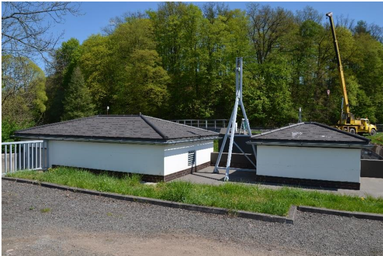
Obrázek 1.4 Pohled na strojovnu jezu (pravý jezový pilíř)
