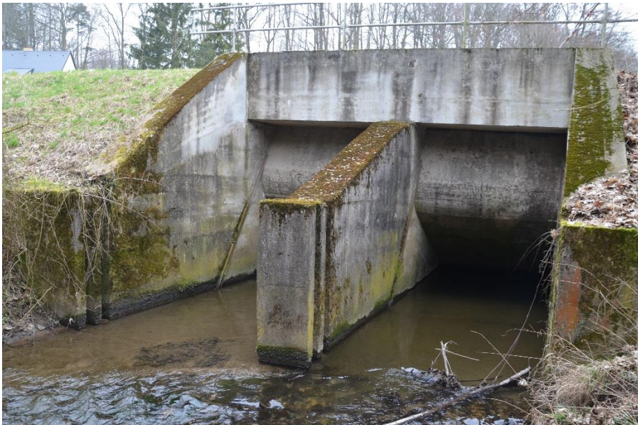
Obrázek 2.6 Potok Olešnice je veden šybkou pod přivaděčem
