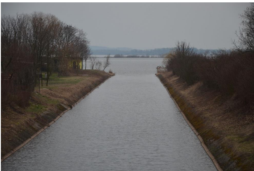
Obrázek 2.1 Vyústění přivaděče do vodní nádrže Rozkoš
