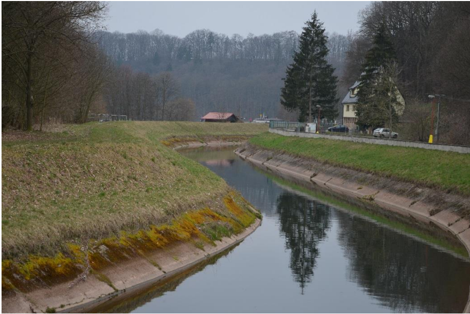
Obrázek 2.5 Horní část přivaděče – na obrázku je patrná levobřežní betonová zídka vybudovaná při rekonstrukci v roce 2007
