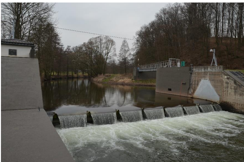
Obrázek 1.2 Pohled na těleso jezu ve Zličí proti proudu
