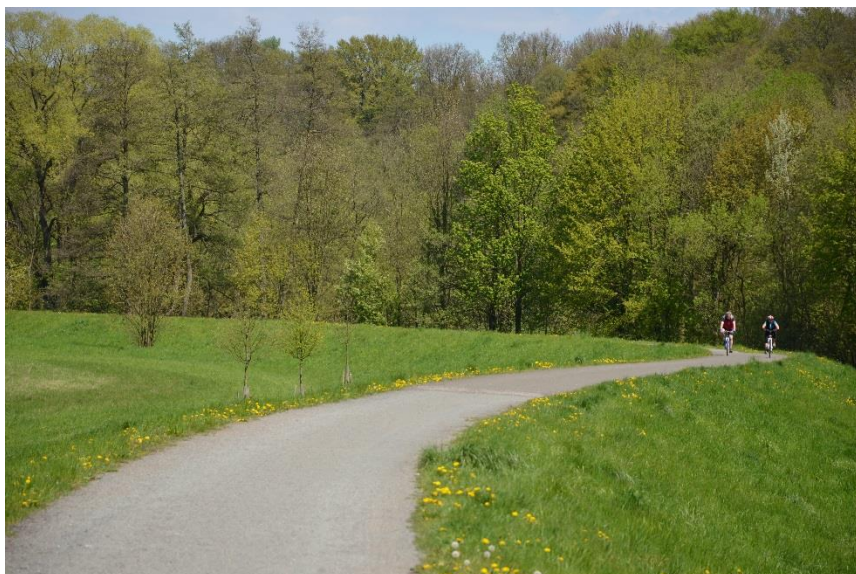
Obrázek 2.3 Zemní hrázka s asfaltovou cyklostezkou
