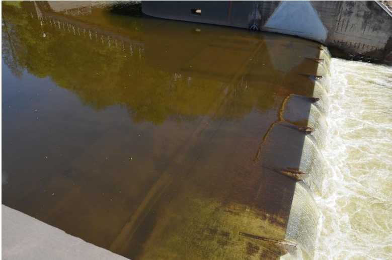
Obrázek 1.3 Detailní pohled na klapku
