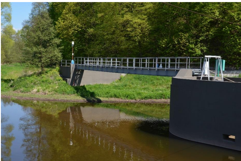
Obrázek 1.8 Pohled z pravého pilíře jezu na nátok do přivaděče s lávkou
