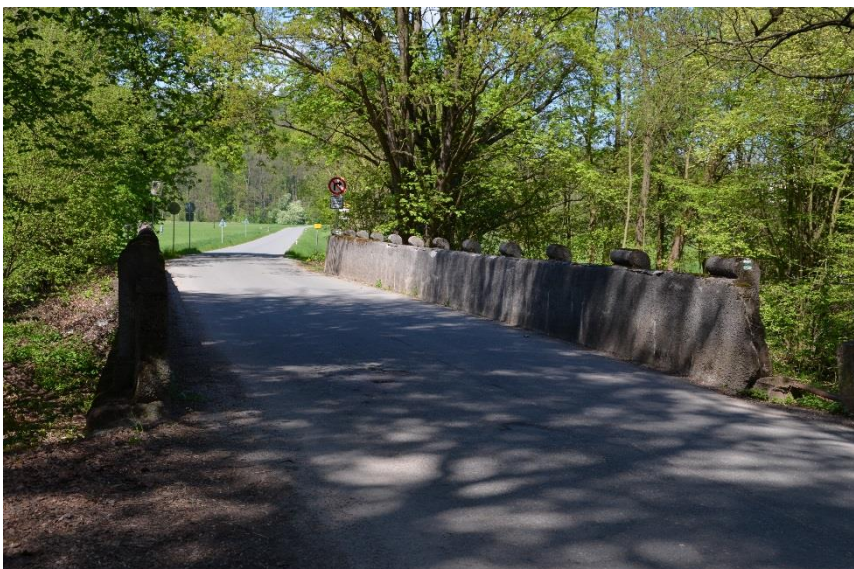
Obrázek 3.5 Povrch mostovky Vilémova mostu tvoří asfaltová komunikace (foceno květen 2016)
