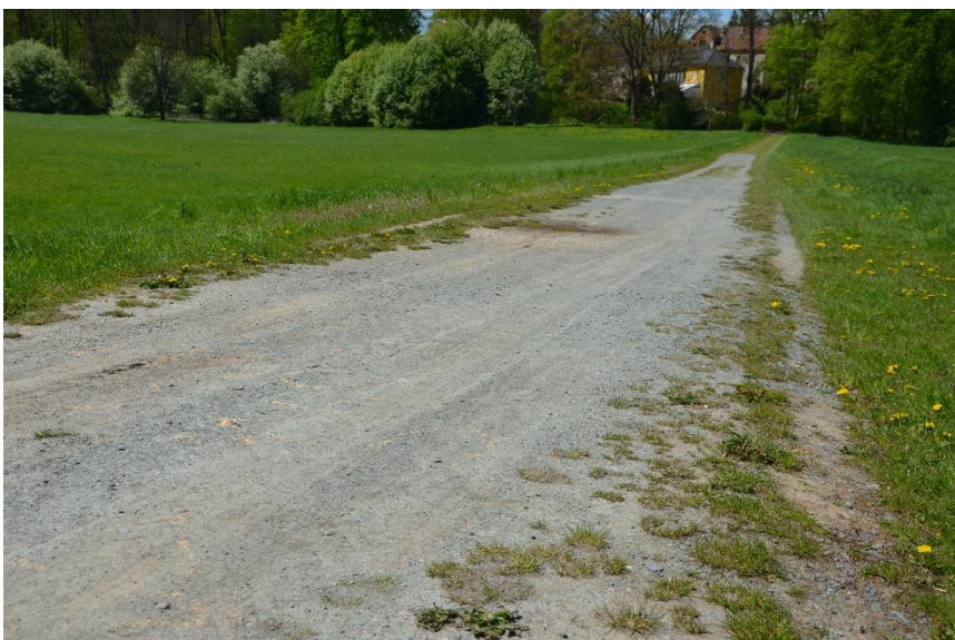
Obrázek 1.12 Povrch přelivu je tvořen udusaným štěrkem
