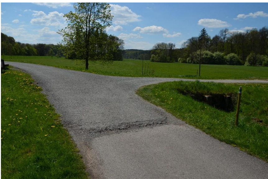
Obrázek 1.14 Patrné navýšení zemní hrázky při rekonstrukci v roce 2007
