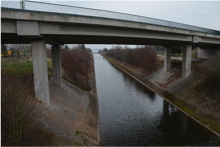
Obrázek 2.2 Silniční most přes přivaděč
