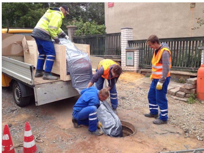
ZEPRIS s.r.o. Zatahování rukávce přes šachtu. [fotografie]. © 2016.
