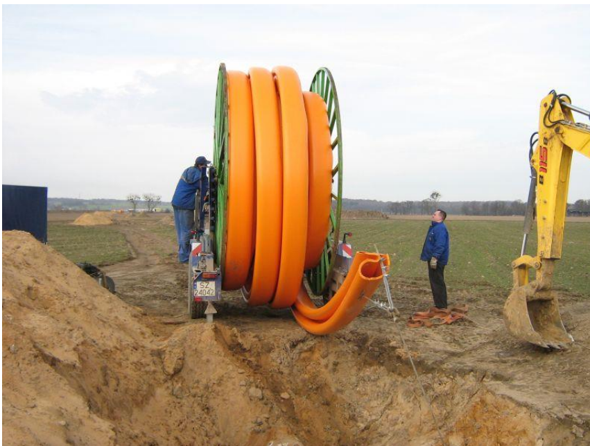
Obr. 4.4.7 – Compact Pipe – zdeformovaná trouba navinutá na bubnu [21]
