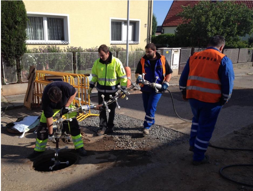
ZEPRIS s.r.o. Zatahování UV zařízení. [fotografie]. © 2016.
