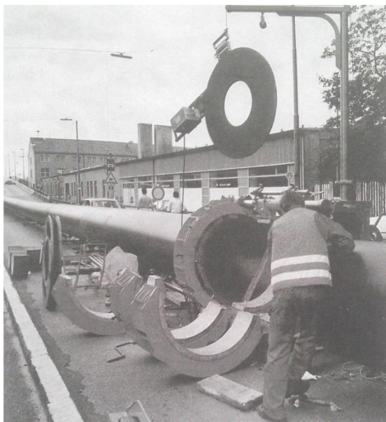
Obr. 4.4.5 – Svařování termoplastových trub před jejich zataháním [16]
