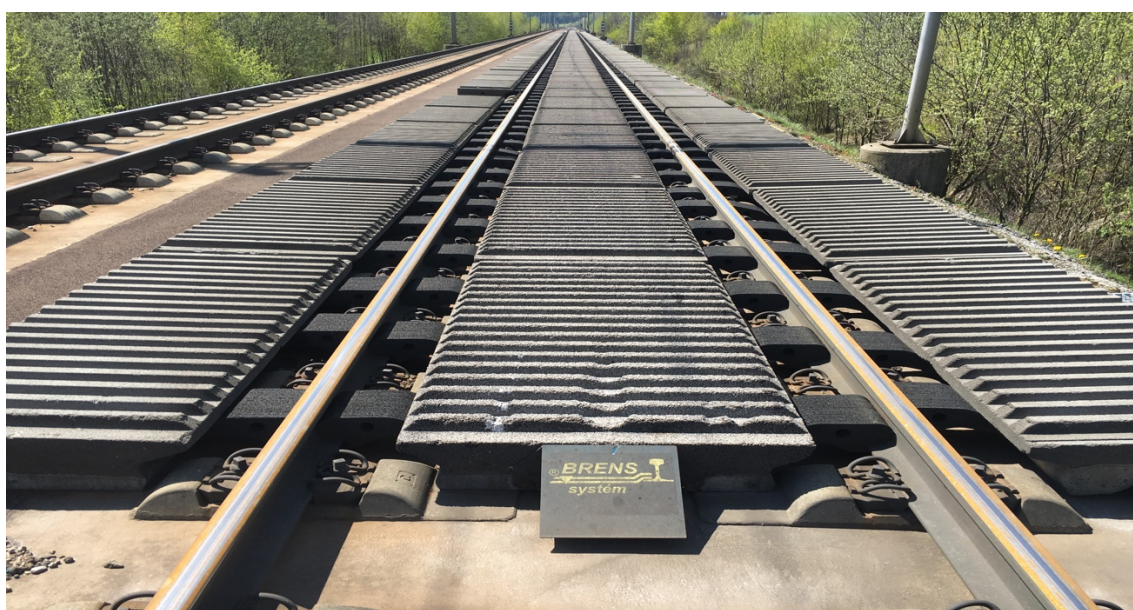
Obr. 4: Kolejový absorbér hluku BRENS® [vl. fotoarchiv 29.4.2016]
