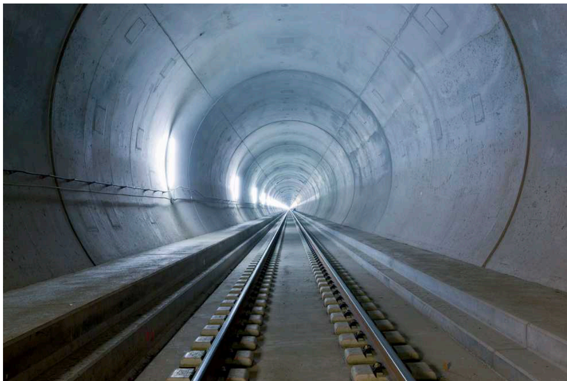
Obr. 31: Pohled na dokončenou PJD v Gotthardském tunelu [12]
