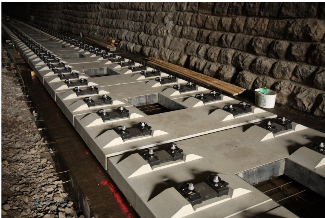
Obr. 24: Pokládání prefabrikovaných panelů ÖBB-Porr [9]
