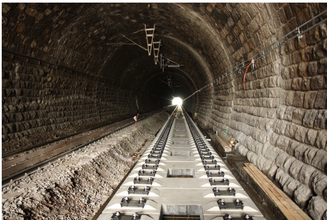
Obr. 12: Pohled na PJD ve Střelenském tunelu při výstavbě [14]
