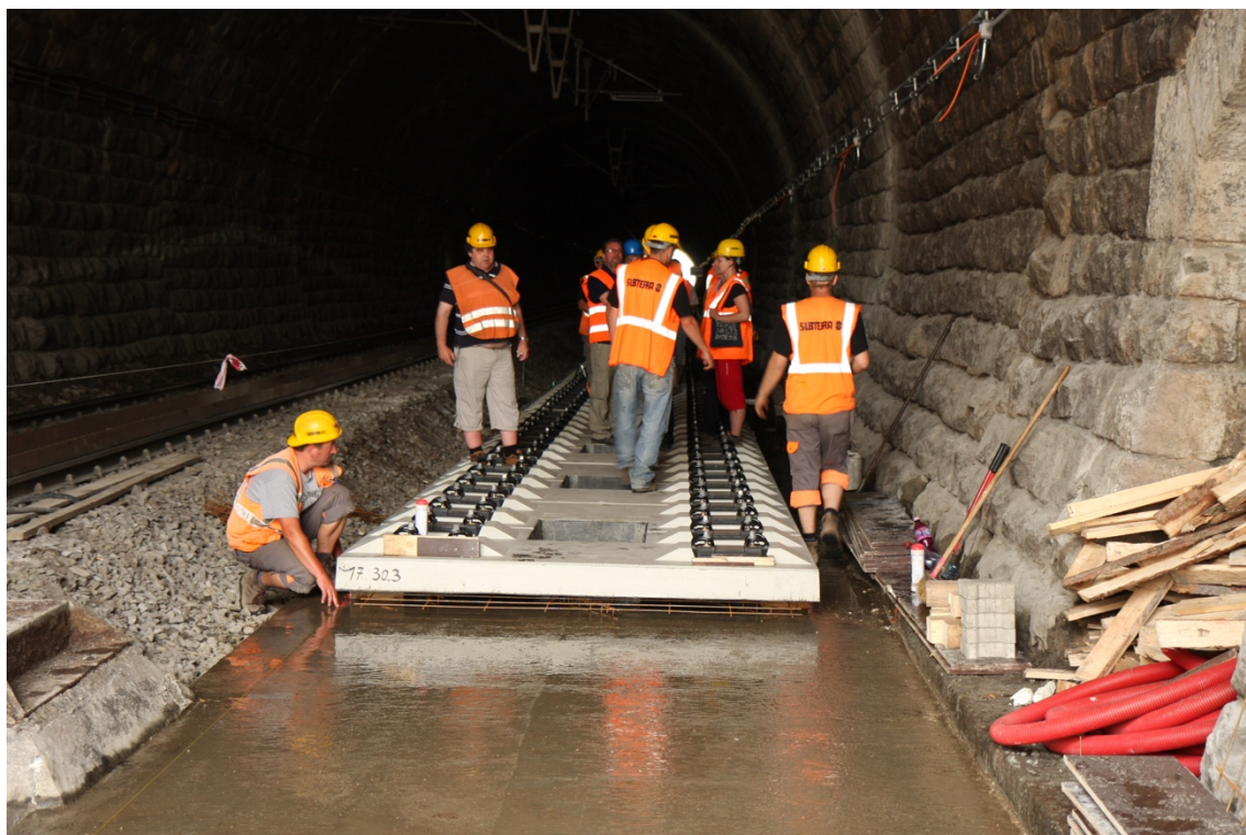
Obr. 14: Pokládání panelů ÖBB-Porr ve Střelenském tunelu [9]
