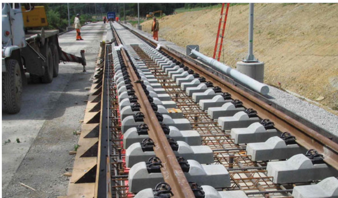
Obr. 20: Pohled na konstrukci Rheda 2000 před betonáží [19]
