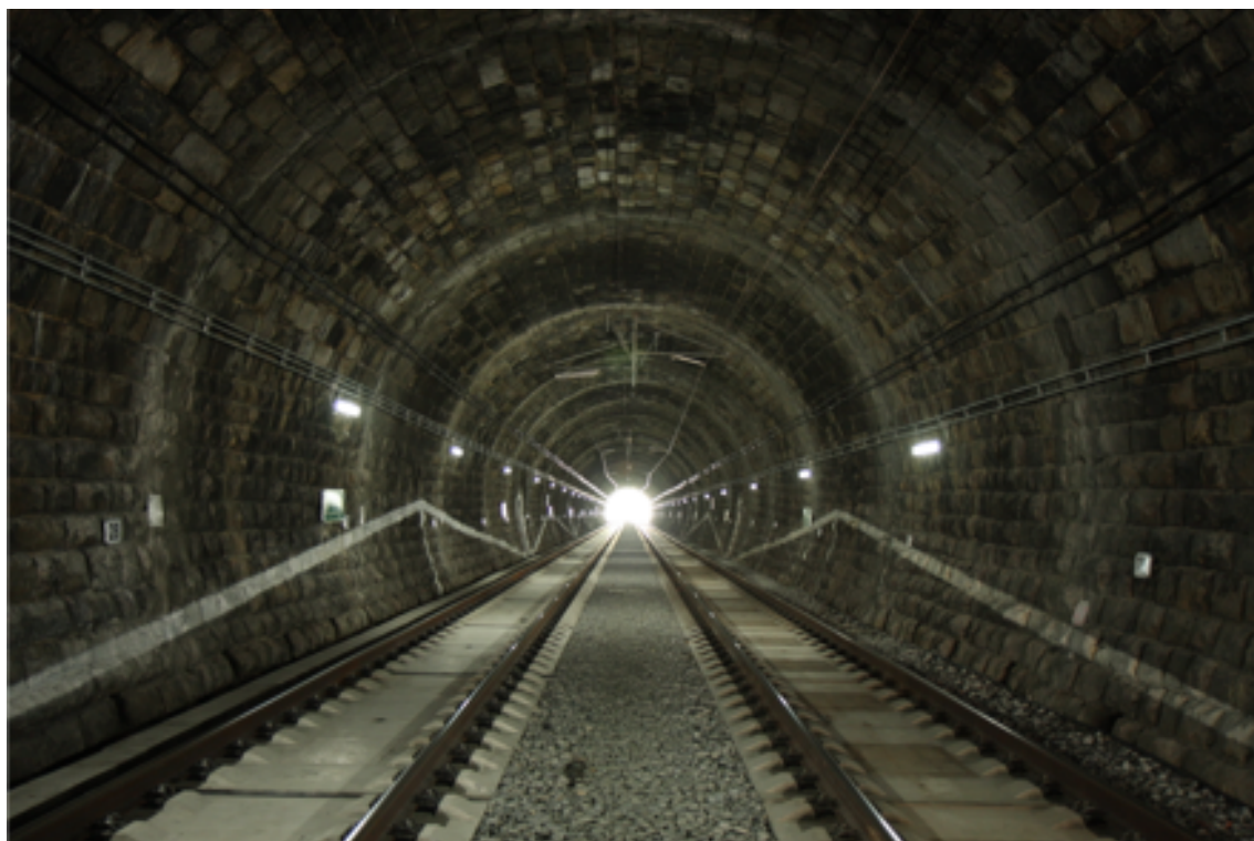
Obr. 15: Stav po dokončení PJD ve Střelenském tunelu [9]
