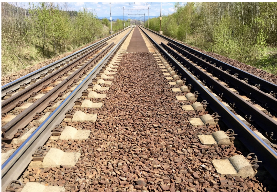
Obr. 7: Přechodová oblast na trati Č. Třebová – Přerov [vl. fotoarchiv 29.4.2016]
