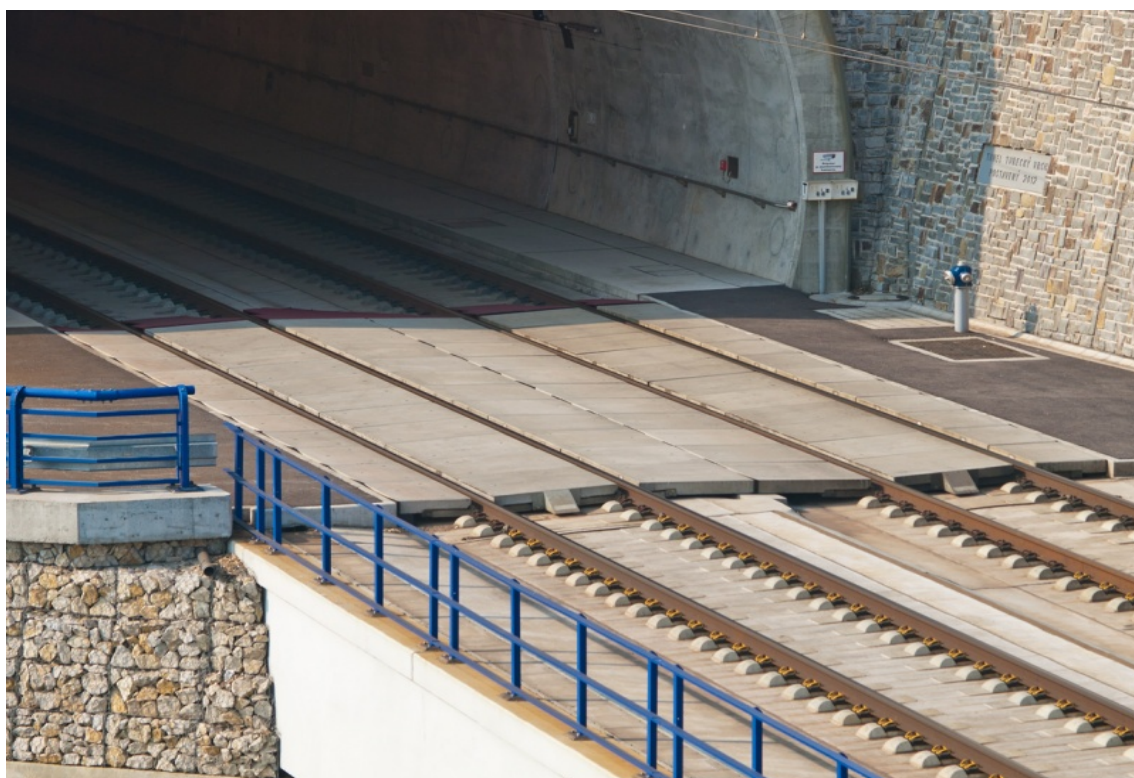
Obr. 26: Panely BRENS ACCESS® v předportáli tunelu Turecký vrch [23]
