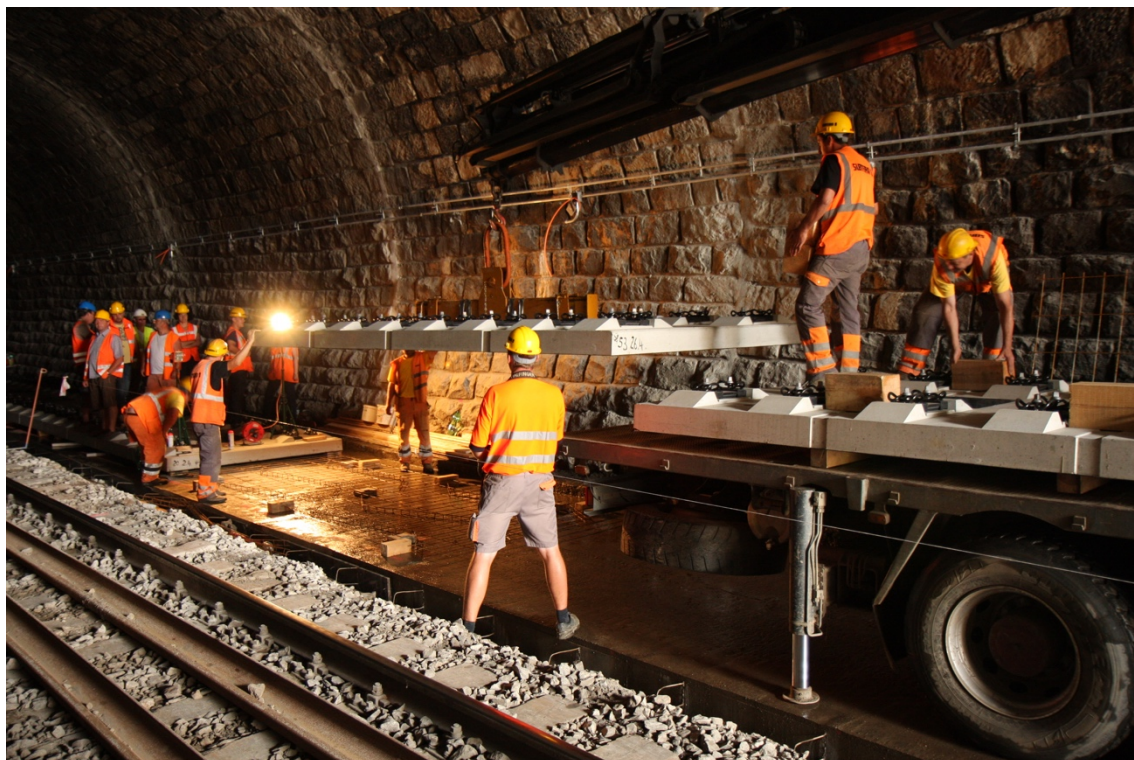
Obr. 23: Pokládání prefabrikovaných panelů ÖBB-Porr [9]
