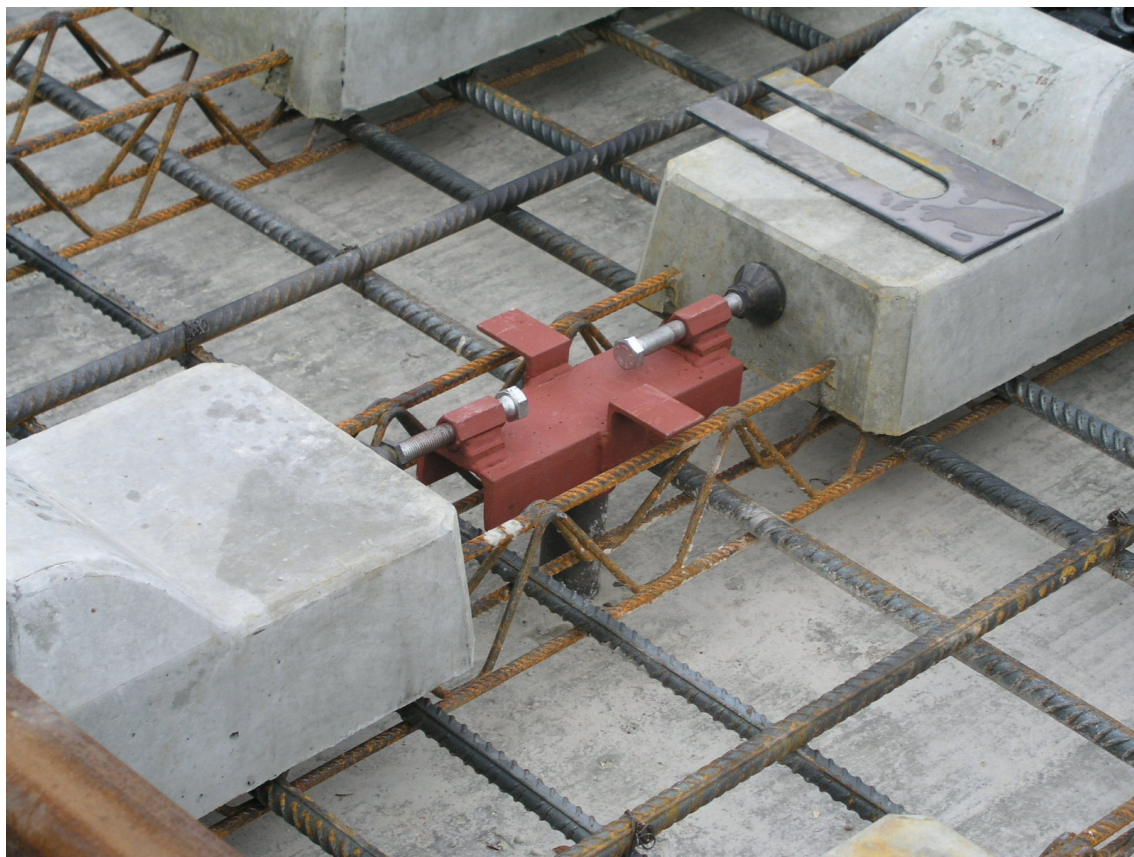
Obr. 21: Rektifikační mechanismus při stavbě PJD Rheda 2000 [19]
