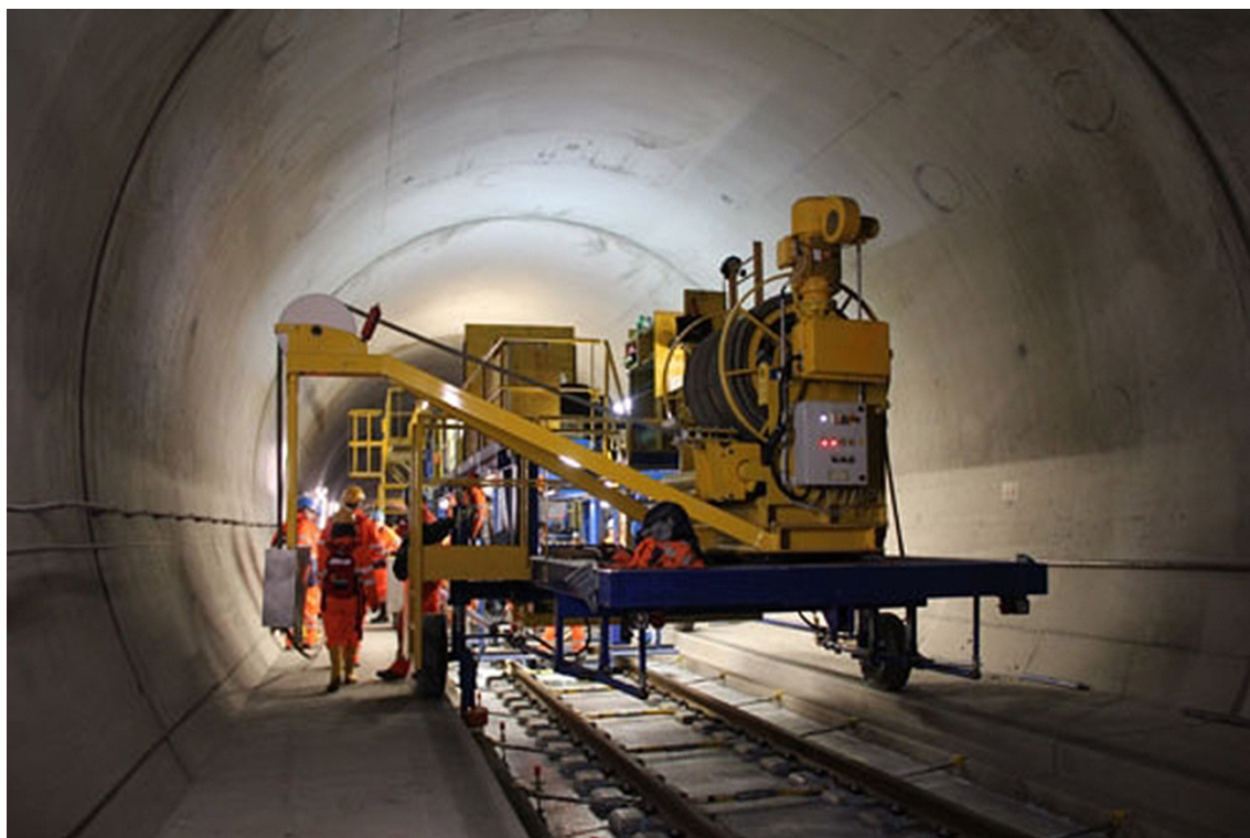
Obr. 32: Pokládka PJD v Gotthardském tunelu [12]
