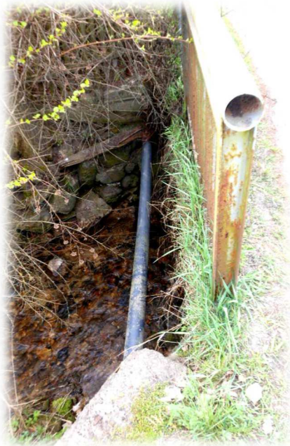
Obr. 5 - detail propustku, vedení telefonního kabelu
