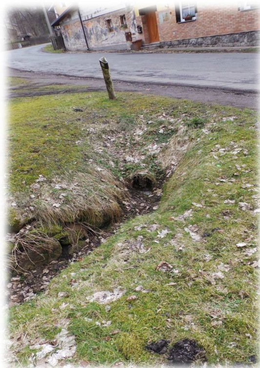
Obr. 9 - vývod odpadní roury z okolních budov
