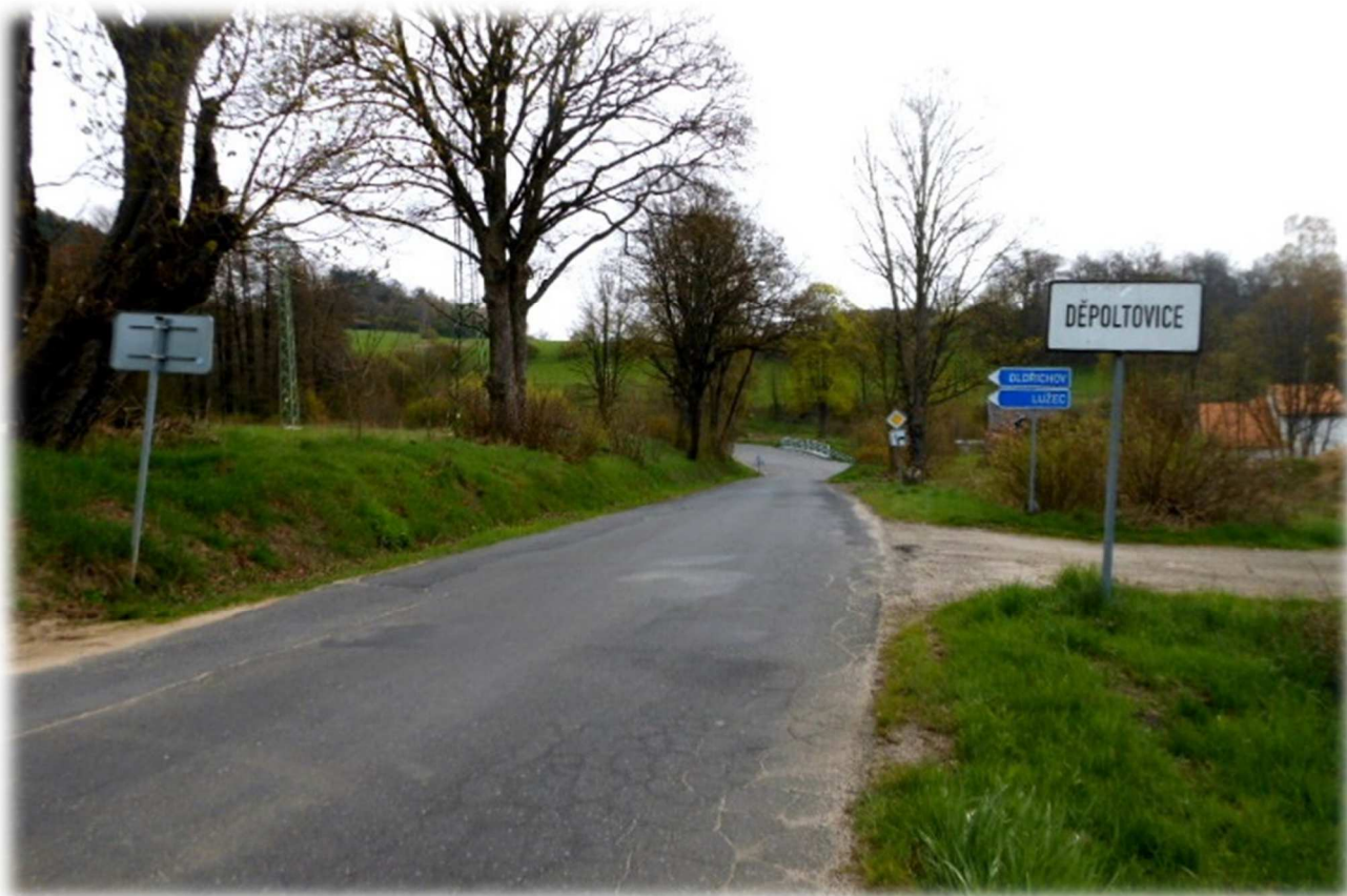
Obr. 1 - začátek úseku km 0,00000
