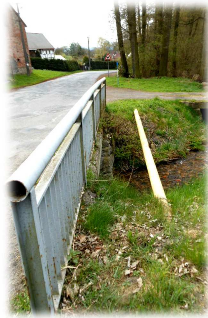
Obr. 6 - detail propustku, vedení plynu
