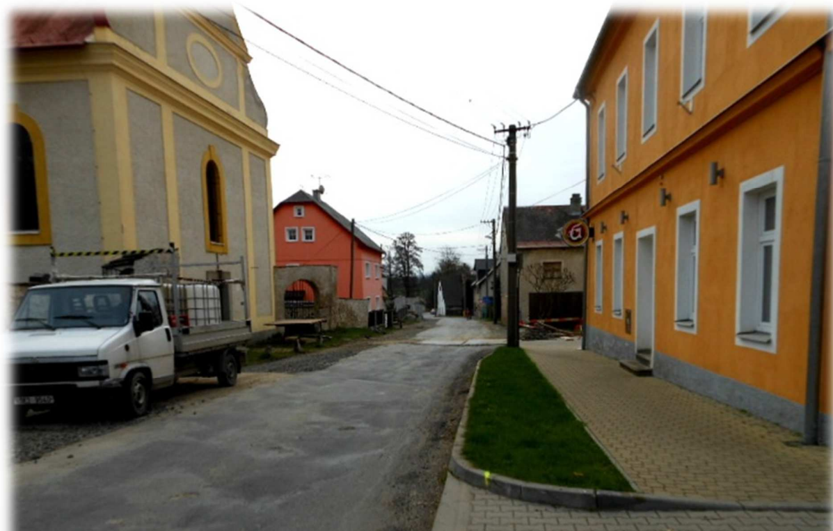
Obr. 13 - úsek km 0,66000, napojení chodníku na stávající dlažbu
