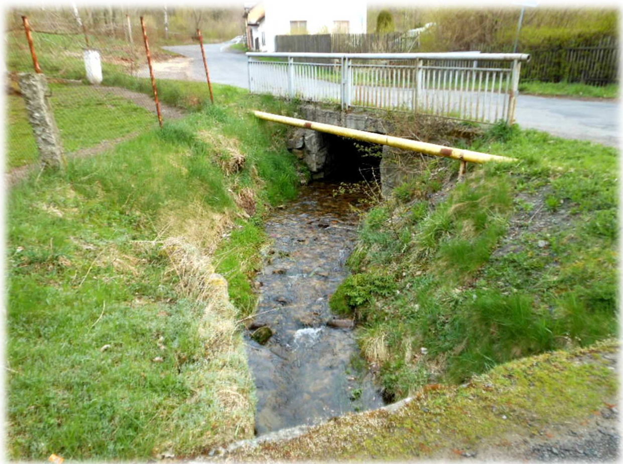
Obr. 7 - propustek, pohled z mostu
