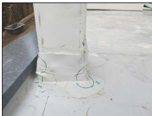
Obr. 16: Nesystematicky řešené opracování sloupu (foto autor)
