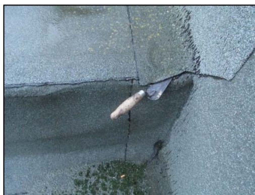
Obr. 8: Zkouška špachtlí (foto autor)
