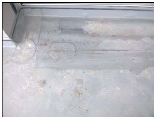
Obr. 18: Závěrečné zapravení přířezem z PVC fólie (foto autor)
