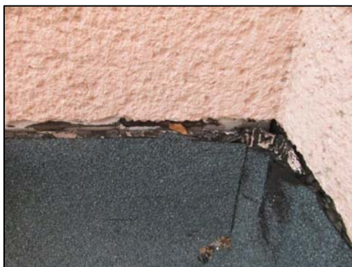
Obr. 23: Napojení asfaltového pásu na stěnu (foto autor)
