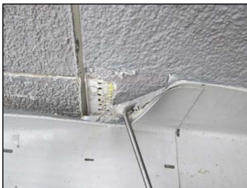
Obr. 17: Vadné zakončení u stěny (foto autor)
