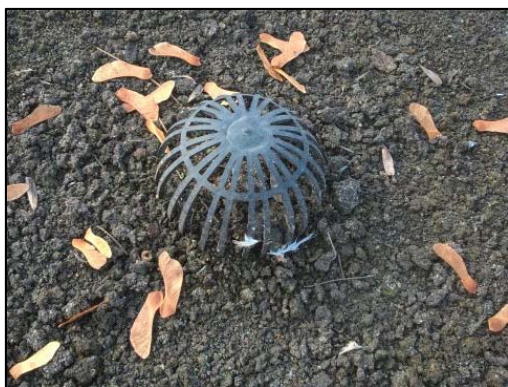
Obr. 27: Zanesený vtok (foto autor)
