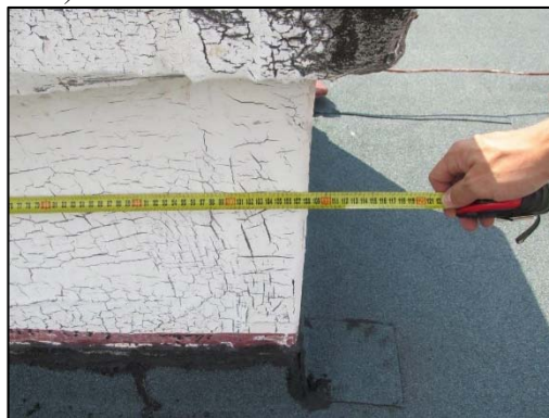
Obr. 26: Napojení asfaltového pásu na komoru vzduchotechniky (foto autor)
