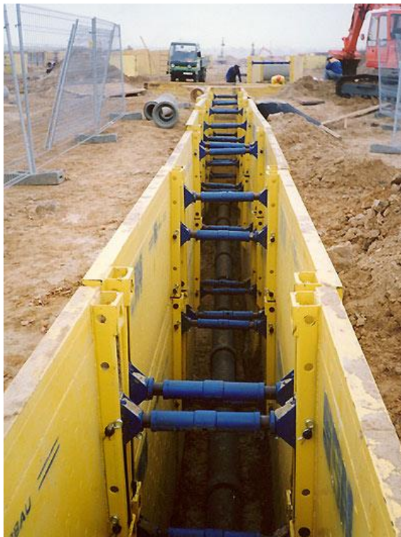
Obrázek 17: Pažení boxy [18]
