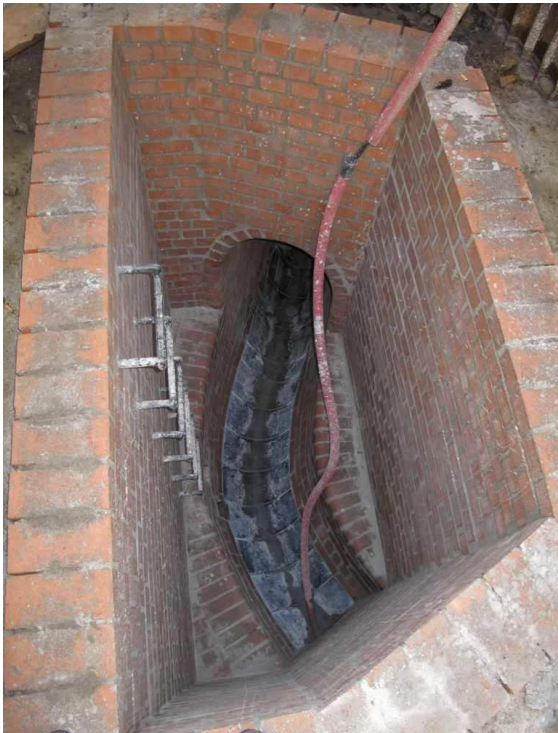
Obrázek 10: Rekonstrukce OK [16]
