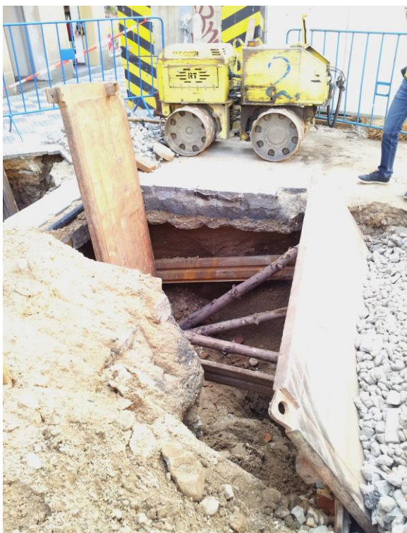
Obrázek 16: Příklad špatného pažení
