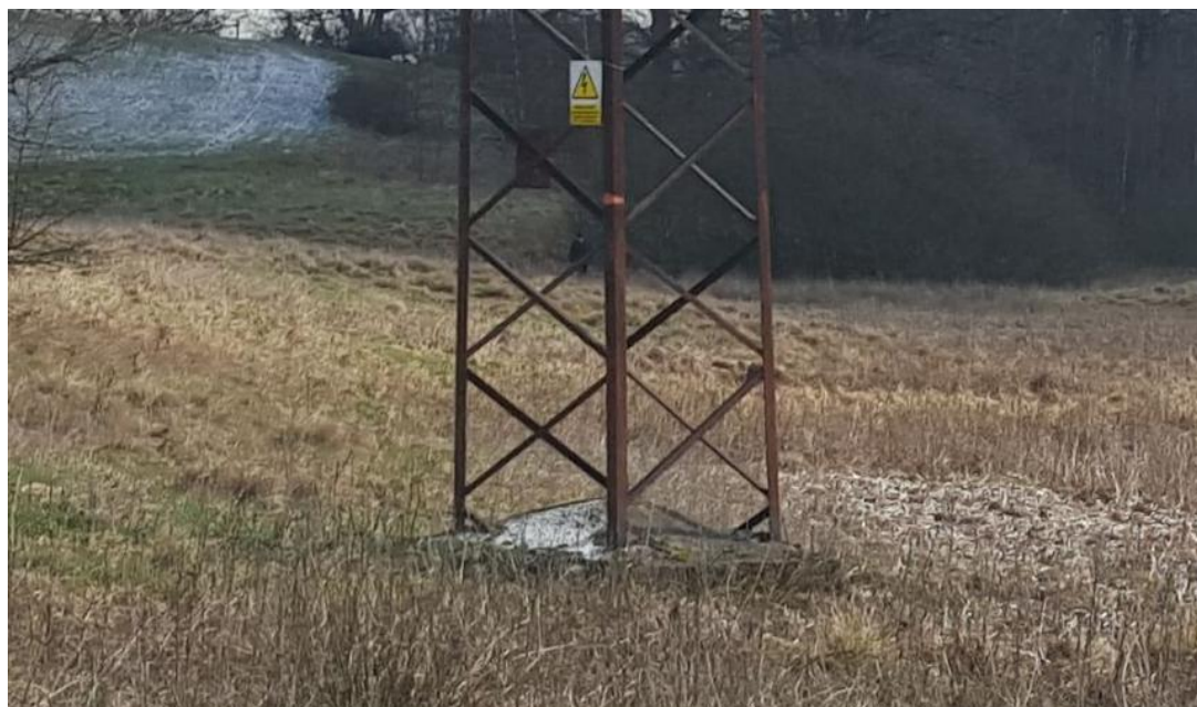
Příloha 9. Betonová patka sloupu vedení vysokého napětí
