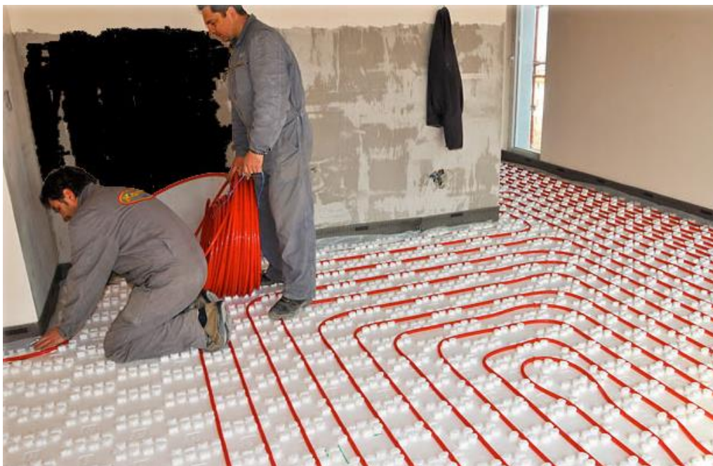
Obr. 14 Podlahové vytápění teplovodní – ukládání topných hadů [8]
