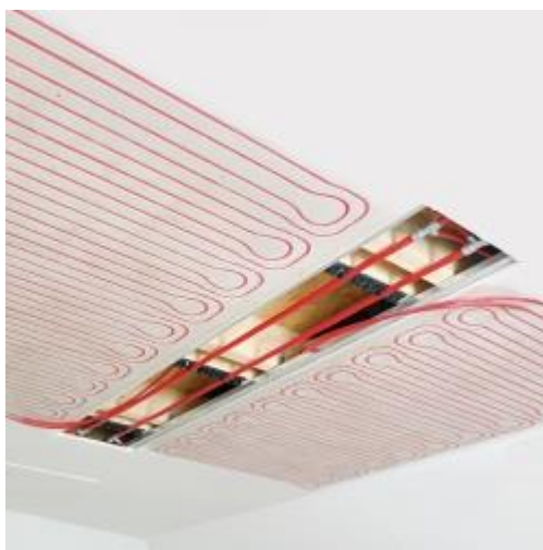
Obr. 15 Příklad stropního sálavého vytápění - teplovodní vytápění [7]
