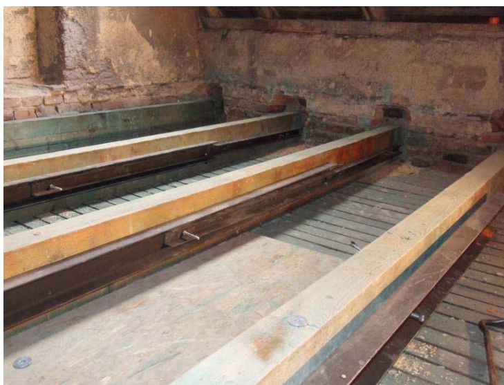
Obr. 20: Ocelové příložky stropních trámů (Převzato z http://stavba.tzb-info.cz/docu/clanky/0075/007578o1.jpg )
