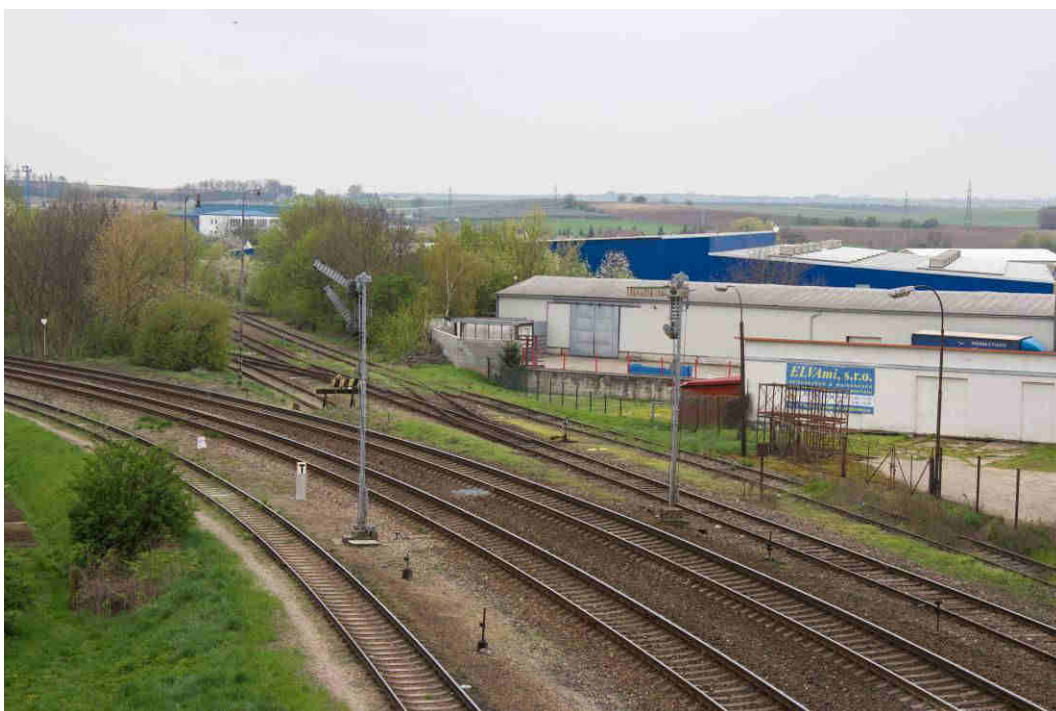
Obr. A2: Pohled na mechanická návěstidla na Vlkošském zhlaví. První kolej zleva patří vlečce do Sklářny, druhá a třetí koleje jsou traťové koleje trati č. 340, čtvrtá kolej je kolej bývalé dráhy Kyjov – Mutěnice, která dnes slouží jen jako spojovací kolej na vlečku Šroubárny. Návěstidlo vpravo je zneplatněno.
