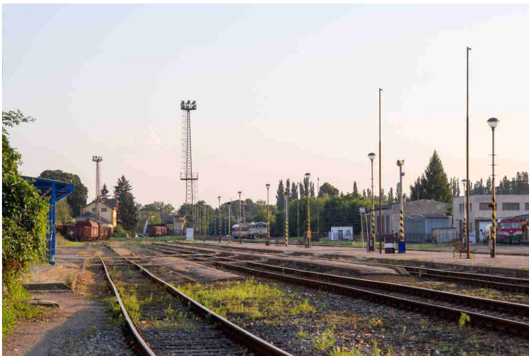
Obr. A19: Pohled na nástupiště 1, 2 a 3.
