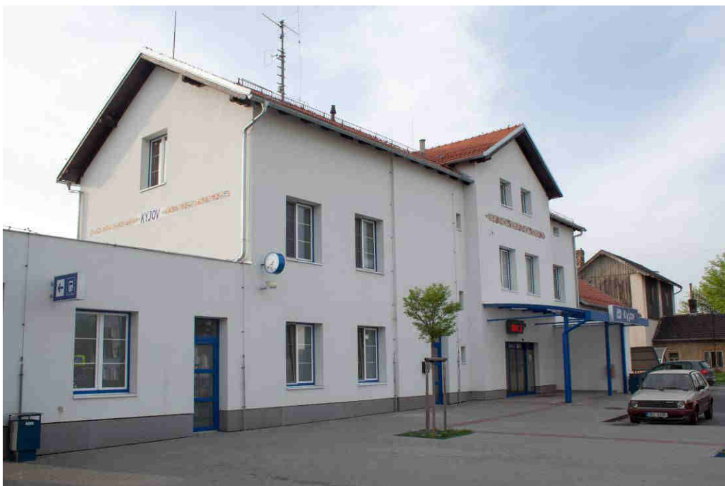
Obr. A16: Pohled na budovu z přednádraží.
