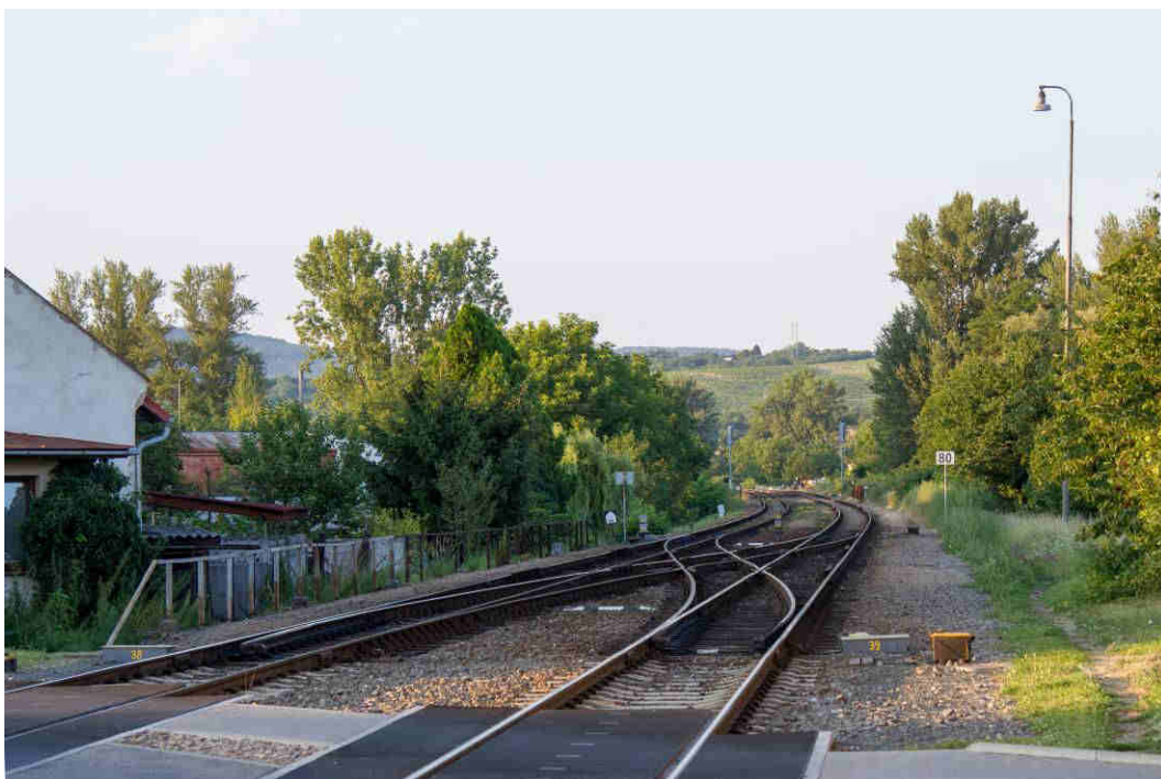
Obr. A21: Dvojtá kolejová spojka na nemotickém zhlaví, pohled směr Nemotice.
