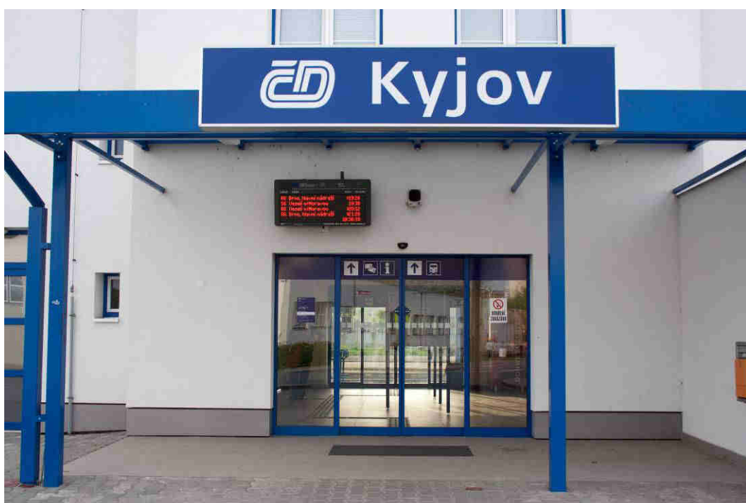
Obr. A18: Vchod do čekárny směrem z přednádraží. Ve stanici se nacházejí informační panely dle standardu IDS JMK. Pro vlakovou dopravu však nejsou příliš ideální.
