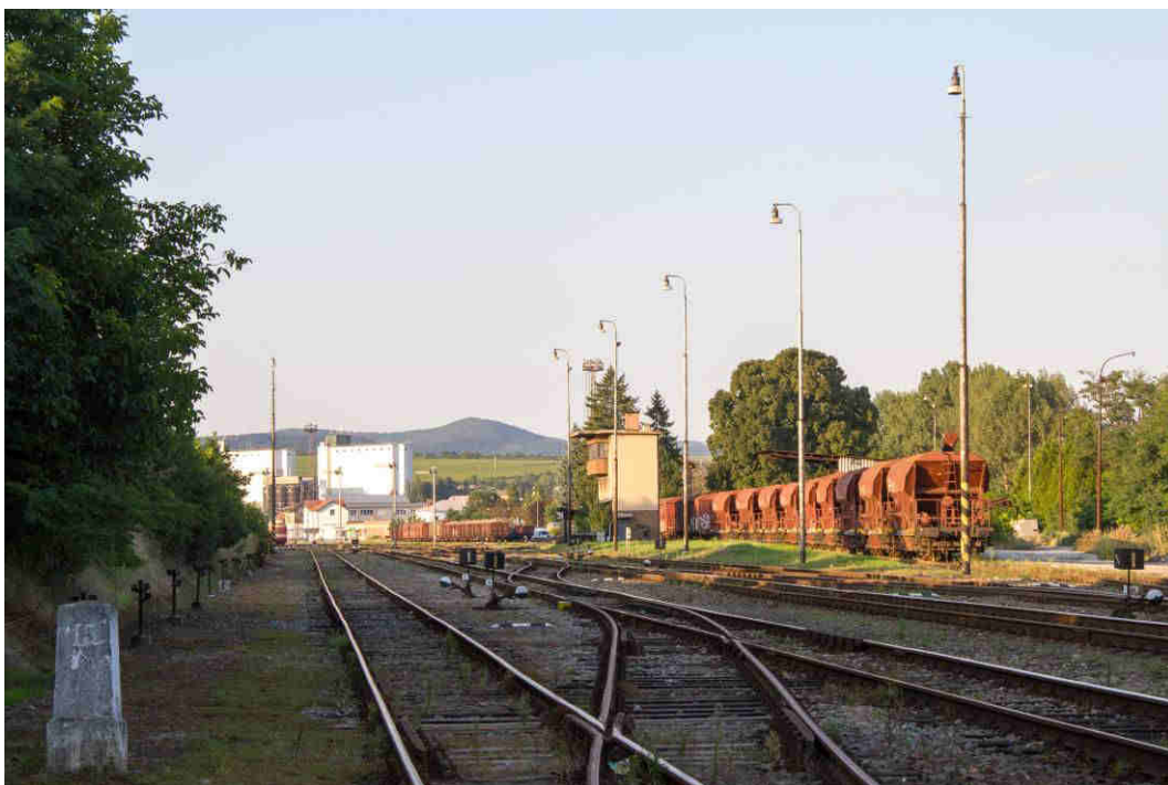
Obr. A5: Vlkošské zhlaví stanice.
