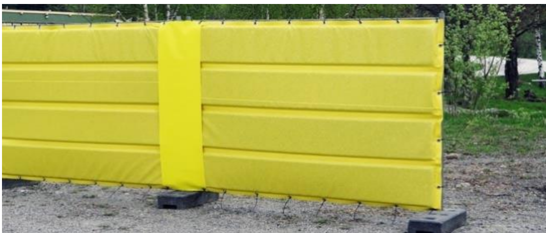
Obrázek 10 - Akustická zástěna a ochrana proti nadměrné prašnosti (dFence)
