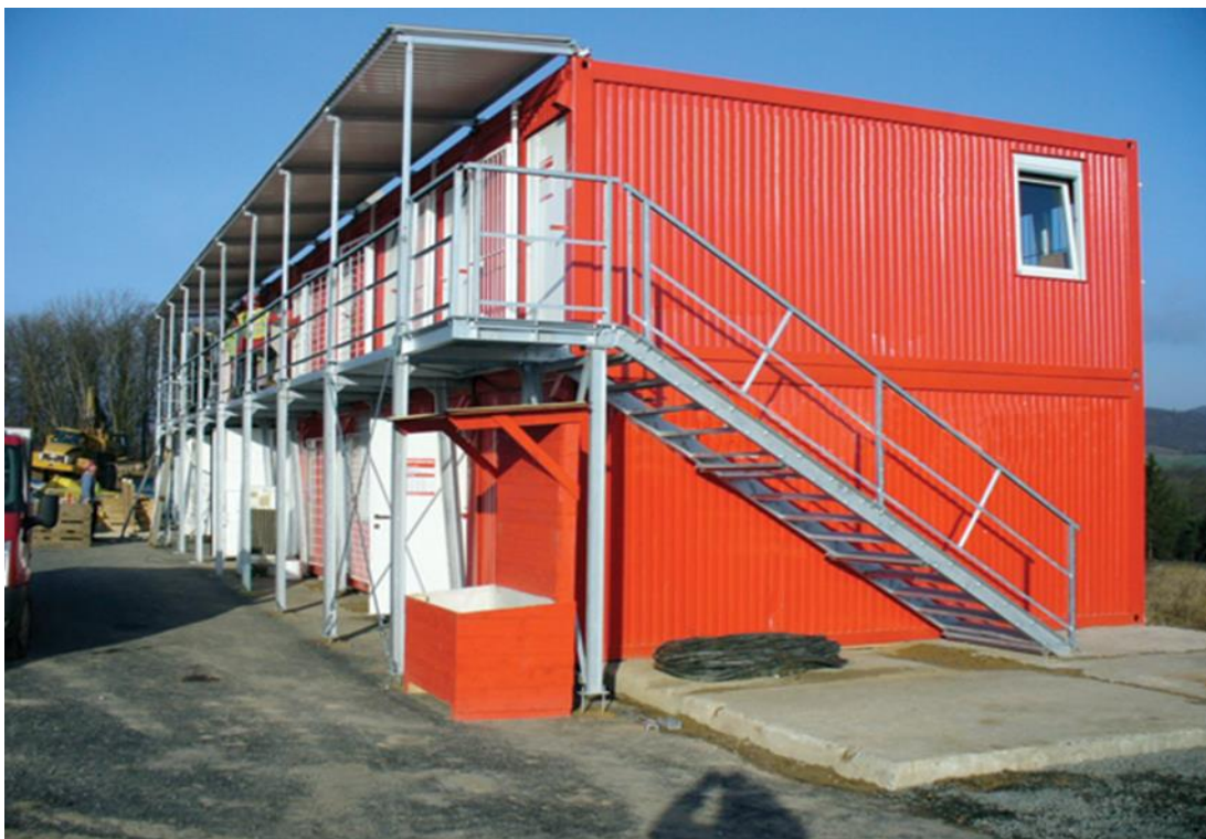
Obrázek 2 - Zařízení staveniště - stavební buňky (Převzato z www.stavebni-bunky.cz )
