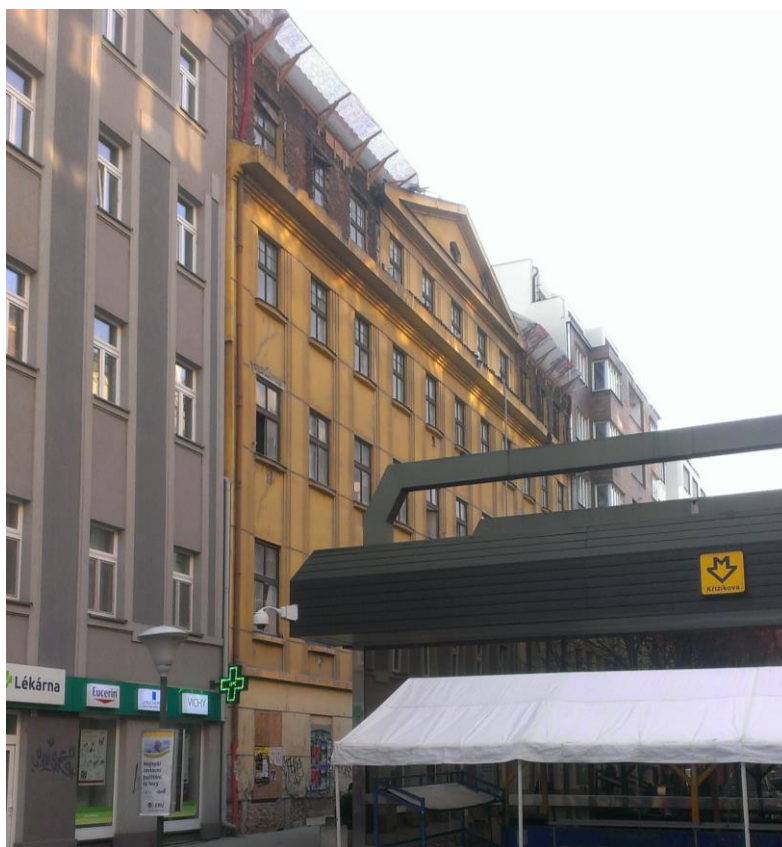
Obr. 3.1 – Fotografie bytového domu pořízená v dubnu 2016 (foto autor)
