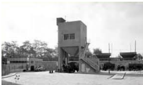
Obrázek č. 2: Plnicí stanice stlačeného svítiplynu v areálu Pražské obecní plynárny v Michli [3]
