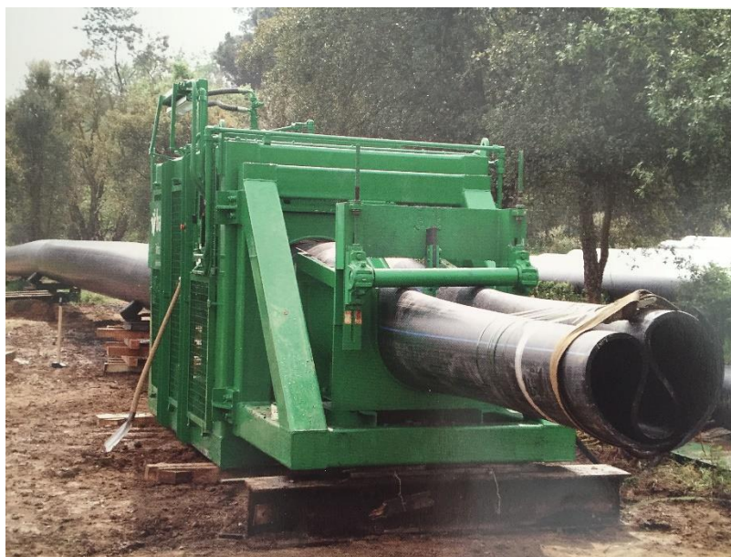
Obr. 12 – Technologie výstelky/vložky „na těsno“ (Close-Fit Lining)
