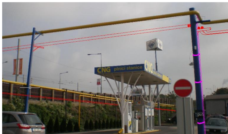
Obr. 20 – Pohled na potrubní most s možným jeho dalším smysluplným využitím
