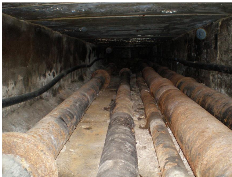
Obr. 15 – Ukázka VTTV areálu PRAGA Strašnice v multikanálech
