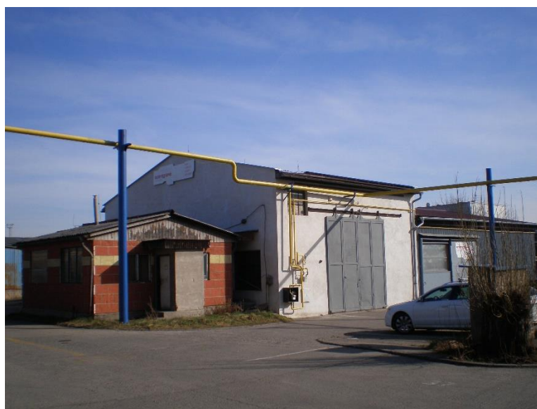
Obr. 16 – Ukázka vedení plynovodu nad zemí v areálu PRAGA Strašnice
