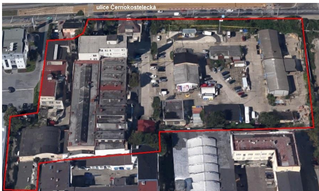
Obr. 14 – Areál PRAGA Strašnice
