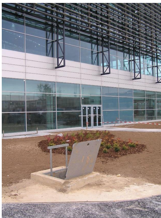
Obr. 27 – Ukázka vstupu do šachty jednoho z kolektorů areálu letiště
