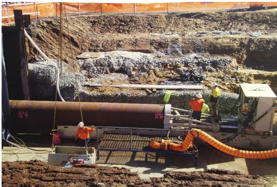
Obr. 44 – Technologie prostého štítování, příklad BT C.3/S1
