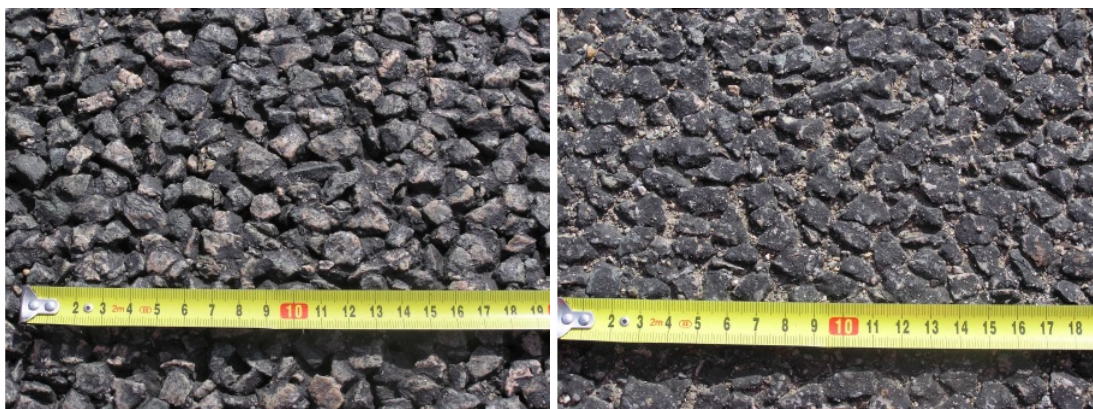
Obrázek 100 – Na obrázku možno vidět drenážní (porézní) kryt a běžný (uzavřený) kryt [8]
