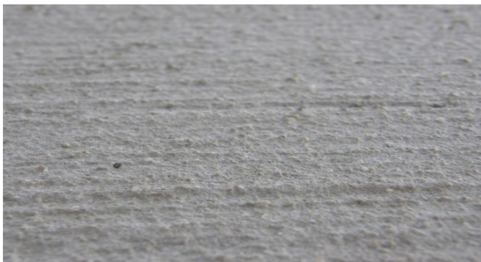
Obrázek 6 - Textura povrchu vytvořená vlečenou jutou
