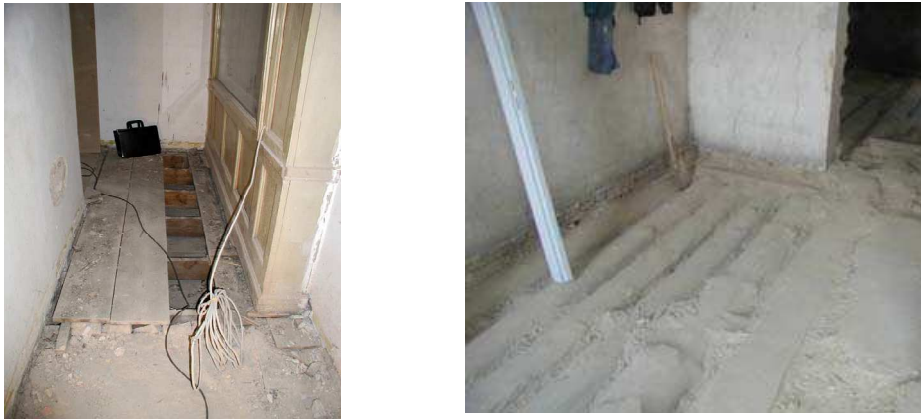
Obr. 11- a) Otevření záklopu (vlevo), b) Odkrytí násypu (vpravo) [9]
