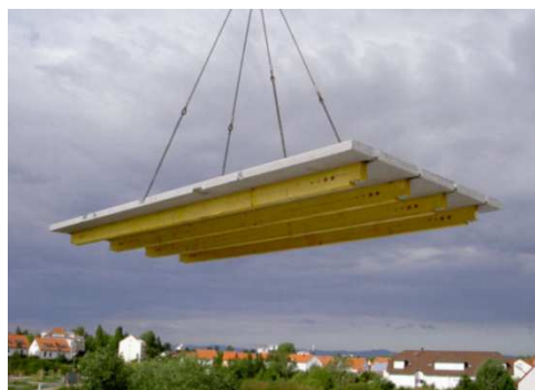
Obr. 19- a) HBV-Žebrový strop - výroba (vlevo) [IX], b) HBV-Žebrový strop - aplikace (vpravo) [IX]
