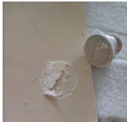
Obr. 21 Porušení podkladu A
