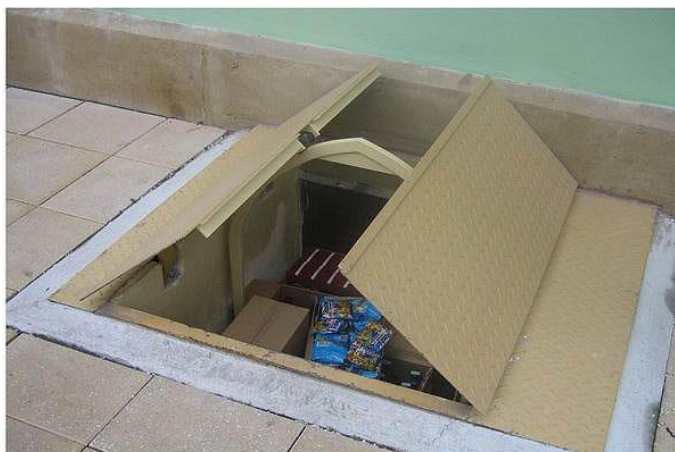
obr. 3.: Sklepní (stolový) výtah - bez plného stropu
