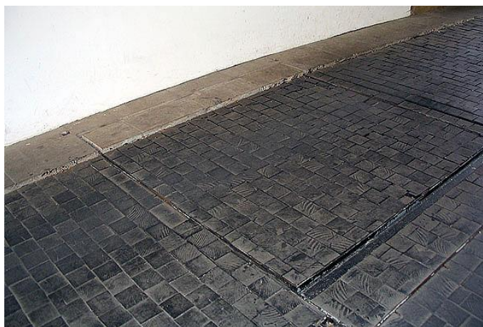
obr. 4.: Sklepní (stolový) výtah – s plným stropem
