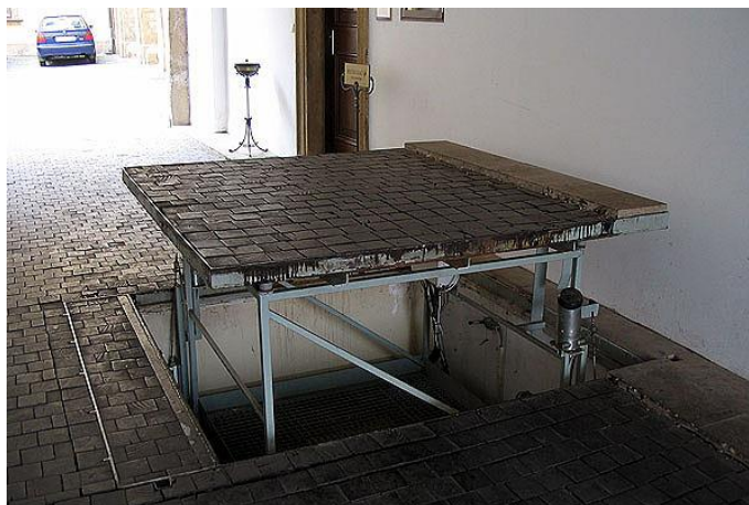
obr. 5.: Sklepní (stolový) výtah - s plným stropem
