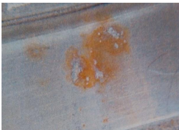
Obr. 5 – Důlkové napadání korozivzdorné oceli [18]
