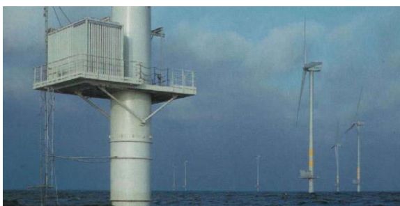
Obr. 32 – Windpark Utgrunden 2000, (Švédsko) [42]
