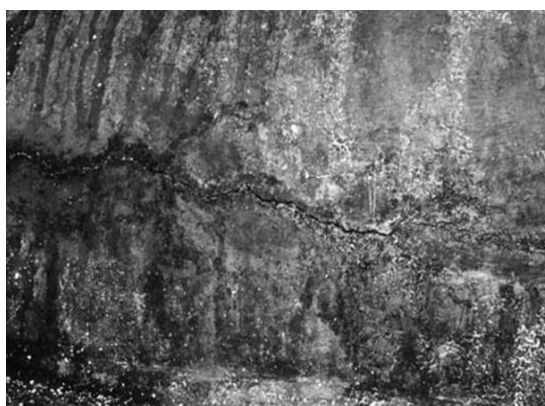
Obr. 7 – Korozní praskání korozivzdorné oceli [18]
