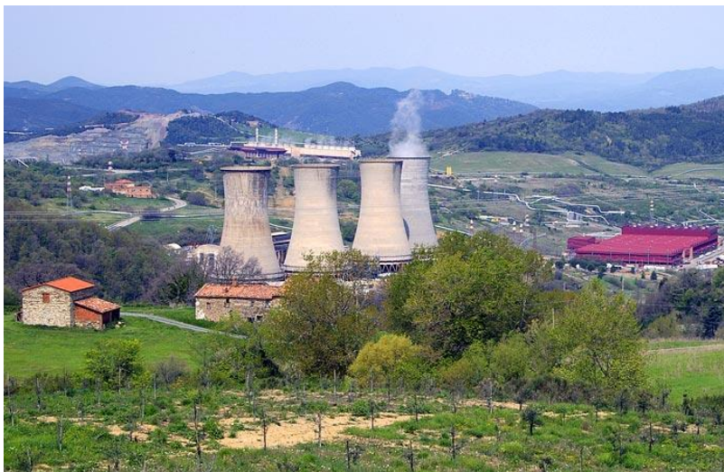
Larderello geotermální elektrárna (Itálie) Zdroj obrázku: [6]
