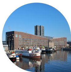
KOLLHOFF, Hans. Bytový dům Piraeus. Amsterdam, Nizozemsko. 1994.
