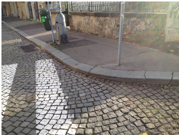
Obrázek 2.3 Ukázka bariérového přechodu pro chodce 1)
