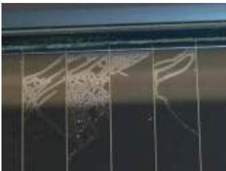
Obrázek 2.10. Delaminace TCO tenkovrstvého modulu.
