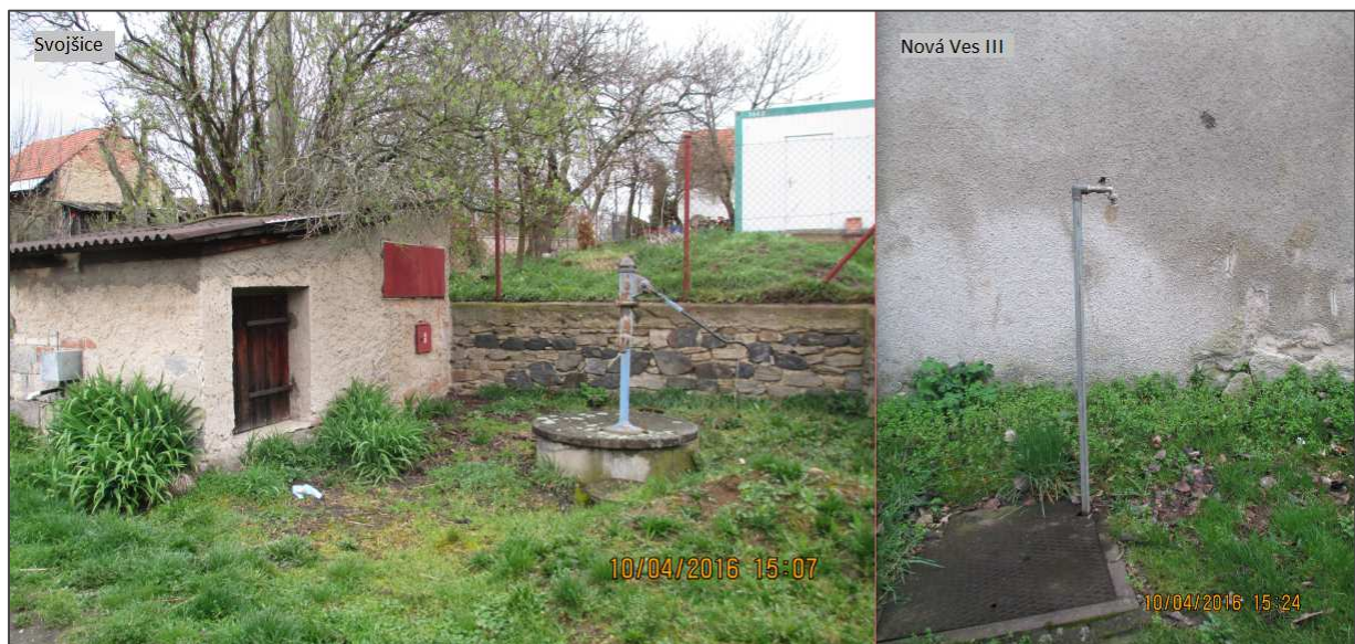
Obrázek 21 Obecní studna ve Svojšicích a Nové Vsi III [Zdroj: vlastní]
