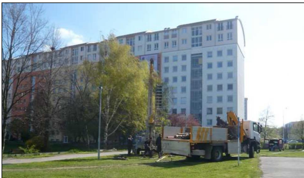
OBRÁZEK Č.06: Realizace vrtu J 1 vrtnou soupravou [4]
