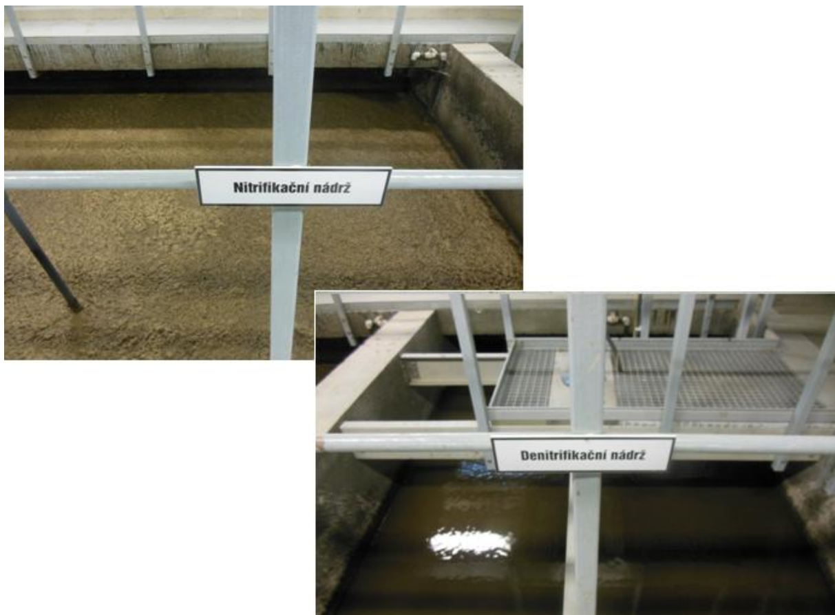
Obrázek 4.4: Procesy nitrifikace a denitrifikace
