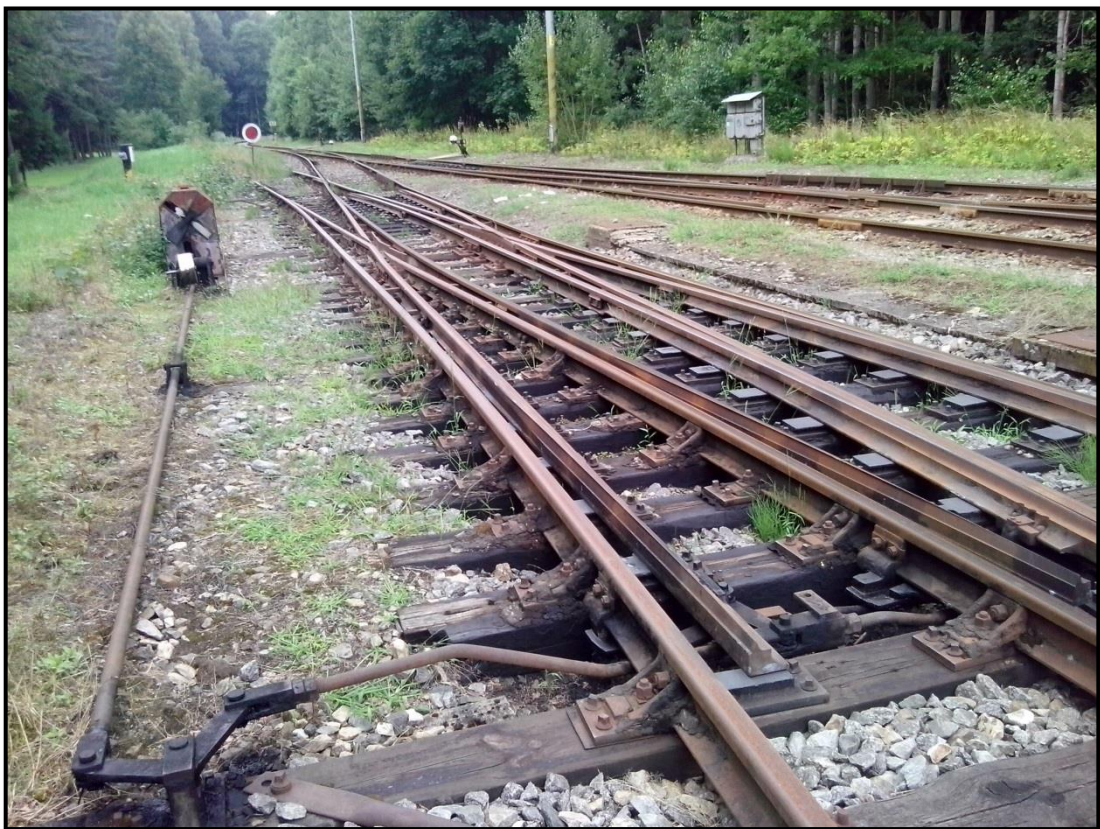
Obrázek 1.12: Křížovatková výhybka v píseckém zhlaví žst. Božejovice
