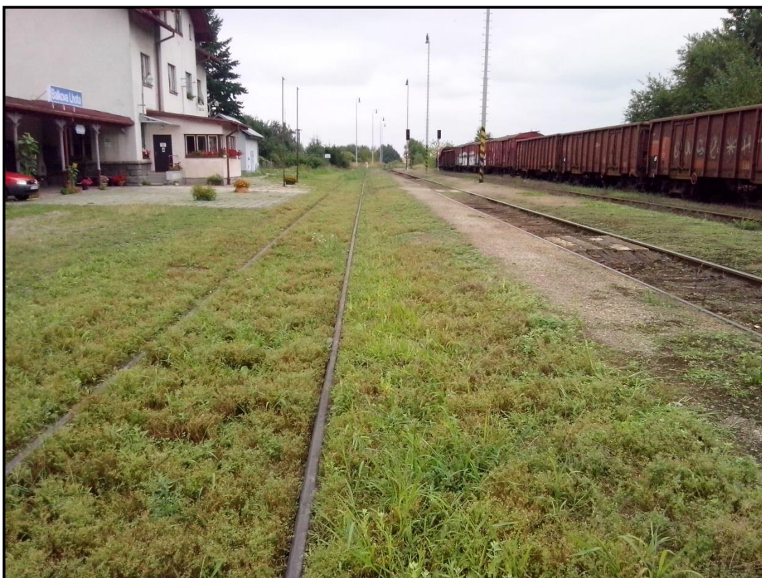
Obrázek 1.6: Žst. Balkova Lhota – pohled na sypaná nástupiště s takřka nulovou výškou nástupní hrany
