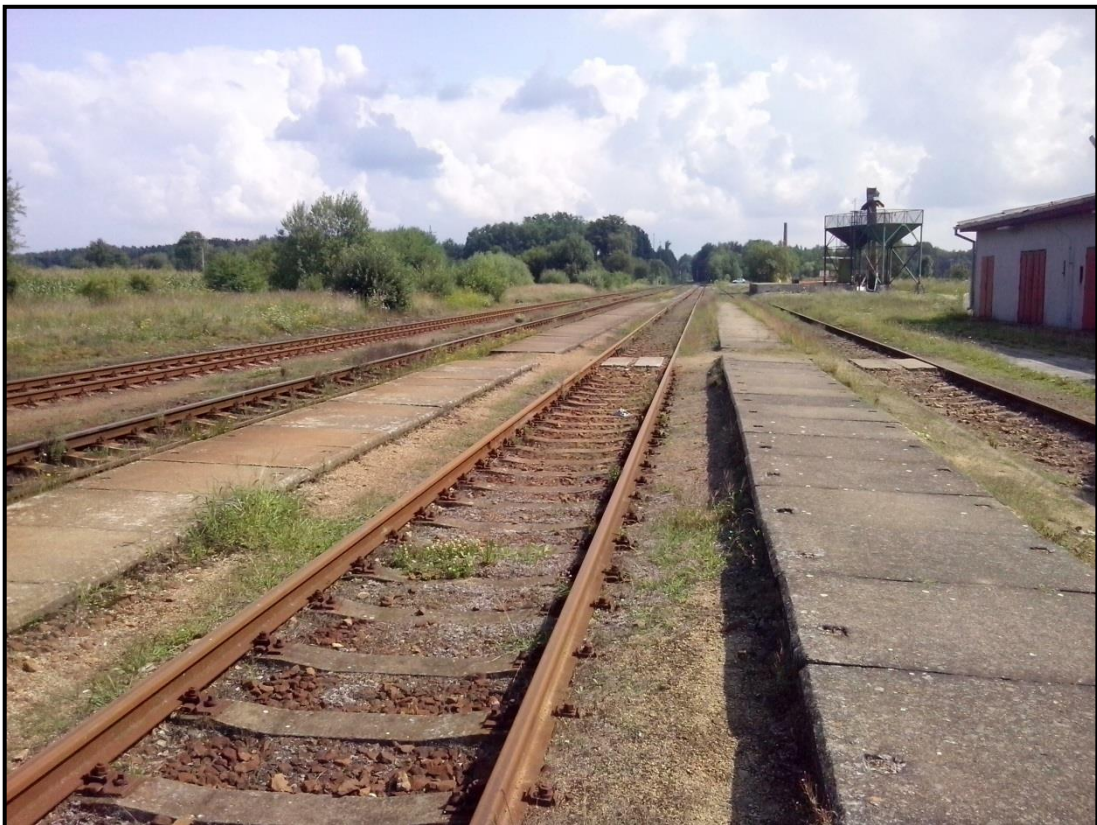
Obrázek 1.22: Žst. Branice – pohled na častá deskami zpevněná nástupiště
