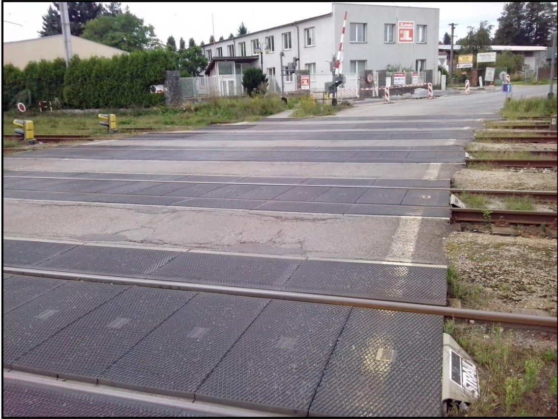
Obrázek 1.35: Úrovňový přejezd s přejížděním hned 6 kolejí najednou ve zhlaví žst. Písek
