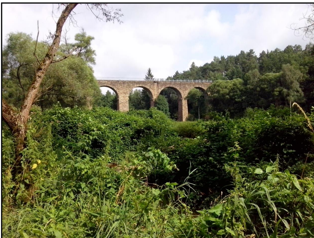
Obrázek 1.14: Železniční viadukt v úseku Božejovice – Sepekov
