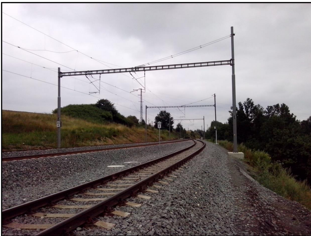
Obrázek 1.3: Odbočka železniční trati č. 201 od IV. TŽK
