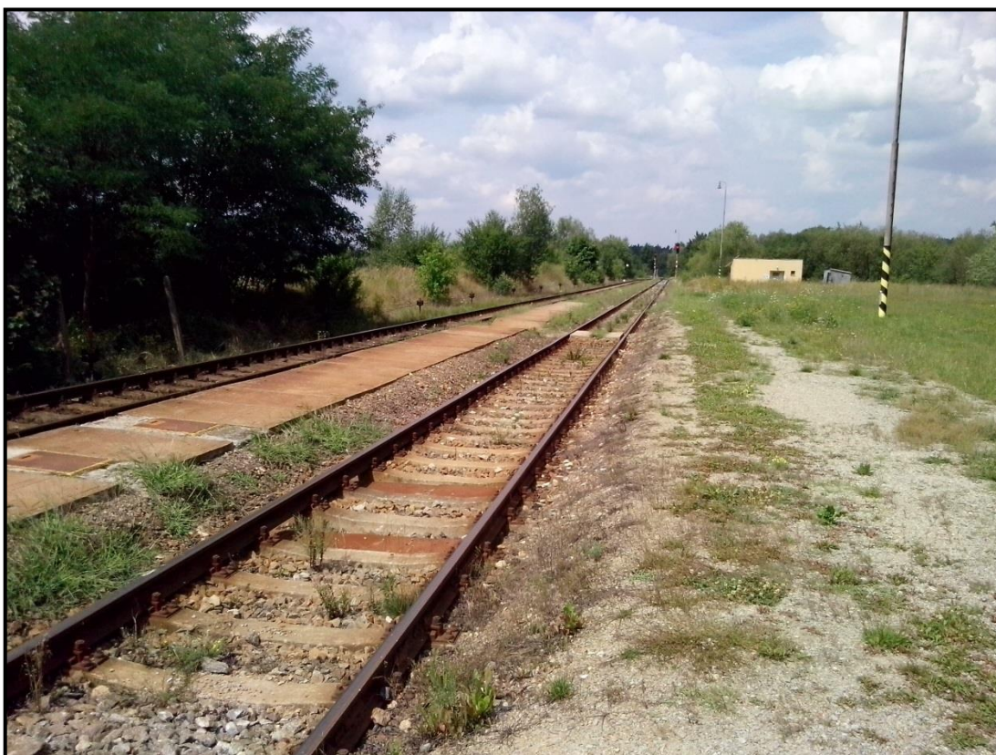
Obrázek 1.26: Pohled na sypané a deskové nástupiště v žst. Červená nad Vltavou
