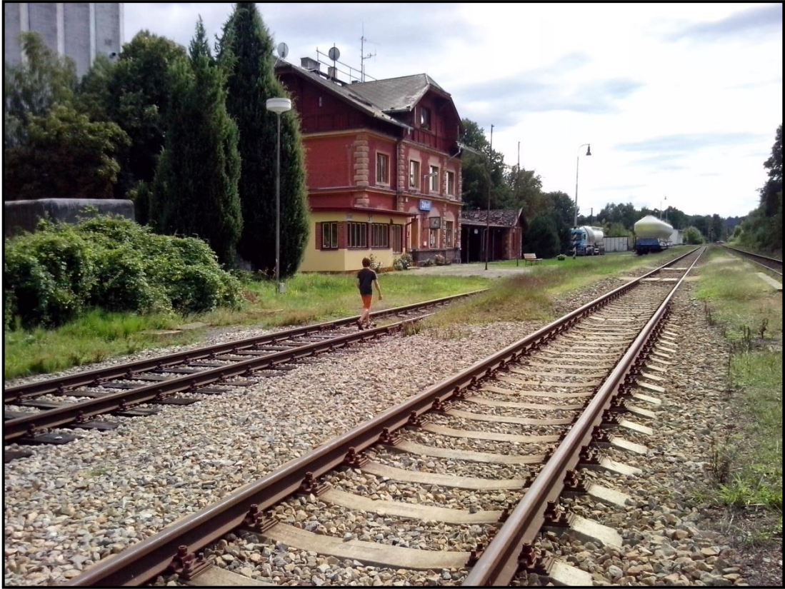
Obrázek 1.29: Pohled na kolejiště a výpravní budovu žst. Záhoří
