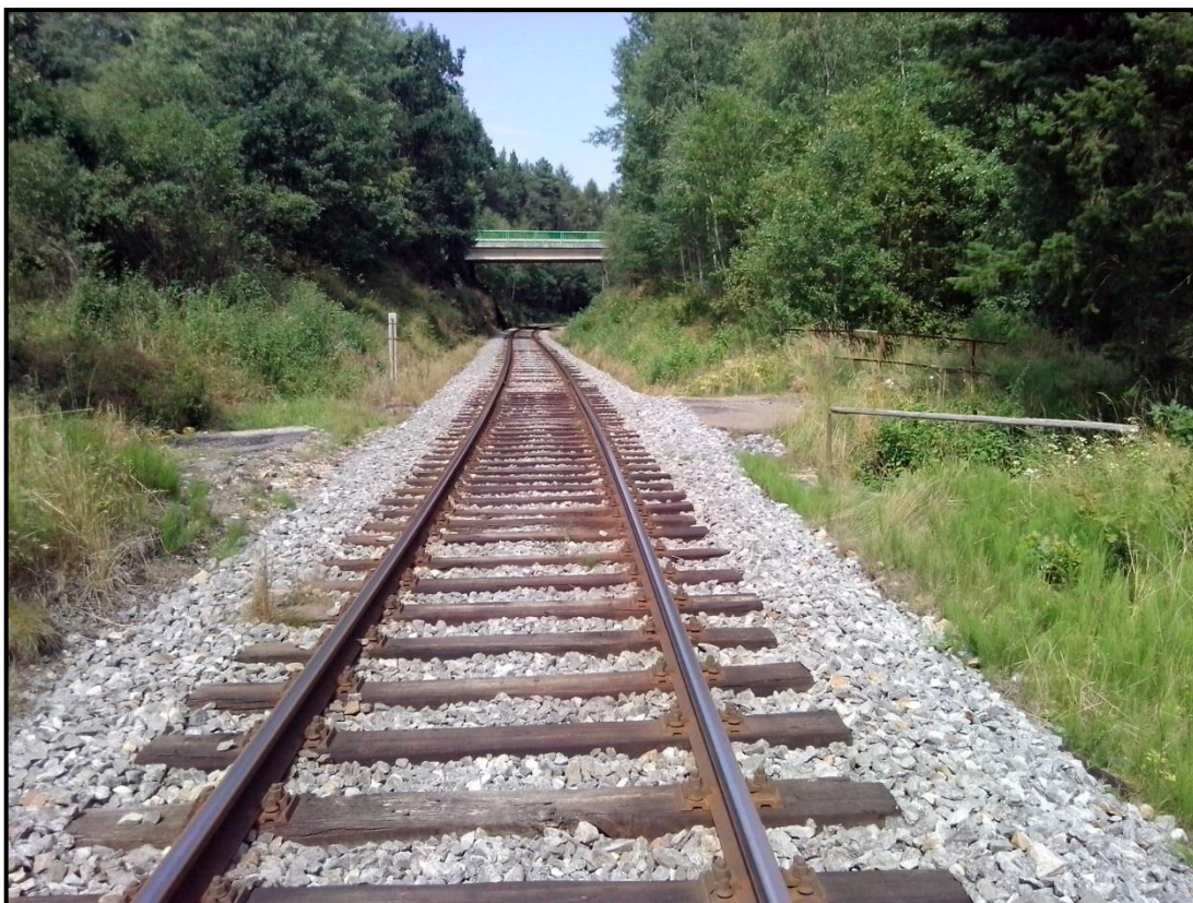
Obrázek 1.13: Silniční most komunikace I/19 a vpředu zbytky bývalého úrovněového přejezdu
