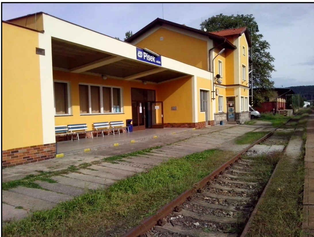
Obrázek 1.31: Opravená žst. Písek-město
