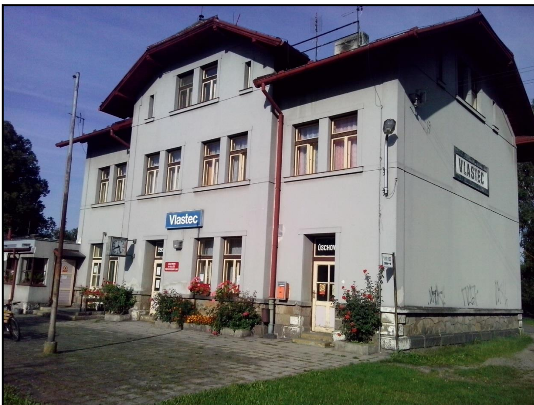
Obrázek 1.28: Výpravní budova žst. Vlastec
