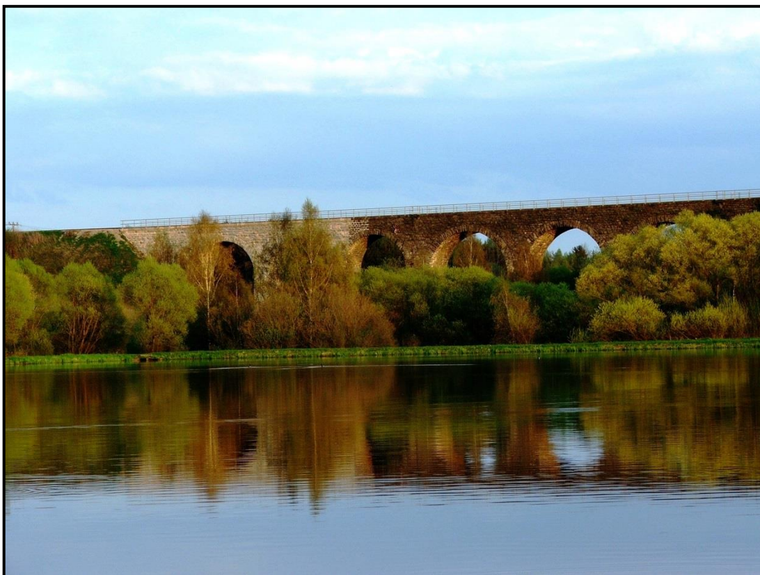
Obrázek 1.17: Opravovaný kamenný viadukt u žst. Milevsko
