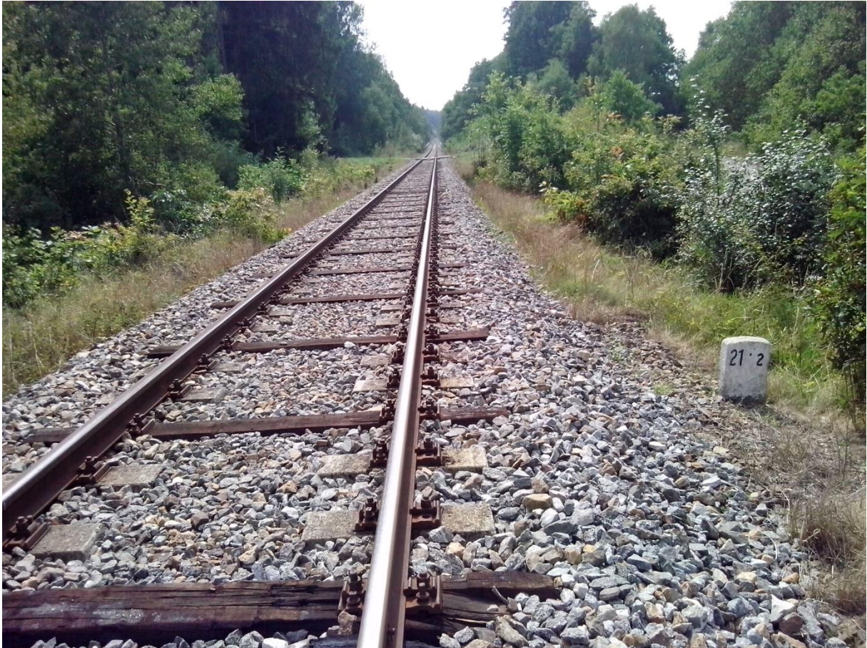
Obrázek 11: Dvoublokové betonové pražce DZP10 doplněné dřevěnými pro zvýšení stability geometrické polohy koleje v km 21,2
