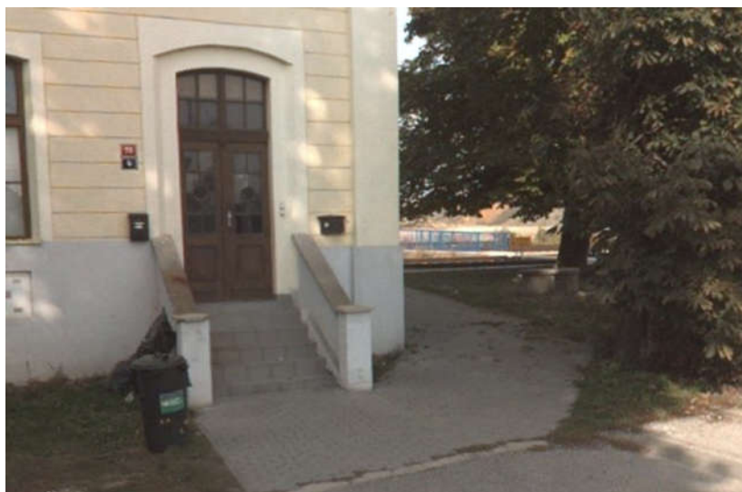
obr. č. 19 Příklad, kdy je vchod do výpravní budovy bariérový, ale existuje jiná bezbariérová cesta k nástupištím. Zdroj: Mapy.cz
