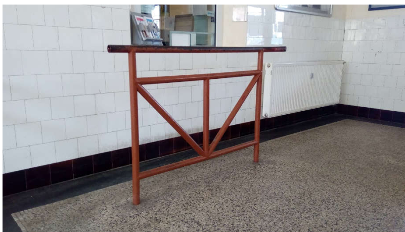
obr. č. 48 Zábradlí před výdejnou jízdenek, které tvoří bariéru pro osoby na vozíku [Zdroj: Autor]
