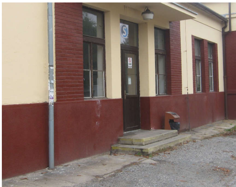
obr. č. 46 Vchod do výpravní budovy z přednádražního prostoru [Zdroj: Autor]
