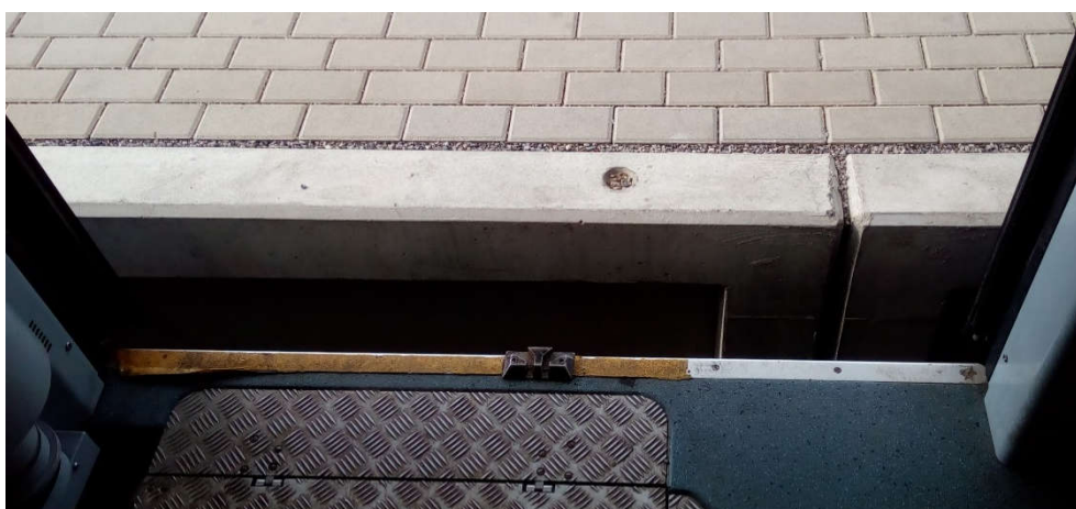
obr. č. 35 Mezera mezi vozidlem a nástupištěm u jednotek řady 471 [Zdroj: Autor]
