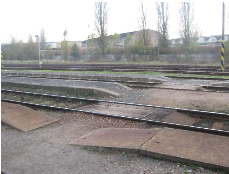
obr. č. 44 Úrovněný přístup k nástupišti ve stanici Praha – Čakovice [Zdroj: Autor]
