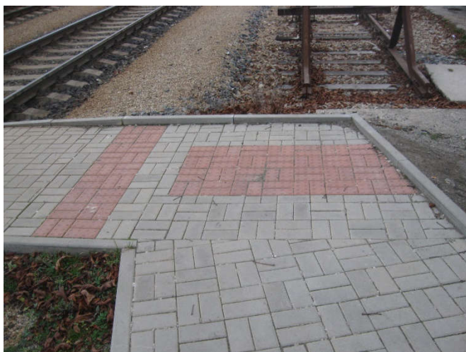
obr. č. 41 Signální pás centrálního přechodu v Rudné u Prahy [Zdroj: Autor]
