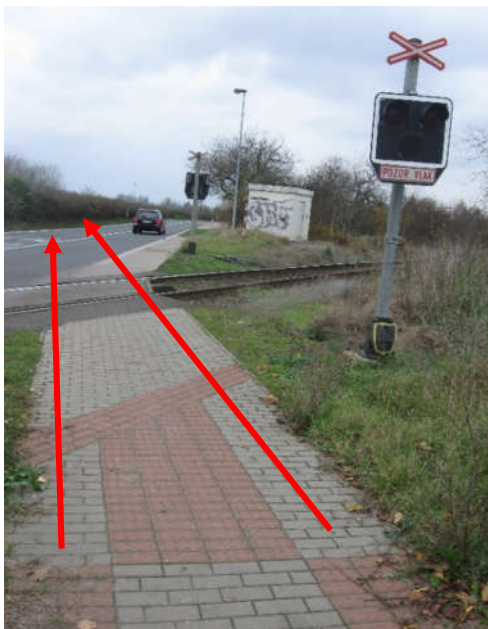
obr. č.55 Špatně vedená osa signálního pásu na přejezdu v ulici Hornopočernická [Zdroj: Autor]
