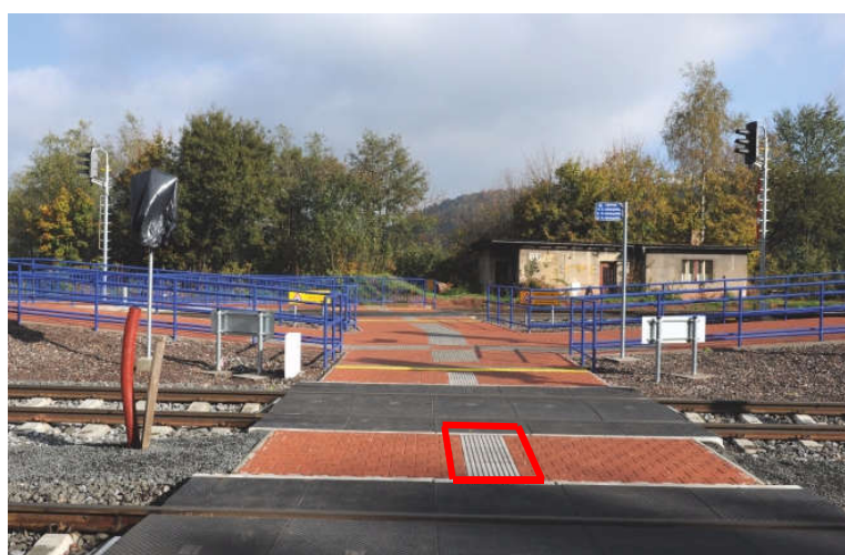
obr. č. 33 Úprava pro nevidomé na centrálním přechodu ve Staré Pace [Zdroj: [11]]
