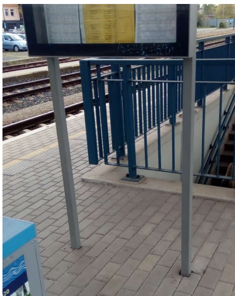
obr. č. 52 Nezajištěná informační tabule [Zdroj: Autor]
