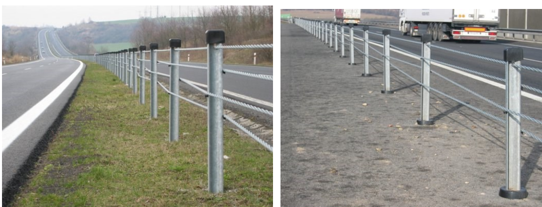
Obrázek 13 - Lanové svodidlo na dálnici D8 a komunikaci R63 [18]
