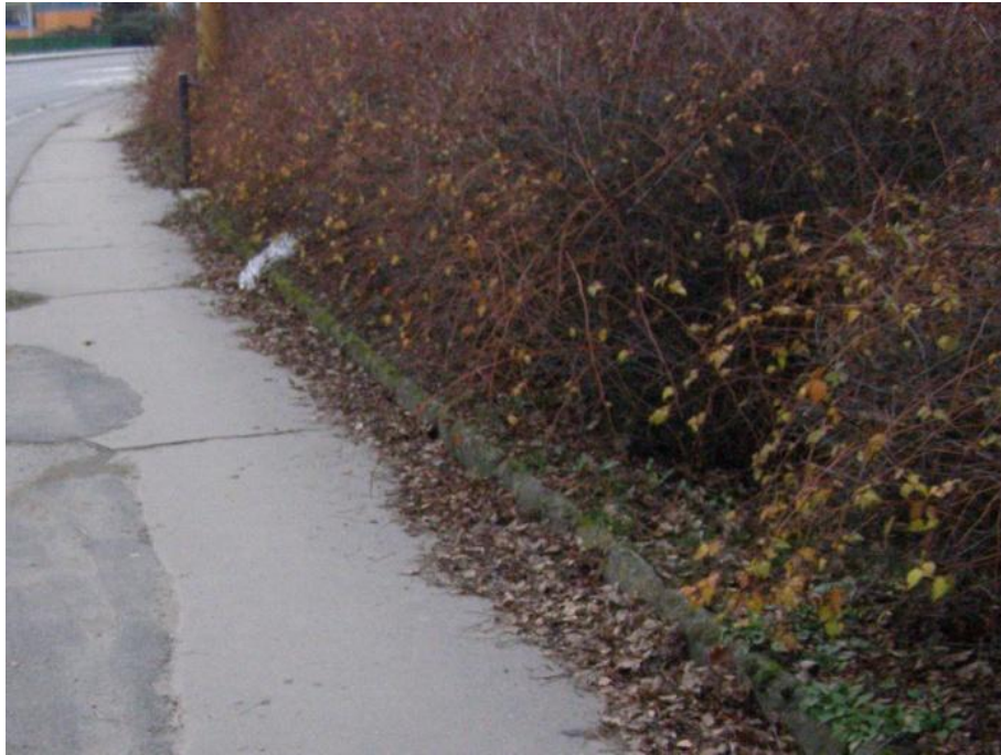
Obrázek 39 - Příklad okraje komunikace tvořeného vzrostlou zelení a zvýšeným obrubníkem [foto Jan Matoušek]
