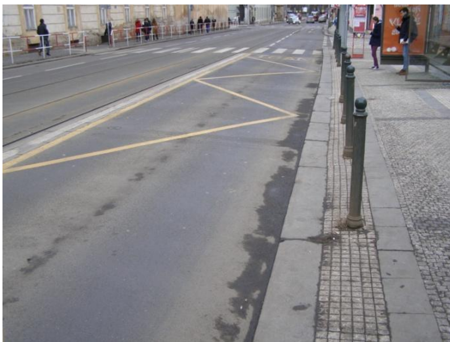
Obrázek 90 - Varovný pás u zvýšeného pojížděného mysu opatřený sloupky [foto Jan Matoušek]
