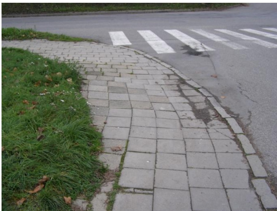
Obrázek 25 - Příklad bodové bariéry absence varovného pásu [foto Jan Matoušek]
