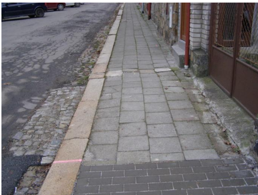
Obrázek 14 - Příklad mírně zvlněného povrchu s malými nerovnostmi [foto Jan Matoušek]
