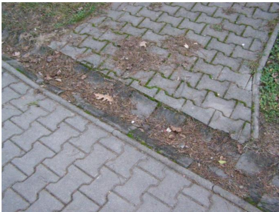
Obrázek 22 - Příklad bodové bariéry horizontální rozdíl [foto Jan Matoušek]
