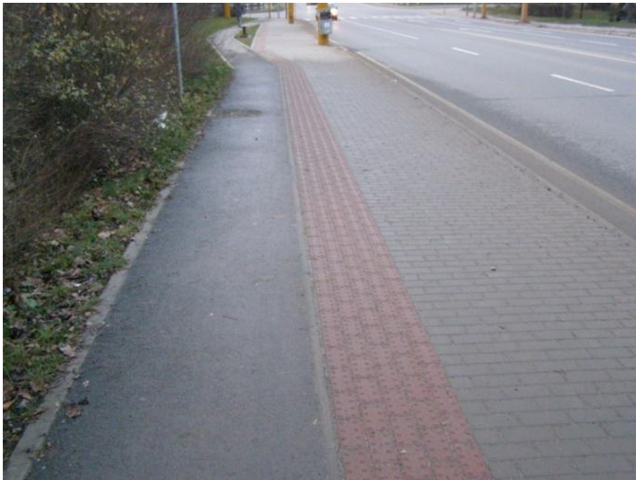
Obrázek 36 - Příklad okraje komunikace tvořeného zapuštěným obrubníkem a hmatným pásem [foto Jan Matoušek]
