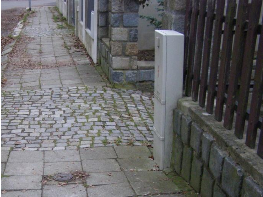
Obrázek 33 - Příklad okraje komunikace tvořeného podezdívkou, soklem [foto Jan Matoušek]
