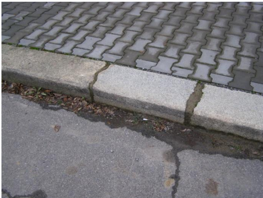
Obrázek 30 - Příklad úrovňového obrubníku [foto Jan Matoušek]
