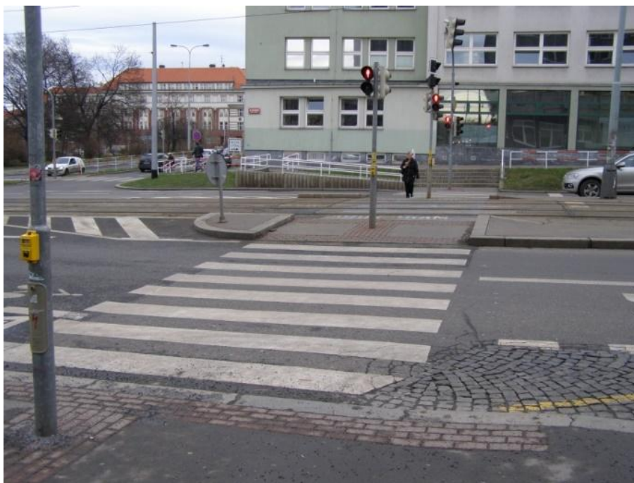
Obrázek 55 - Dělený přechod pro chodce s koridorem pro přechod tramvajového pásu uprostřed komunikace [foto Jan Matoušek]
