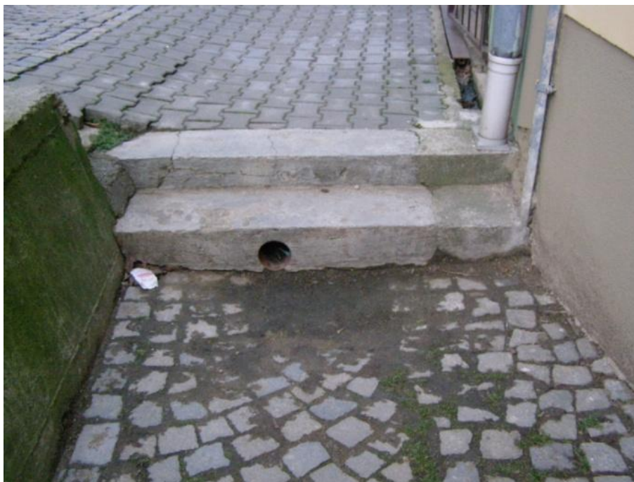
Obrázek 21 - Příklad bodové bariéry vertikální rozdíl [foto Jan Matoušek]
