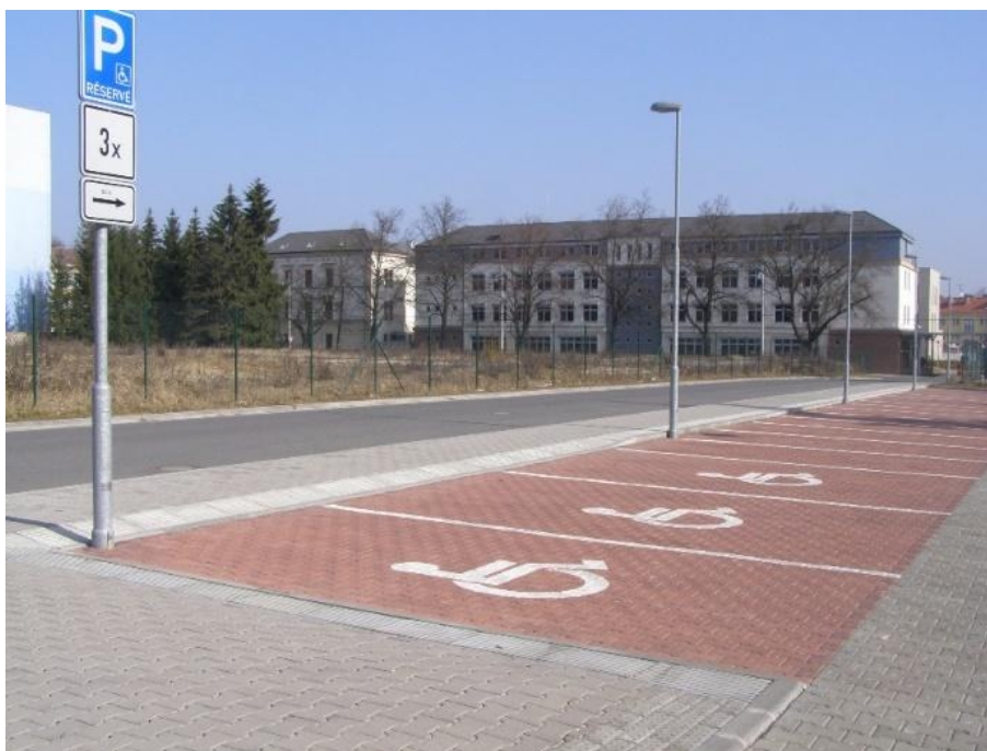
Obrázek 46 - Kolmé vyhrazené parkovací místo s přístupem z komunikace pro pěší přes šikmou plochu [foto Jan Matoušek]
