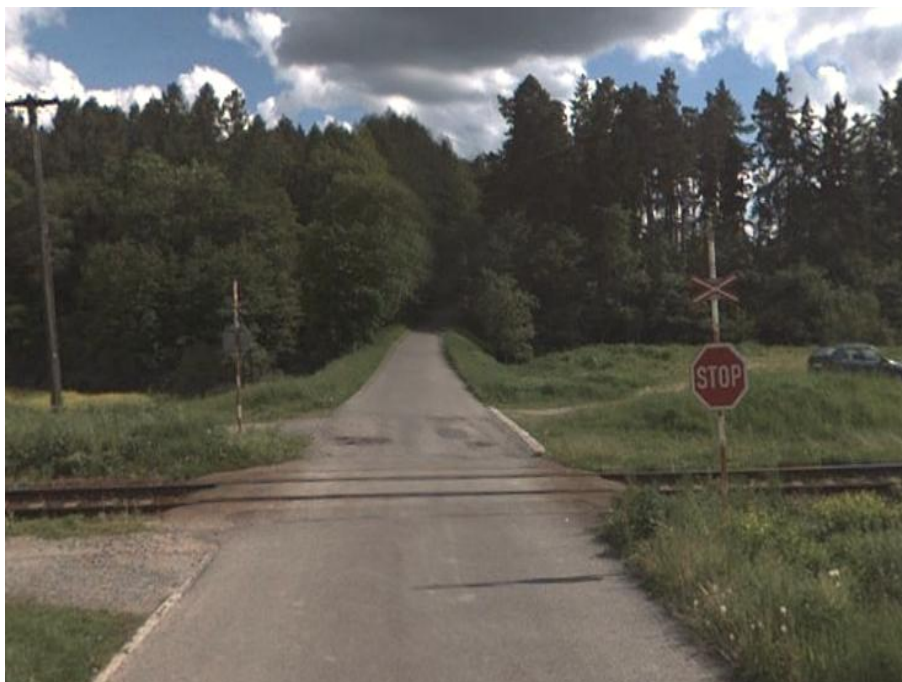
Obrázek 92 - Přejezd přes jednokolejnou trať zabezpečený pouze výstražným křížem s pohybem chodců po vozovce pozemní komunikace [foto Jan Matoušek]
