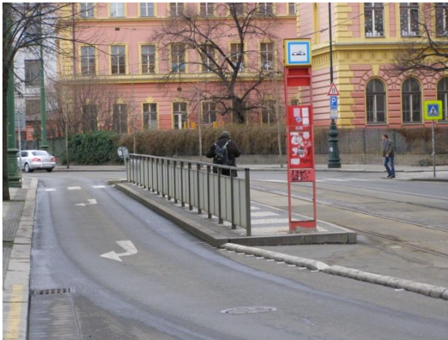
Obrázek 91 - Zastávka na ostrůvku opatřená zábradlím a přístupná přes přechod pro chodce [foto Jan Matoušek]
