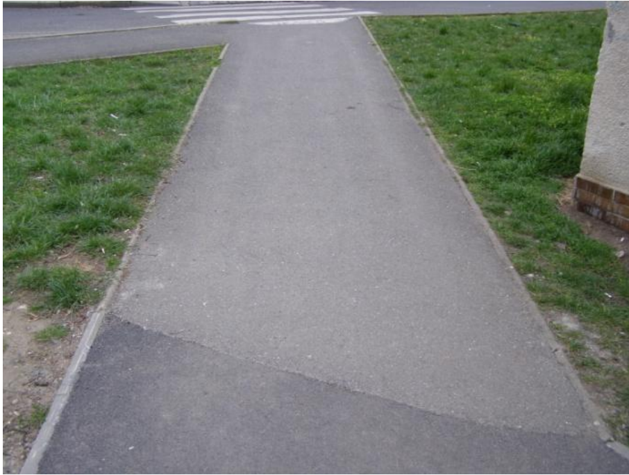
Obrázek 16 - Příklad povrchu bez poruch [foto Jan Matoušek]
