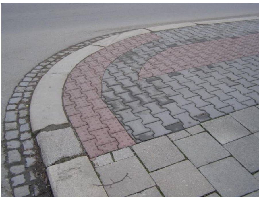
Obrázek 6 - Příklad povrchu z betonové dlažby [foto Jan Matoušek]
