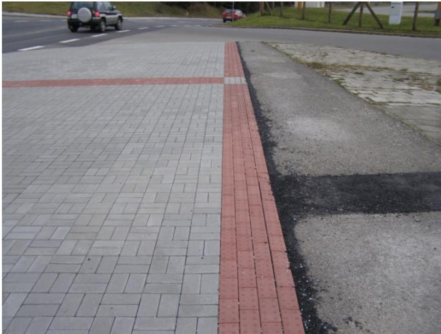
Obrázek 35 - Příklad okraje komunikace tvořeného umělou vodící linií [foto Jan Matoušek]
