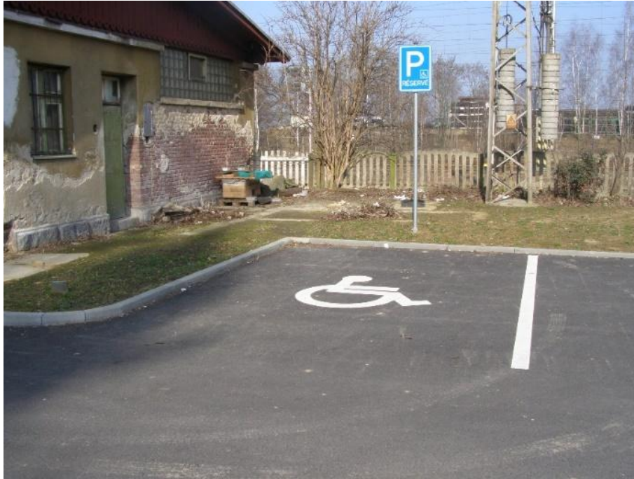
Obrázek 44 - Kolmé vyhrazené parkovací místo s přístupem z úrovně pozemní komunikace [foto Jan Matoušek]
