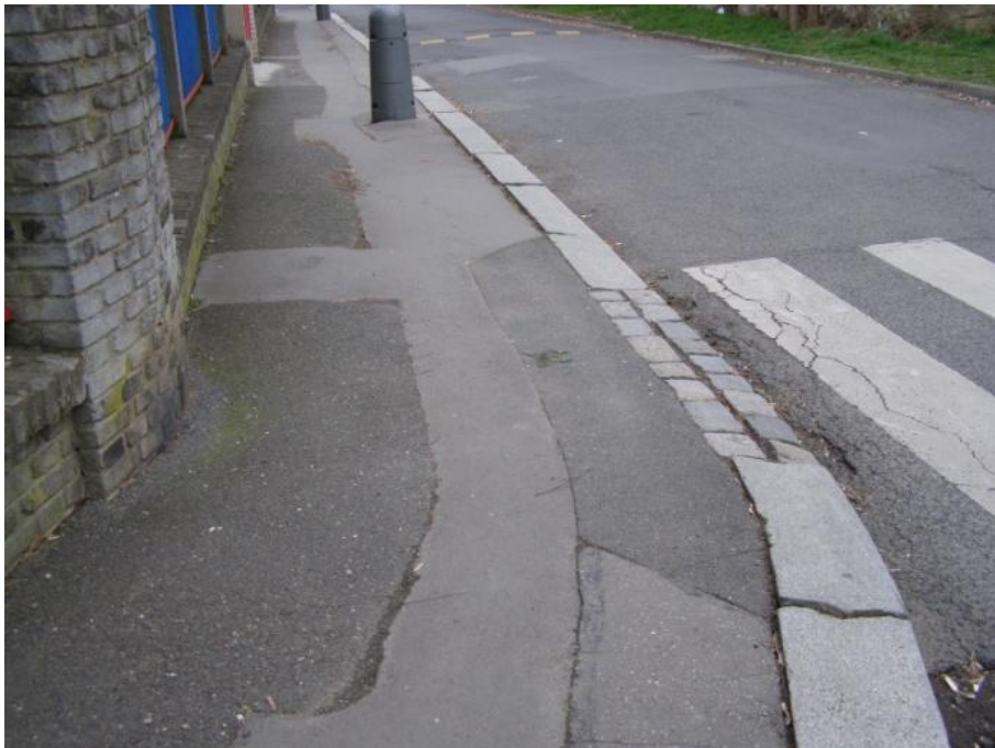
Obrázek 17 - Příklad povrchu s menšími poruchami [foto Jan Matoušek]
