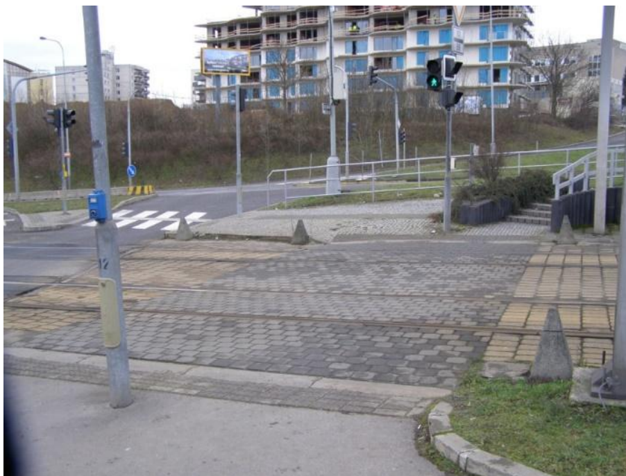
Obrázek 62 - Samostatný koridor pro přecházení tramvajového pásu [foto Jan Matoušek]
