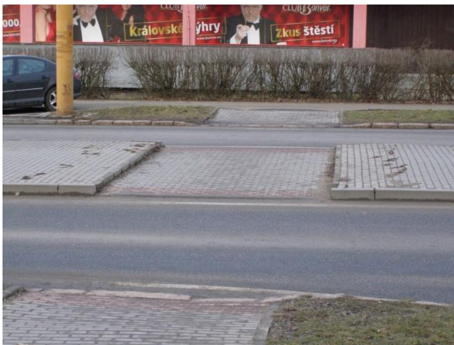
Obrázek 58 - Místo pro přecházení dělené středním dělicím pásem [foto Jan Matoušek]
