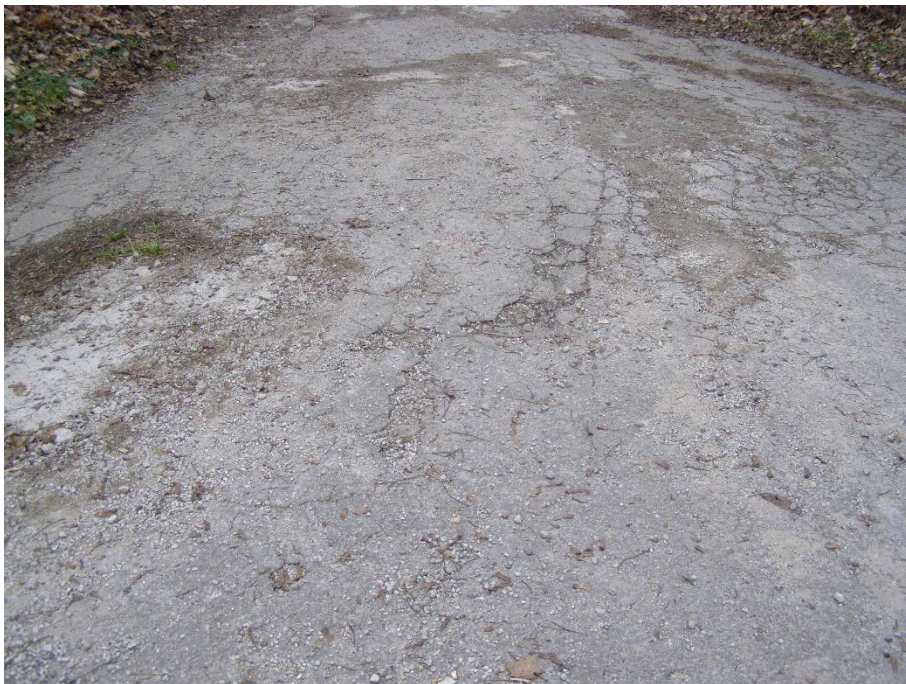
Obrázek 20 - Příklad povrchu s velkou četností poruch [foto Jan Matoušek]
