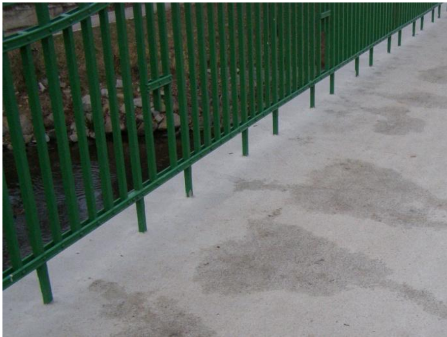
Obrázek 38 - Příklad okraje komunikace tvořeného zábradlím [foto Jan Matoušek]
