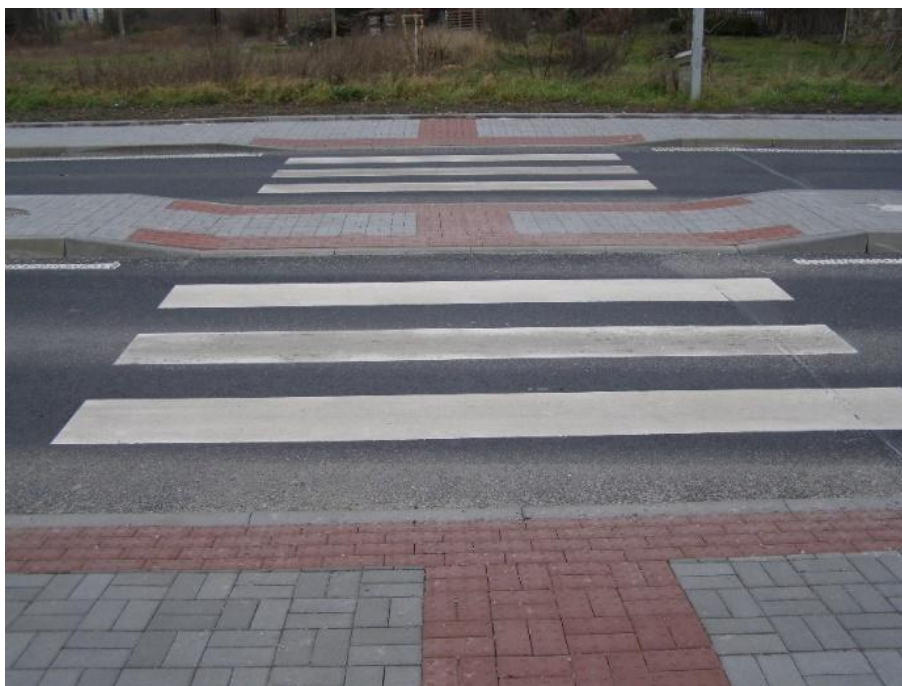
Obrázek 53 - Přechod pro chodce dělený středním dělicím ostrůvkem [foto Jan Matoušek]
