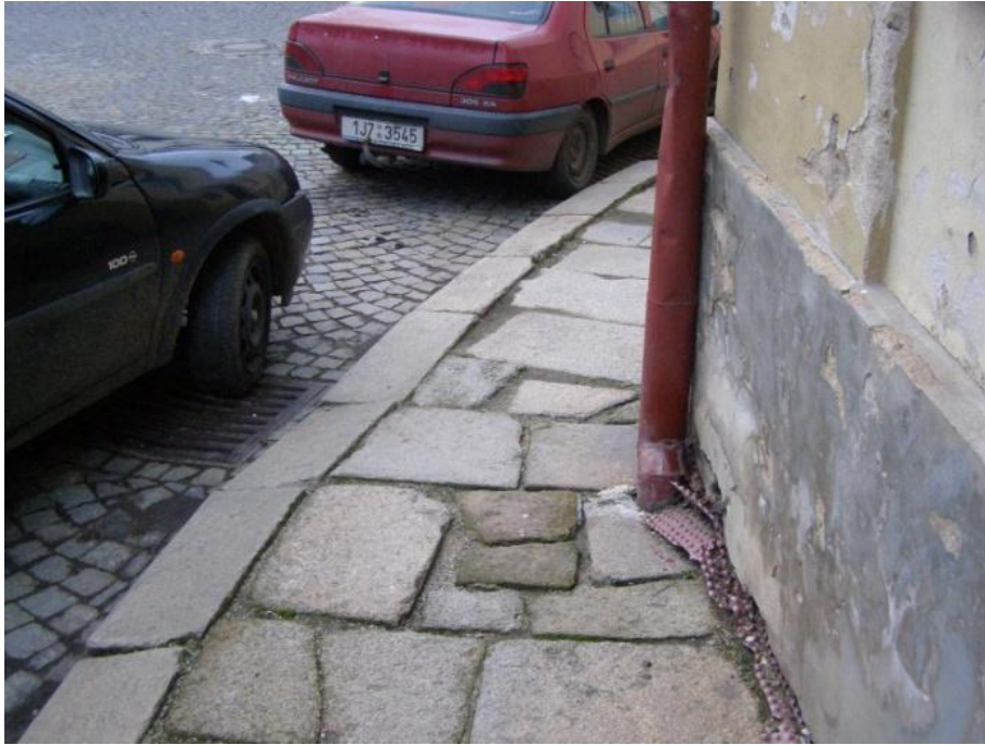
Obrázek 23 - Příklad bodové bariéry lokální zúžení [foto Jan Matoušek]
