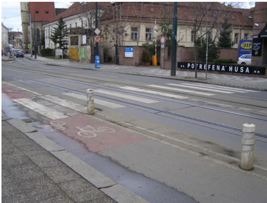
Obrázek 54 - Nedělený přechod pro chodce přes komunikaci s tramvajový pásem [foto Jan Matoušek]
