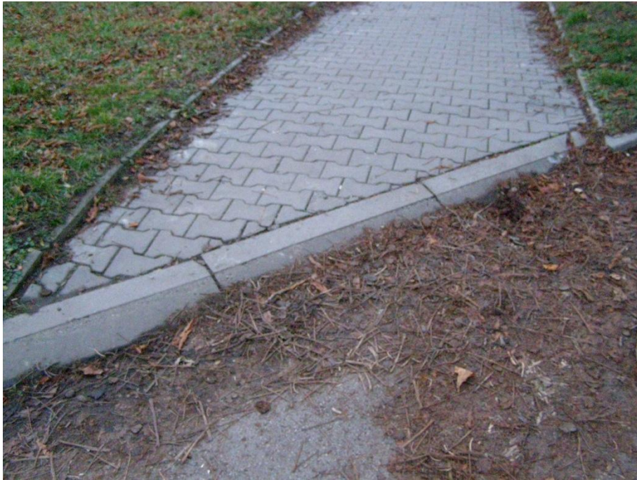
Obrázek 47 - Příklad sklopeného obrubníku [foto Jan Matoušek]
