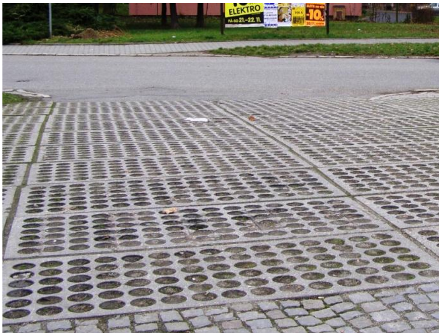
Obrázek 5 - Příklad povrchu z betonových panelů [foto Jan Matoušek]
