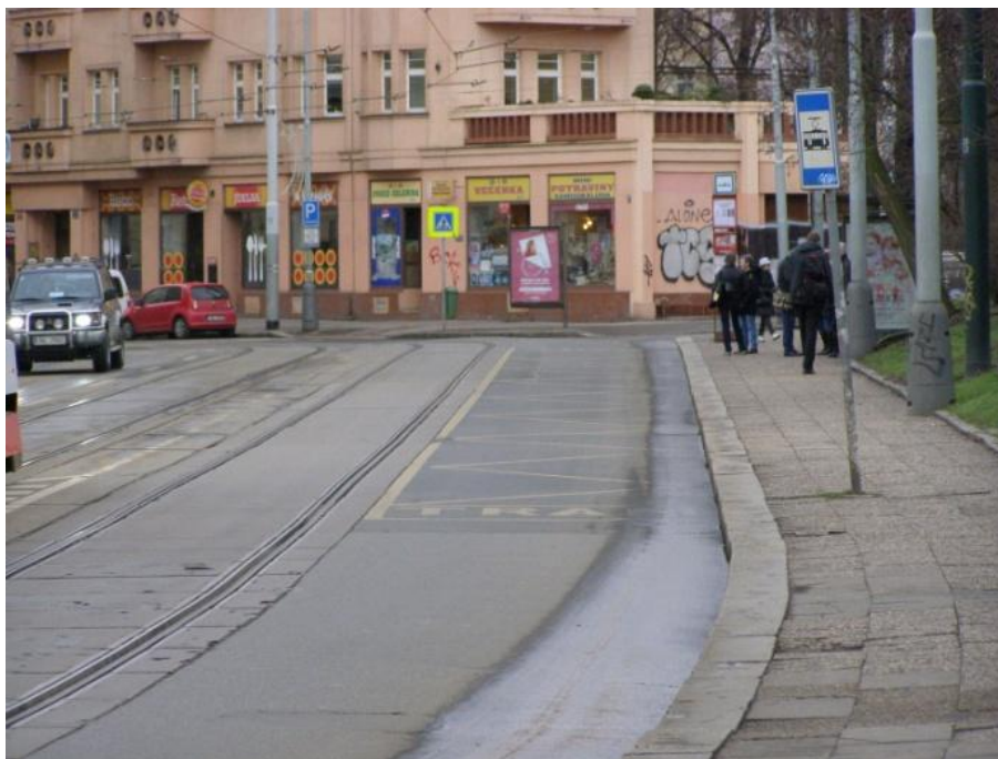
Obrázek 77 - Zastávka na chodníku bez přilehlé nástupní hrany [foto Jan Matoušek]
