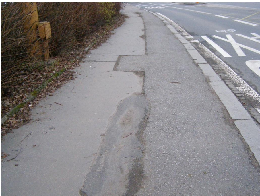
Obrázek 4 - Příklad povrchu z litého asfaltu [foto Jan Matoušek]
