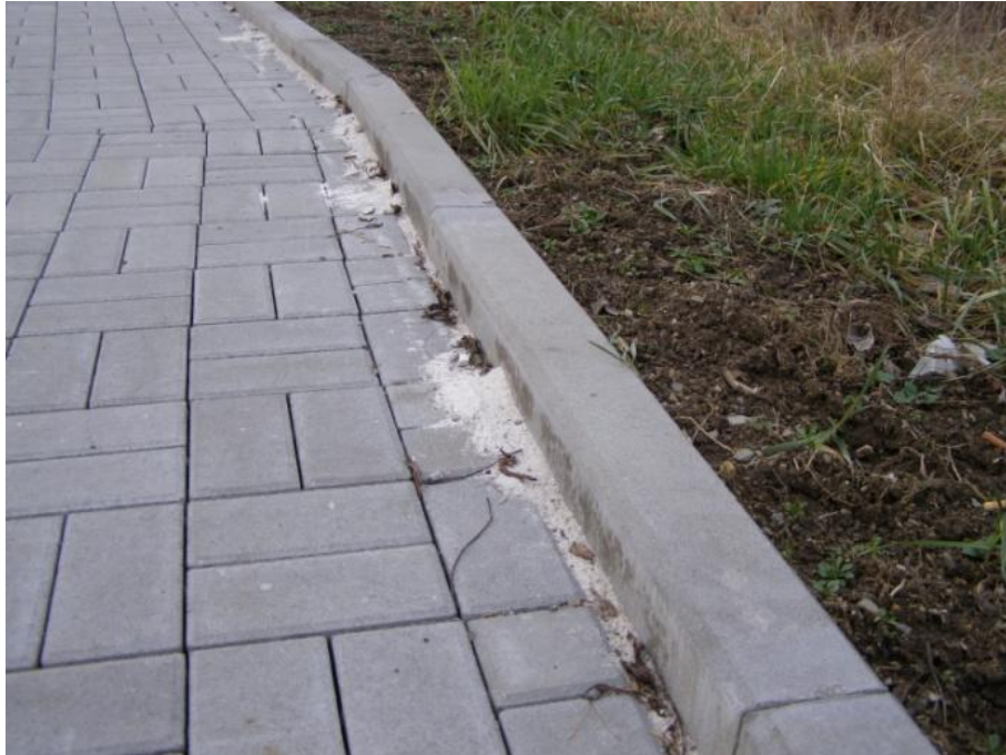
Obrázek 29 - Příklad zvýšeného obrubníku [foto Jan Matoušek]
