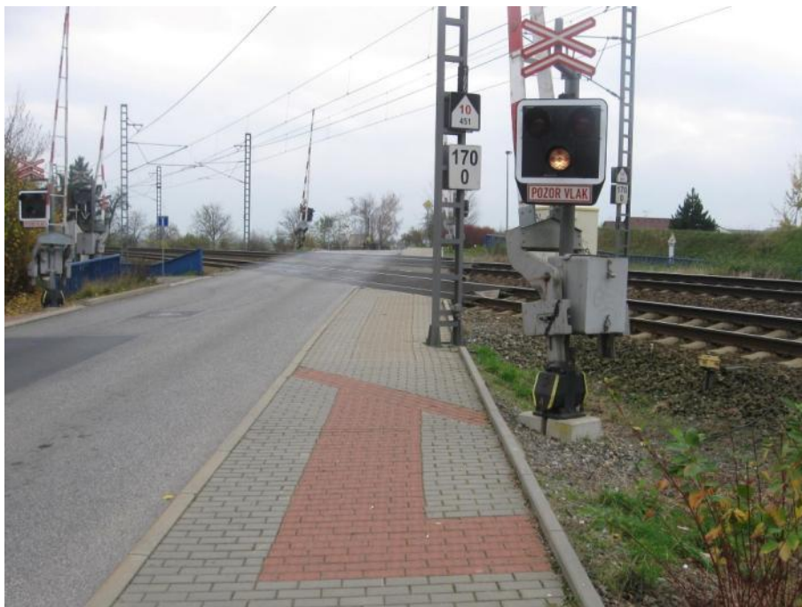
Obrázek 94 - Přejod s přejezdem přes dvoukolejnou trať s přejezdovým zabezpečovacím zařízením bez závor s pohybem chodců po komunikace pro pěší přilehlé k vozovce pozemní komunikace [foto Filip Jakl]
