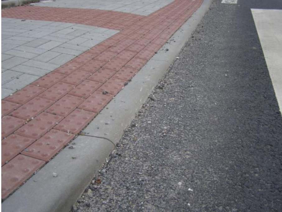
Obrázek 31 - Příklad sníženého obrubníku [foto Jan Matoušek]
