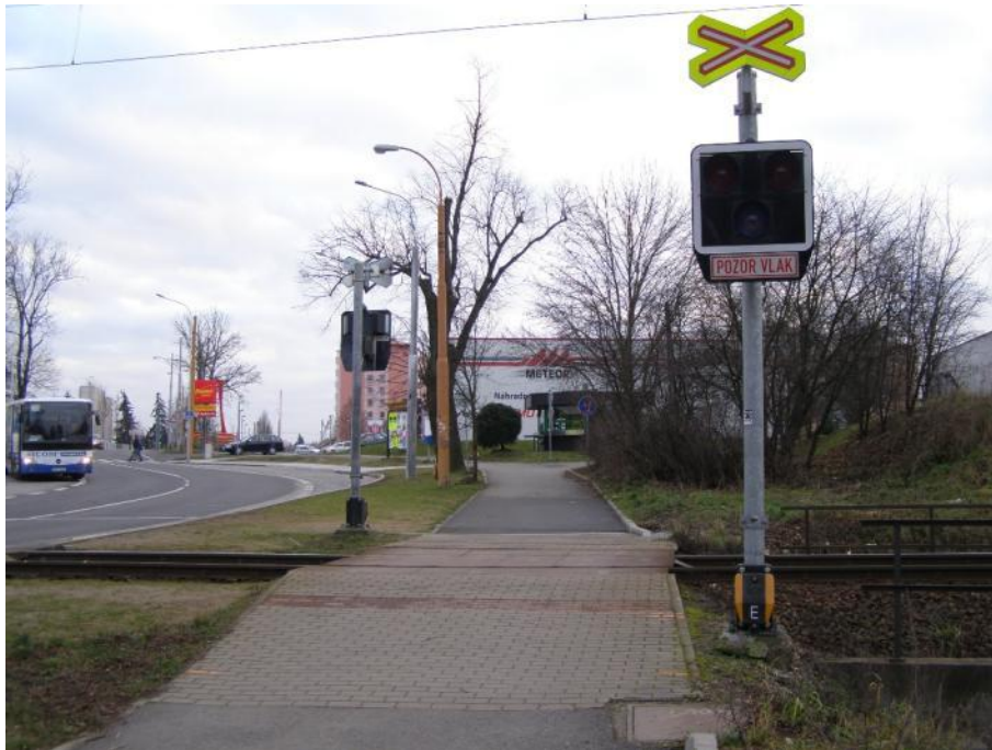
Obrázek 93 - Přejod přes jednokolejnou trať s přejezdovým zabezpečovacím zařízením bez závor s pohybem chodců po samostatné komunikaci pro pěší [foto Jan Matoušek]
