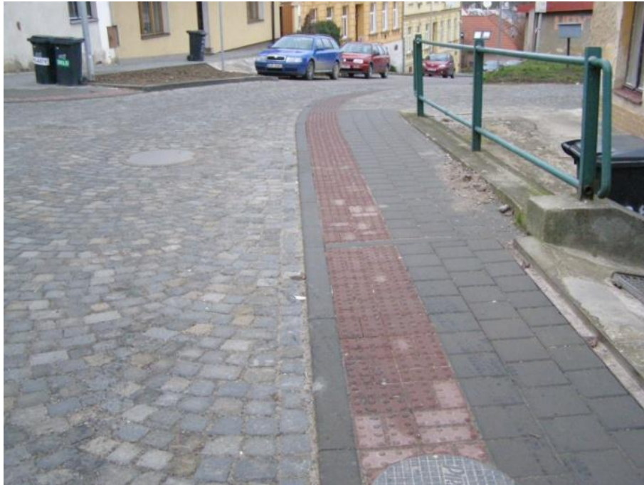
Obrázek 37 - Příklad varovného pásu podél sníženého obrubníku [foto Jan Matoušek]
