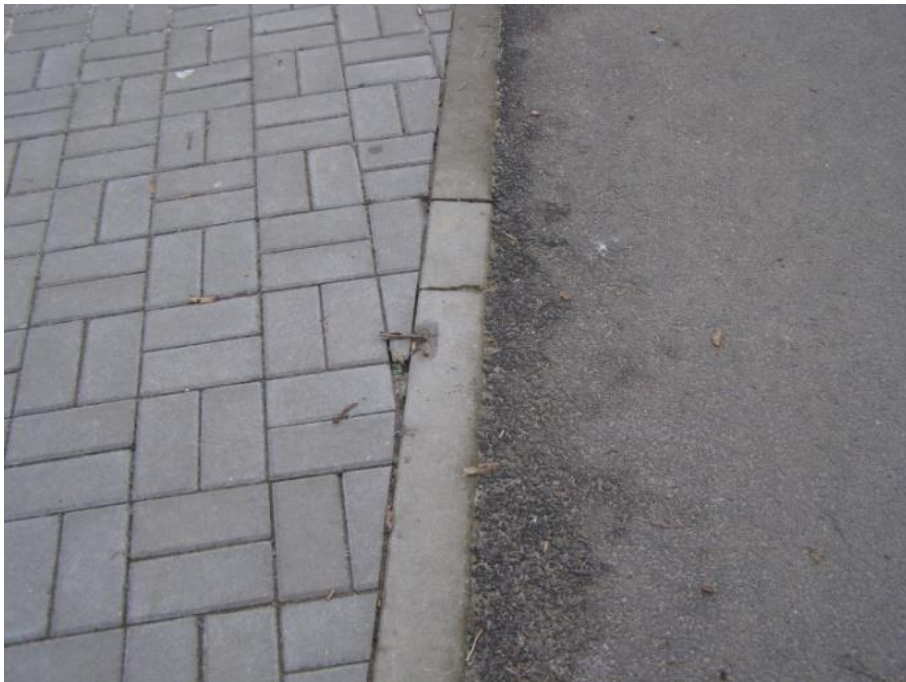
Obrázek 32 - Příklad zapuštěného obrubníku [foto Jan Matoušek]
