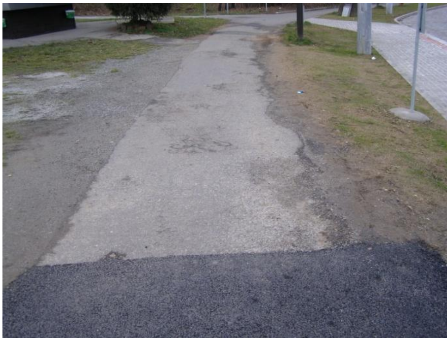
Obrázek 40 - Příklad komunikace bez obruby [foto Jan Matoušek]
