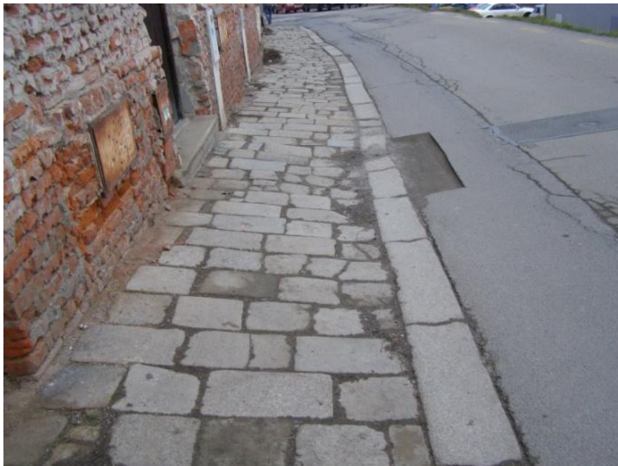
Obrázek 15 - Příklad zvlněného povrchu s velkými nerovnostmi [foto Jan Matoušek]
