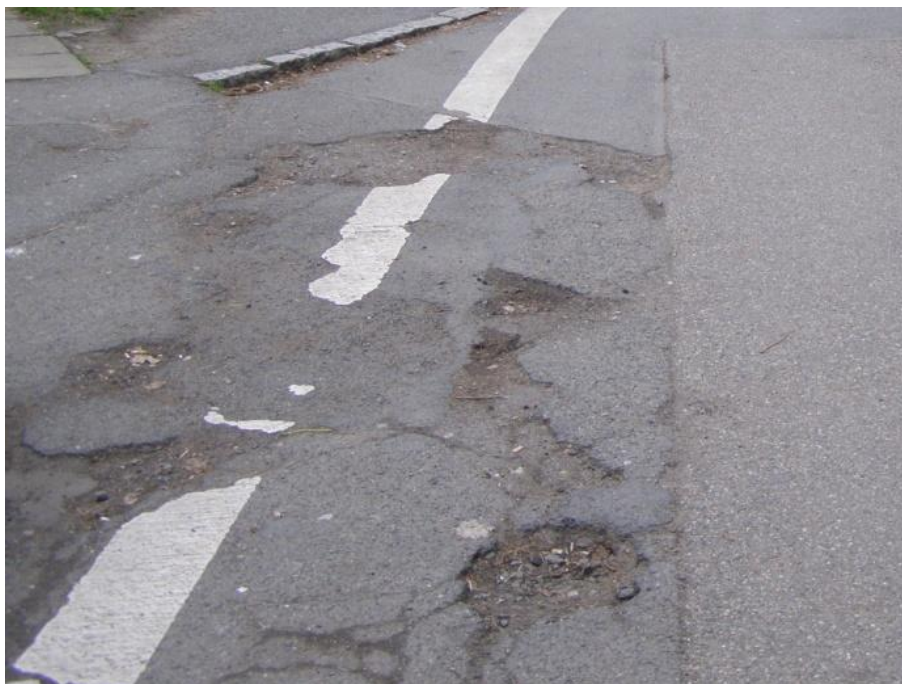
Obrázek 18 - Příklad povrchu s většími poruchami [foto Jan Matoušek]
