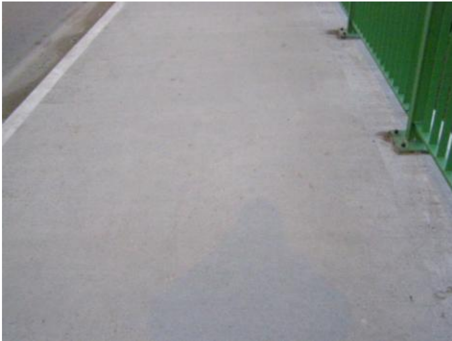
Obrázek 3 - Příklad povrchu z litého betonu [foto Jan Matoušek]
