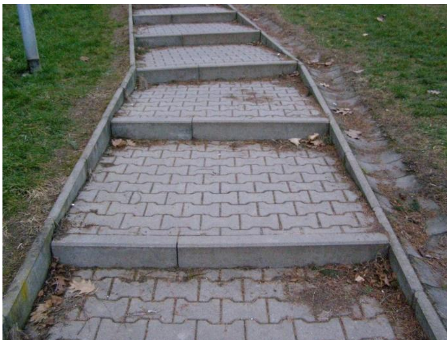
Obrázek 68 - Tzv. „jezdecké“ schodiště [foto Jan Matoušek]
