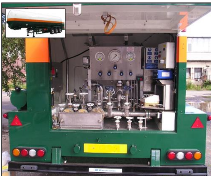
Obrázek 7. Pohled do produktového kabinetu cisternového ADR návěsu, určeného k přepravě hluboce zchlazených (kryogenních), technických plynů. Výrobce: M1Engineering, Bradford, Velká Británie [zdroj: autor].
